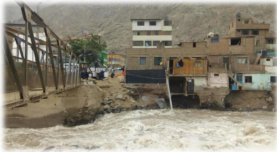
*Puente La Perla: Viviendas con riesgo de colapso por erosión fluvial*
