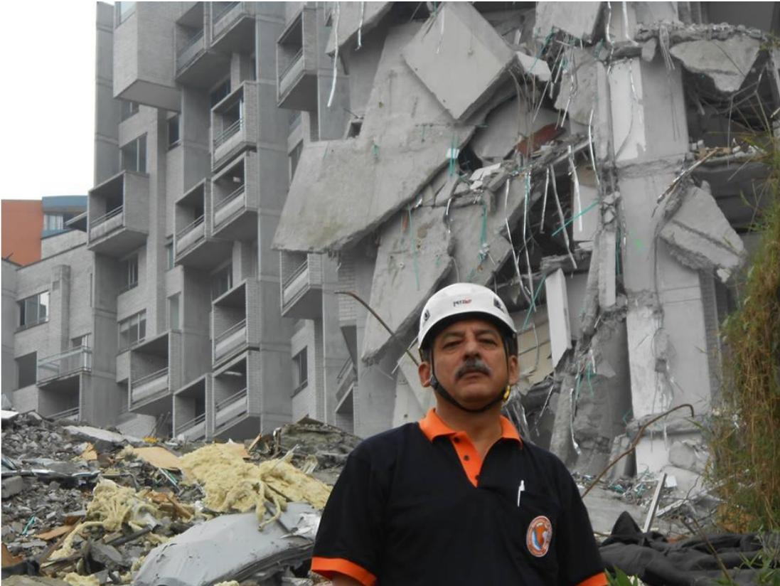
Foto superior: Recorrido por las instalaciones después de la implosión. Obsérvese las losa de concreto que forma parte de los pisos con escasos elementos de fierro.
