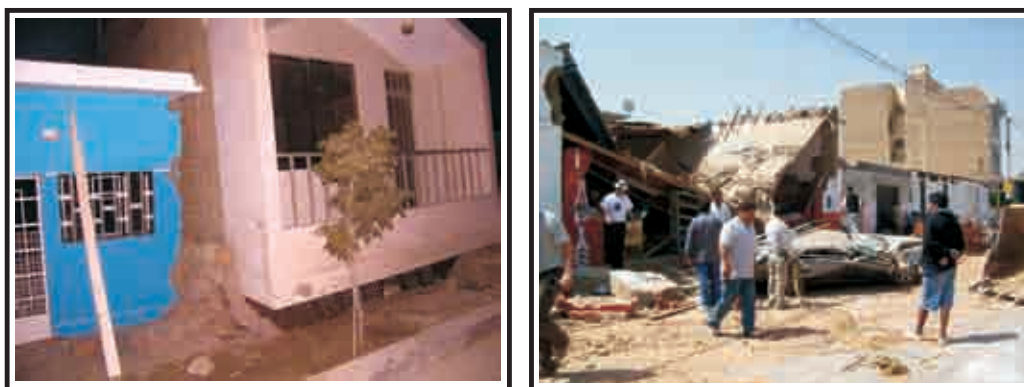
Infraestructura daada por el sismo de agosto 2007.
