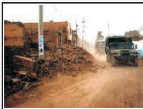
Calle de Pisco, luego del sismo.
