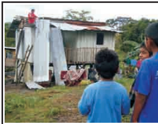
Pobladores arreglando los techos de sus casas, Puyo, La Merced - Huánuco.
