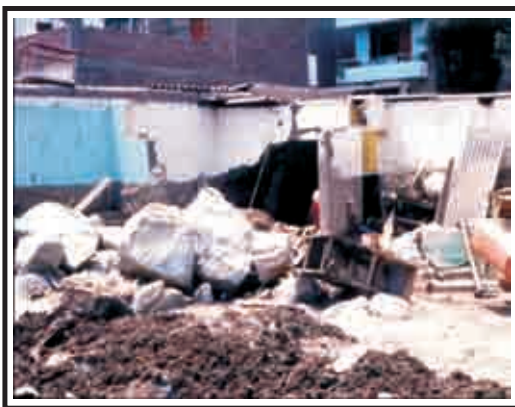
Vivienda afectada por huayco.
