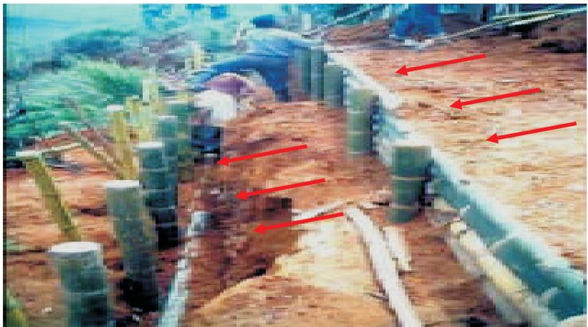
**Disipadores de energía escalonados, usado en laderas**
