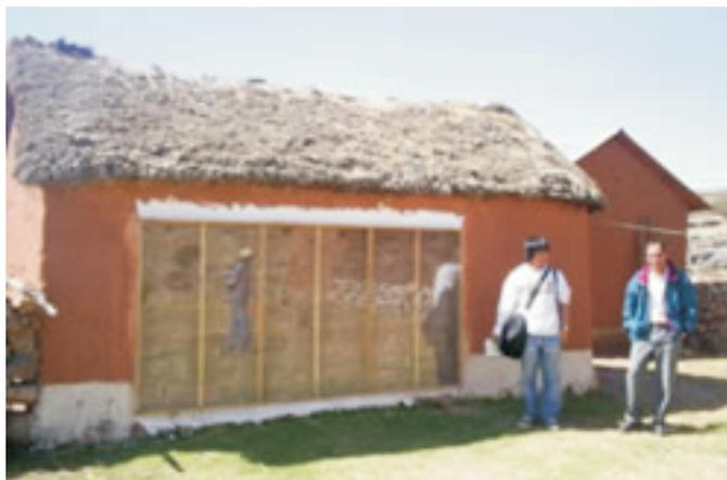
***Muro trombe vertical instalado en una vivienda de adobe, uno de los seis prototipos experimentales que SENCICO construyó Ilave - Puno***
