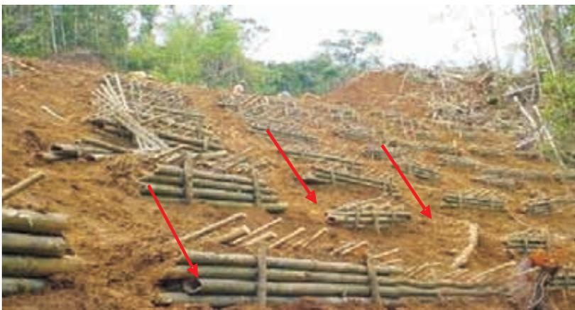
**Disipadores de energía usados en laderas**
