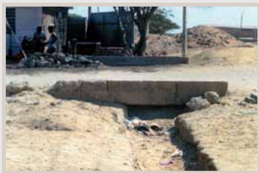
Intersección de Jr. Arequipa y AA. HH. Juan Pablo II.
