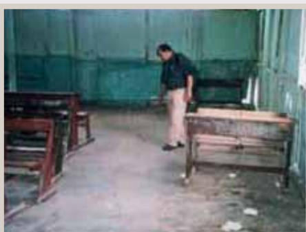
Calle de ingreso, puerta de entrada y vista interior de aula de la I.E. Ignacio Escudero.
