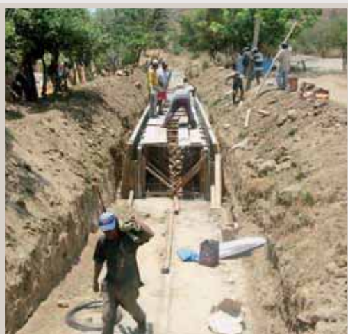
Canal Piedra El Toro, Sector La Unión: revestimiento del canal.
