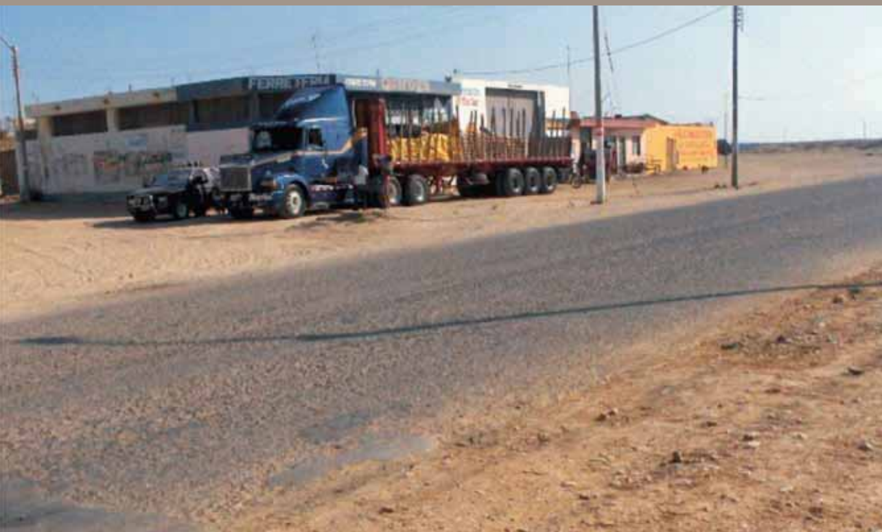
Estado actual de la Avenida Bolognesi y tipo de vehículos que la transitan.
