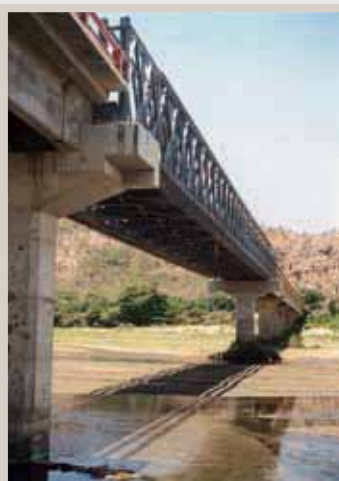
Puente Carrasquillo: se observa estructuras consideradas poco resistentes a las grandes avenidas del río Piura en años FEN.
