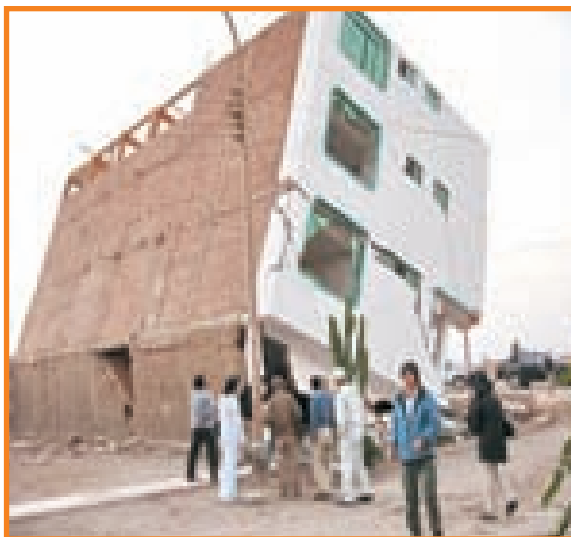
Viviendas destruidas en Pisco
