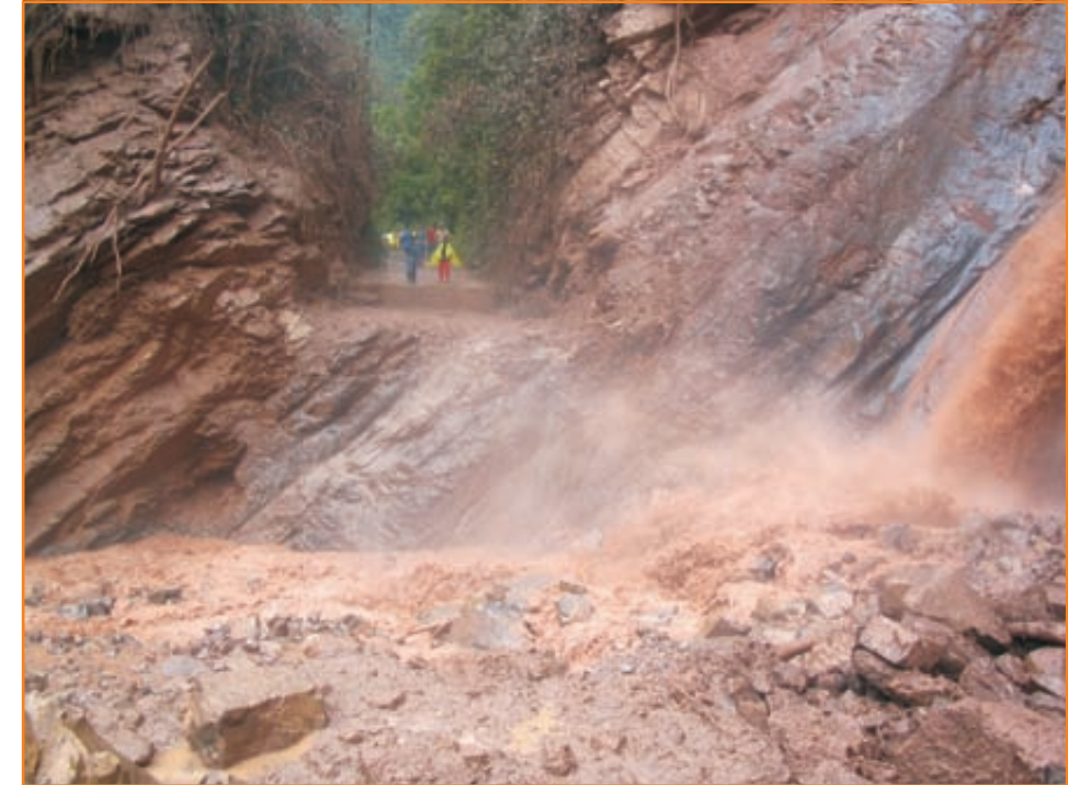
DERRUMBE DE CERRO - DISTRITO POZUZO - PROV. OXAPAMPA - DPTO. DE PASCO - 10 - 02 - 2007
