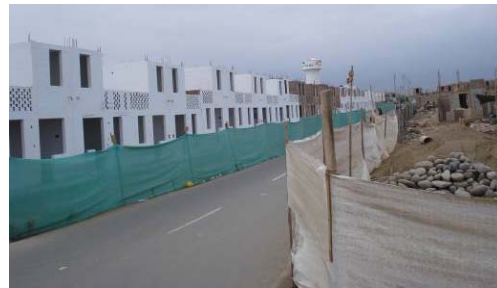
Construcciones construidas por Los Portales, en proceso de construcción y en buen estado de conservación
