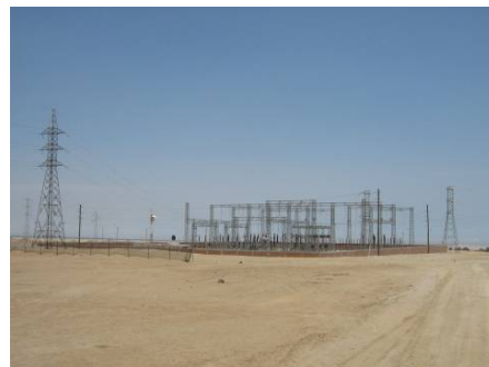
Central Eléctrica, ubicada en el centro poblado de Pauna
