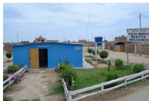
Posta de Salud ubicada en la zona urbana, construida con material no permanente.
