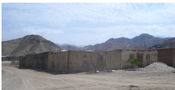
Vivienda de adobe en mal estado a consecuencia de la falta de mantenimiento y asesoramiento técnico
