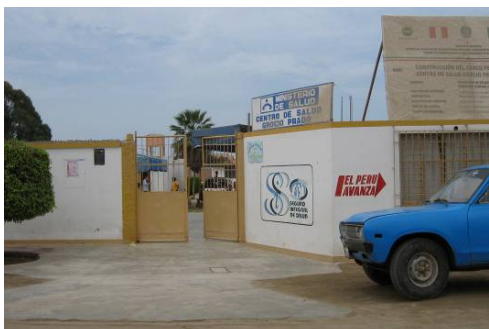
Centro de Salud de Grocio Prado, se encuentra en buen estado de conservación
