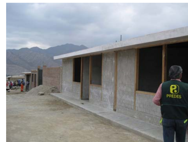
Foto 11.- Viviendas sismorresistentes de quincha, construidas de manera participativa por PREDES en sagrado Corazón de Jesús.
