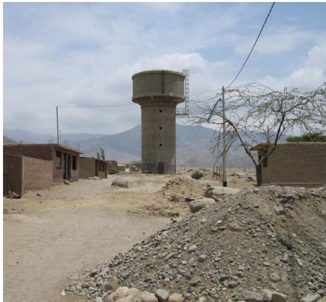
Foto 03.- Tanque de agua ubicado en Sagrado Corazón de Jesús.
