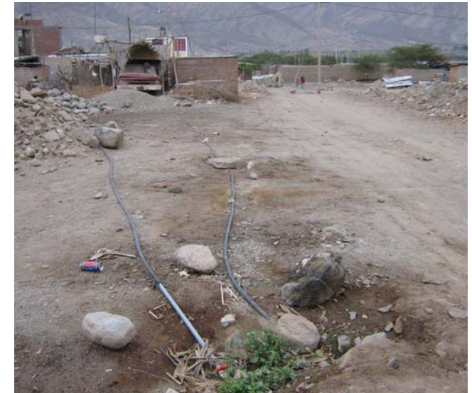
Foto 04.- Redes precarias de distribución de agua a domicilio, sin protección.
