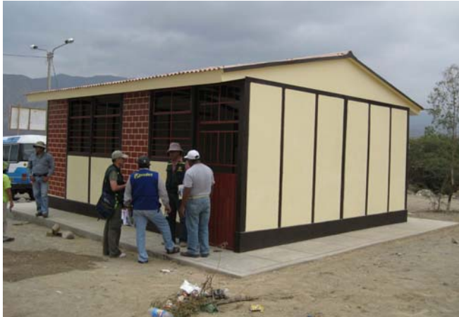
Foto 12.- Local comunal sismorresistente en quincha mejorada, para uso de la población de todo el sector.
