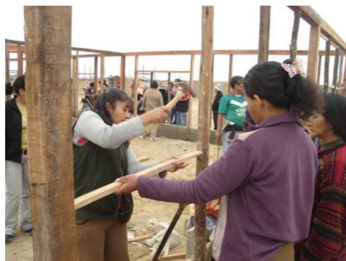
FIGURA 10: Construyendo en Señor de los Milagros
