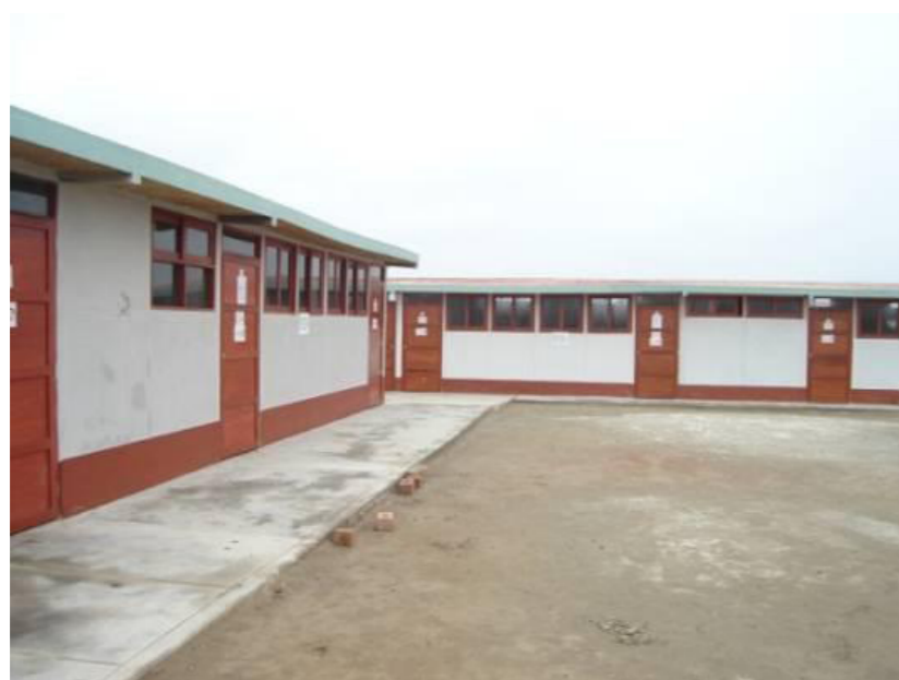
FIGURA 4: Aulas construidas con quincha
