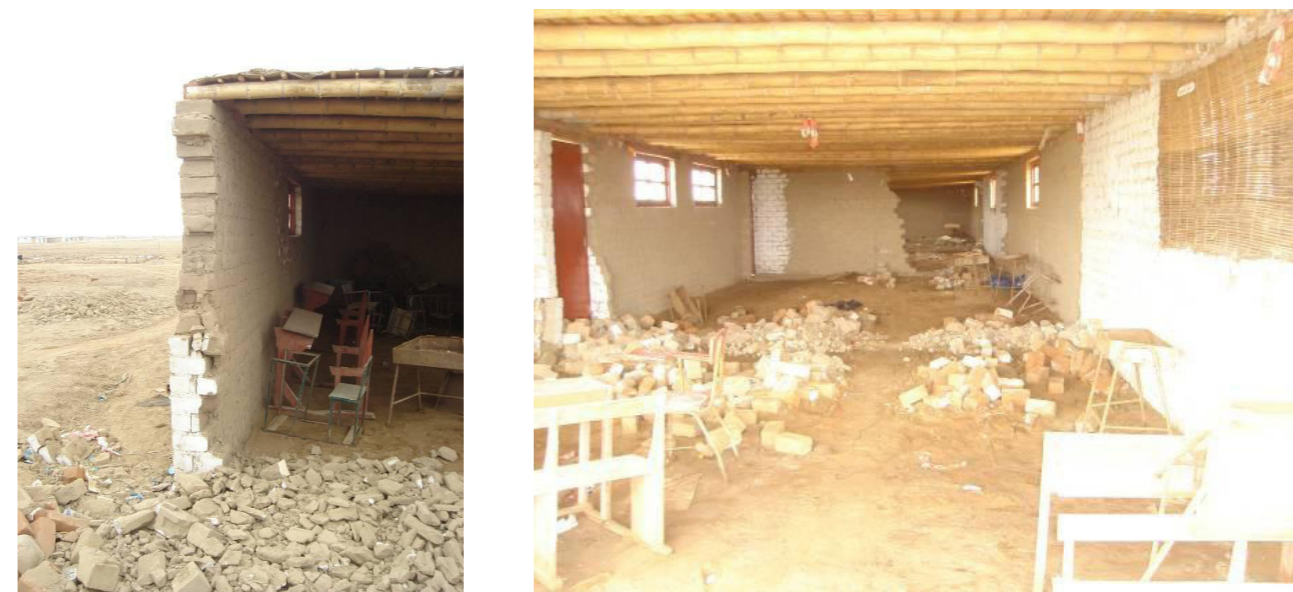
FIGURA 2: Las aulas del colegio de Nuevo Ayacucho destruidas por el sismo
