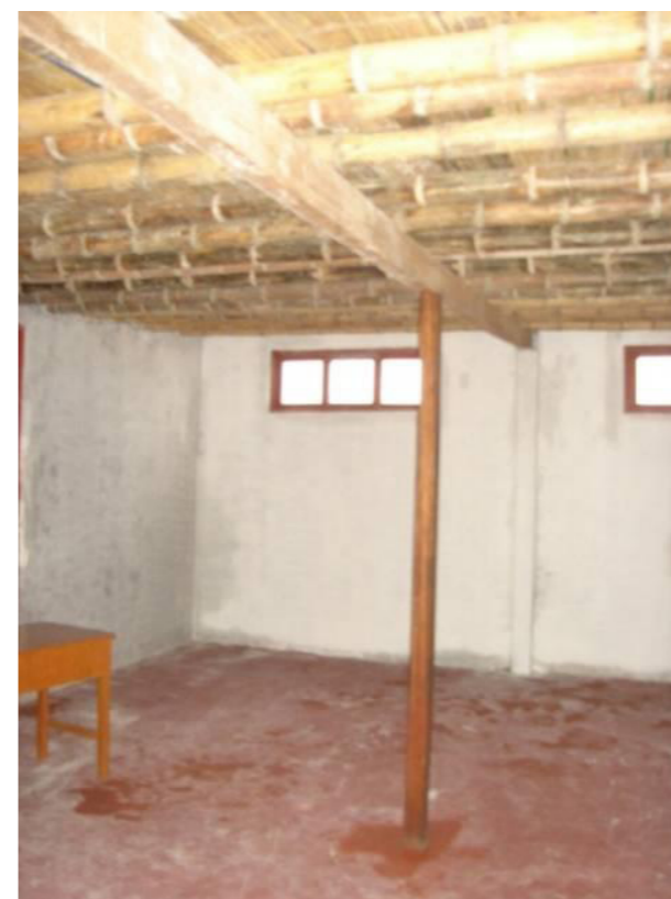
FIGURA 6: Techos de caña chancada soportada con bambú y falso techo de caña brava
