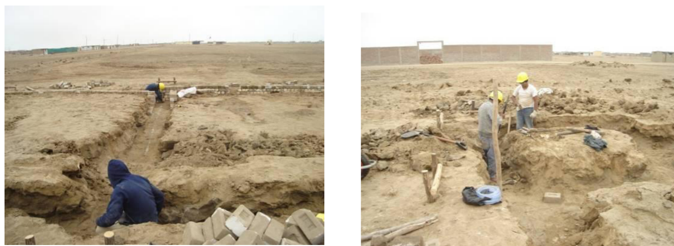
FIGURA 3: Ejecución de la cimentación de las aulas
