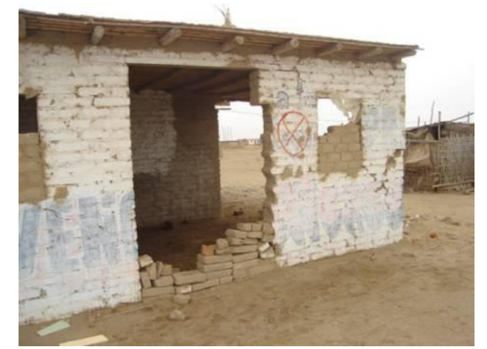
FIGURA 19: Efectos del sismo en viviendas construidas con “adobitos” (ladrillo crudo) en Nuevo Ayacucho
