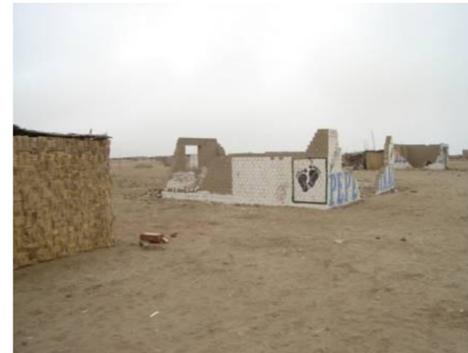
FIGURA 19: Efectos del sismo en viviendas construidas con “adobitos” (ladrillo crudo) en Nuevo Ayacucho
