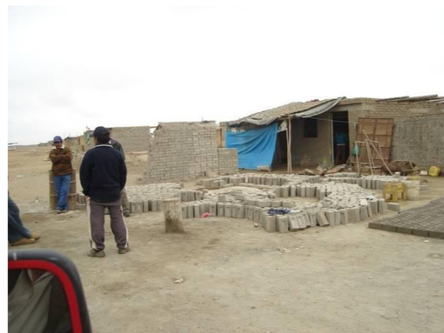
FIGURA 20: Pequeña fábrica en Señor de los Milagros donde se producen informalmente ladrillos de concreto mediante ingeniosos procedimientos
