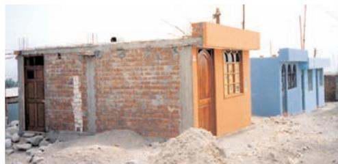
cuentan con un área promedio de 35m<sup>2</sup>, que incluye un servicio higiénico. Fueron edificadas con ladrillo hecho a máquina, cimientos, columnas y techos en concreto armado. La ejecución fue por autoconstrucción, con el apoyo de mano de obra calificada y la asistencia técnica de un profesional.
