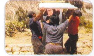
**Levantar la caseta:** Colocar la losa de base sobre la cámara abonera. Luego poner manto de lámina de zinc sobre la base, encajando el marco en una ranura de la losa. Darle forma ovalada al manto mediante tubos plásticos, que se colocan abajo y arriba. Dos tablitas auxiliares guardan la distancia de apertura del marco. Luego se coloca la losa del techo, la cual tiene las dos ranuras donde encaja el marco.
