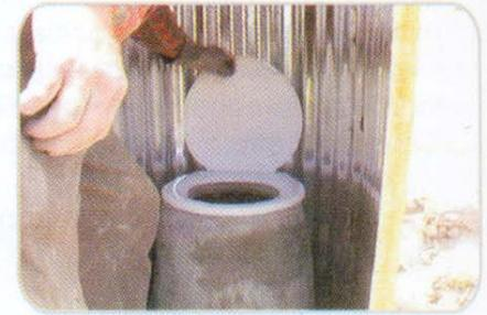
Una vez que ya está duro el cemento, se escarba la tierra y queda la taza del servicio; esa taza del servicio se instala sobre el hueco de la losa.
