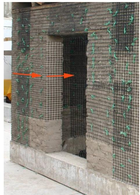
Asegurando la correcta posición de la malla se fija la malla de manera definitiva cerrando todos los conectores mediante nudos definitivos. Los nudos necesariamente deben ser dobles para evitar que los puntos de fijación se abran.
