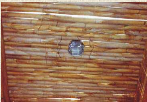
Detalle de colocación y ubicación de un centro de luz en el cielo raso.
