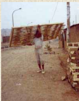
Un panel sin revestir pesa 50 kg.
