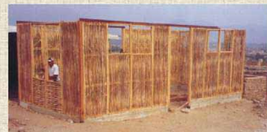
Se deberá recortar los extremos de las columnas a nivel de los paneles.
