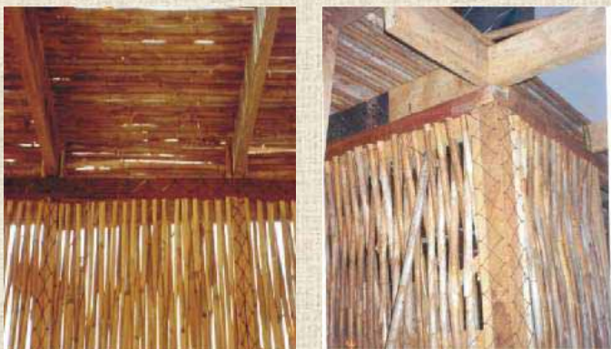
Se colocara una malla de alambre para asegurar el revestimiento sobre la madera de los paneles.
