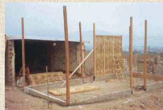
Una vez fijada las columnas de madera se iniciará el montaje de los paneles.
