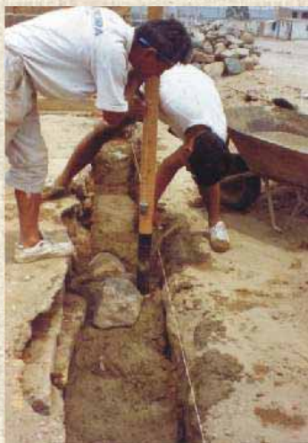
Verificar la verticalidad de las columnas con el uso del cordel y la plomada
