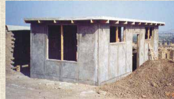
Módulo con el tarrajeo concluido.
