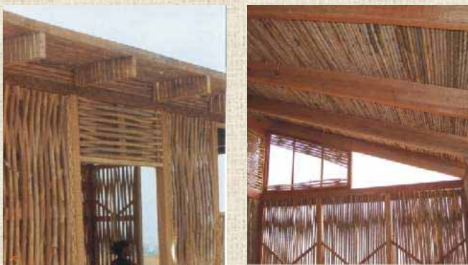
Detalles de los encuentros entre paneles muro y techo.
