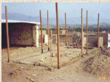
Columnas de madera plantadas en el cimiento ya vaciado.
