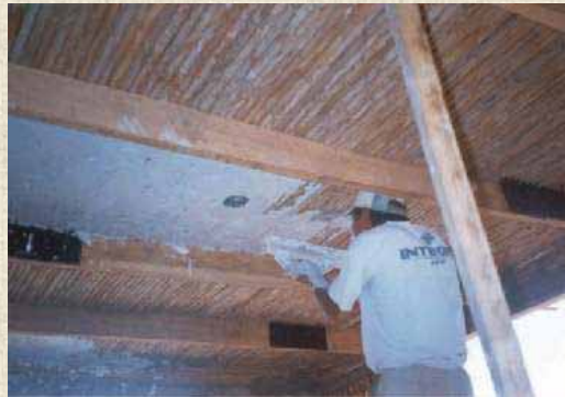
Enlucido interior del cielo raso.
