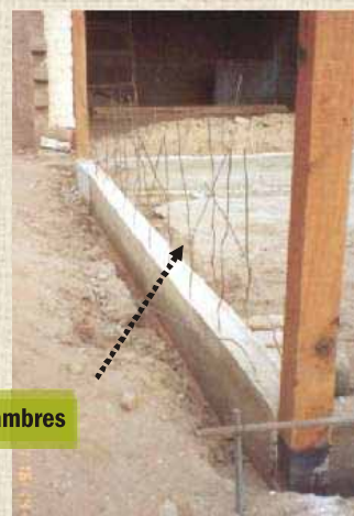
Para anclar los paneles se podrán utilizar alambres fijados en el sobrecimiento.
