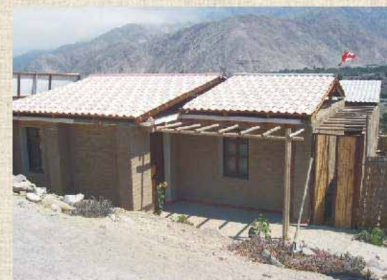
Vivienda Unifamiliar: primer piso de Adobe y Quincha Ubicación: Distrito Lunahuaná, Provincia Cañete, Departamento Lima.
