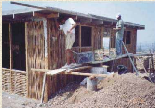
Enlucido exterior del cielo raso.
