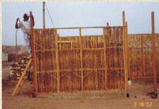
Montaje de paneles especiales 2: ventanas altas.
