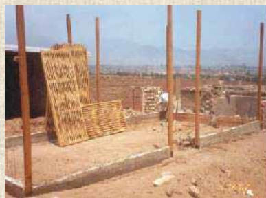
Sobrecimiento terminado, listo para recibir los paneles de quincha.
