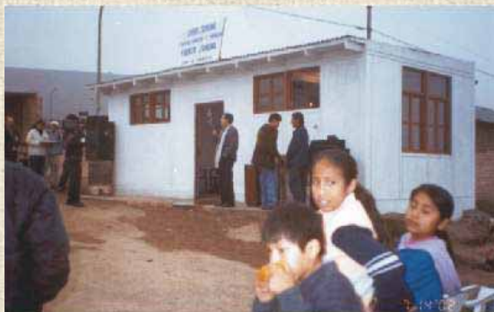
Vista exterior del módulo en funcionamiento.
