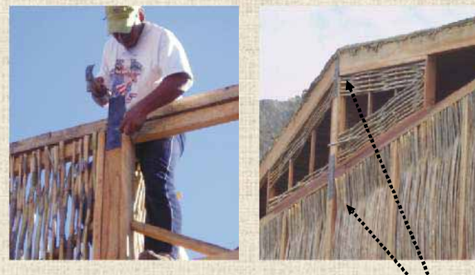
Detalles del uso de platinas como elementos conectores entre los paneles muro y los paneles tímpano.
