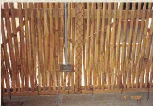
Detalle de colocación y ubicación de un tomacorriente en el panel muro.
