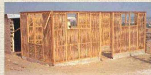
Se colocará la viga collar en el borde superior de los paneles de quincha.
