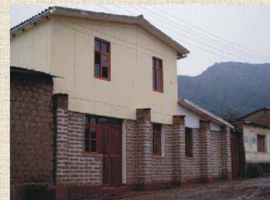
Local Comunal: primer piso de Adobe y segundo piso de Quincha Ubicación: Distrito Huac-Huas, Provincia Lucanas, Departamento Ayacucho.
