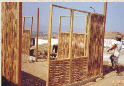
Montaje de paneles especiales 1: ventanas bajas.
