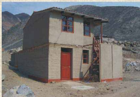
Comedor Comunal: primer piso de Adobe y segundo piso de Quincha Ubicación: Distrito Zuñiga, Provincia Cañete, Departamento Lima.
