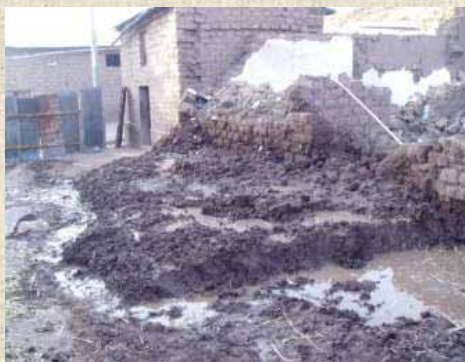
Hidratación de material reciclado.
