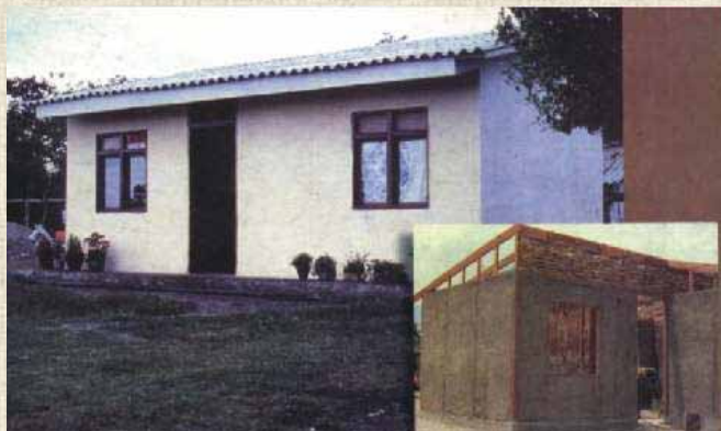
Casa terminada de una planta con techo inclinado y cubierta de calamina.
