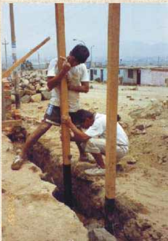
Colocación y ubicación de las columnas de madera en su lugar.
