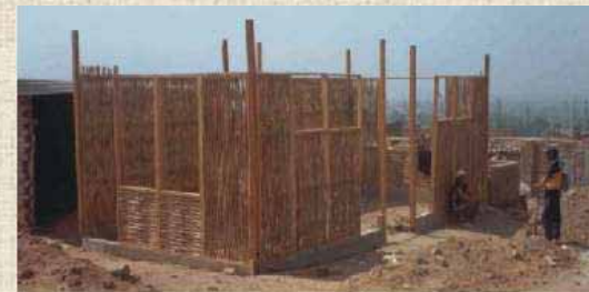
Se concluirá el montaje de los paneles en todas las longitudes de muro.
