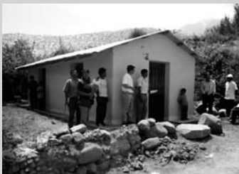
Módulo de vivienda terminado
