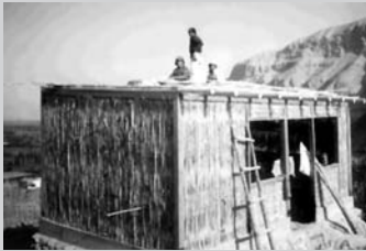
Módulo en construcción
