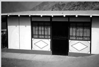
Módulo de vivienda terminado
