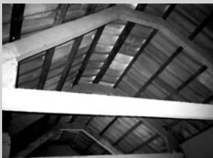
Detalles de mojinete y cobertura
