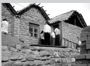
Muros reforzados y ventana
