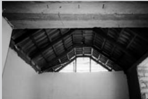
Detalle de vigas, tirantes, timpano de quincha, muro de adobe y cobertura de Qataycreto
