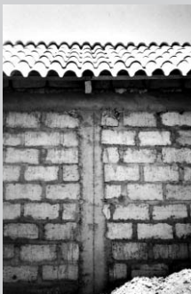
Detalle de muro y encuentro de vigas
