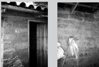
Muros de adobe
