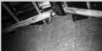
Encuentro de vigas
