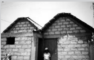
Detalle de bloqueta, vigas, típano y cobertura
