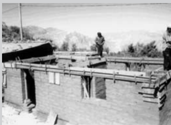
Amarre de la viga solera
