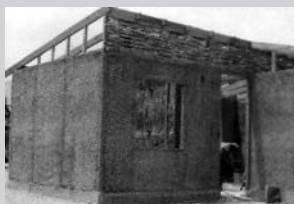
Módulo en proceso de construcción
