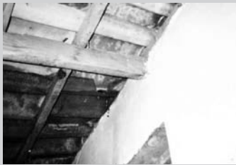
Detalle de vigas, tirantes y muro
