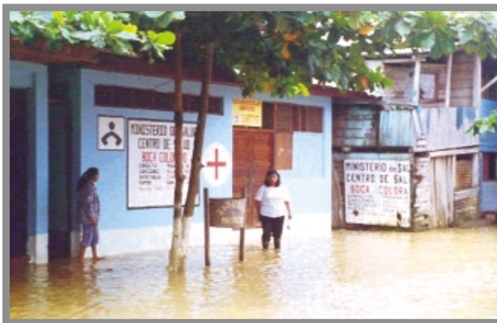
FIGURA 2 DAÑOS EN ESTABLECIMIENTO DE SALUD DEL PRIMER NIVEL DE ATENCIÓN. MADRE DE DIOS. INUNDACIONES. PERÚ. 1999.
