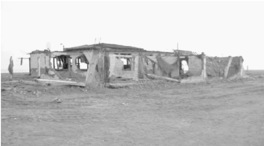
Figura # 2 Efectos del maremoto en una vivienda construida en Camaná con estructura sismorresistente
