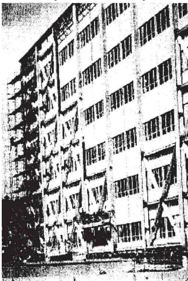
Fotografía 13. Refuerzo con diagonales
