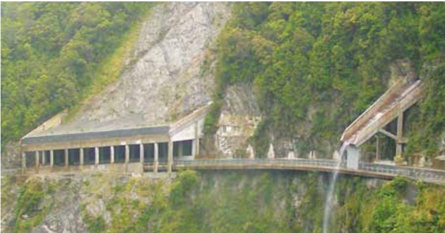
**Figura C25.** Ejemplo de cobertizo abierto contra rocas en Nueva Zelanda (Fotografía por cortesía de Richard Wright, escalador).
