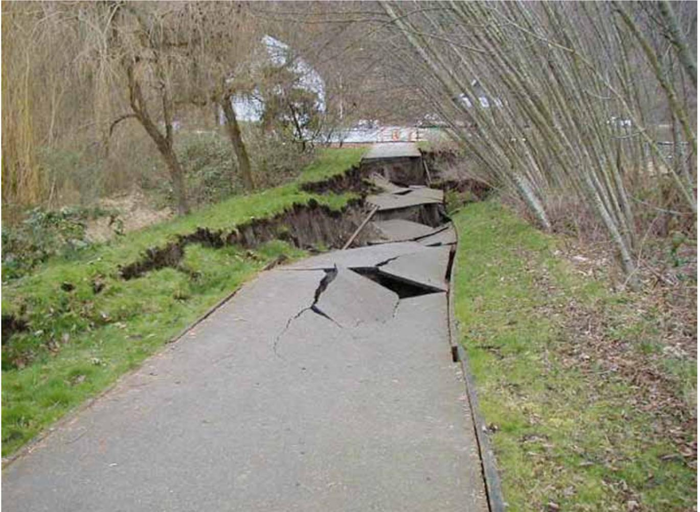
**Figura 25.** Propagación lateral daños. La fotografía muestra la zona de Puget Sound, en Washington, EE.UU., después de que el terremoto Nisqually de 2001. (Fotografía cortesía del Seattle Times.)
