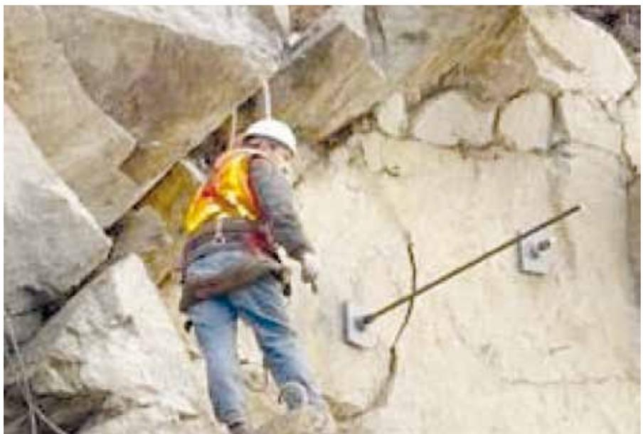
**Figura C33.** Una operación de empinado de roca; observe la roca rota (desmoronada). (Fotografía por el Departamento de Transporte del Estado de Washington, Estados Unidos).
