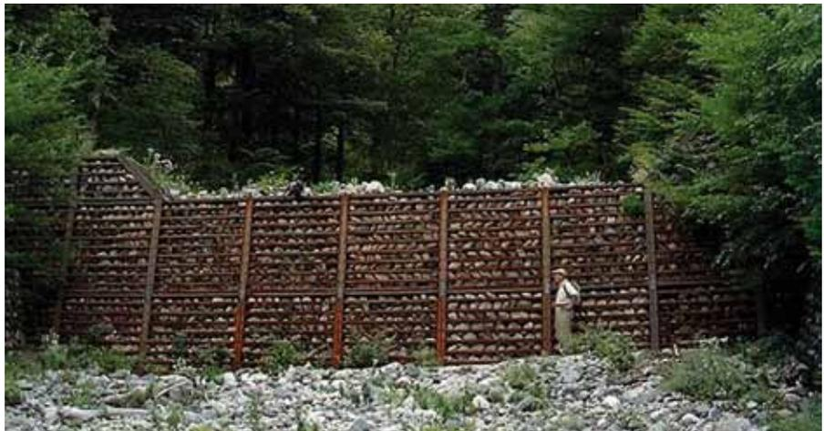
**Figura C37.** Un muro de contención de la corriente de escombros en la Cuenca de Kamikochi, Japón. (Fotografía cortesía de Gonzalo Vieira.)
