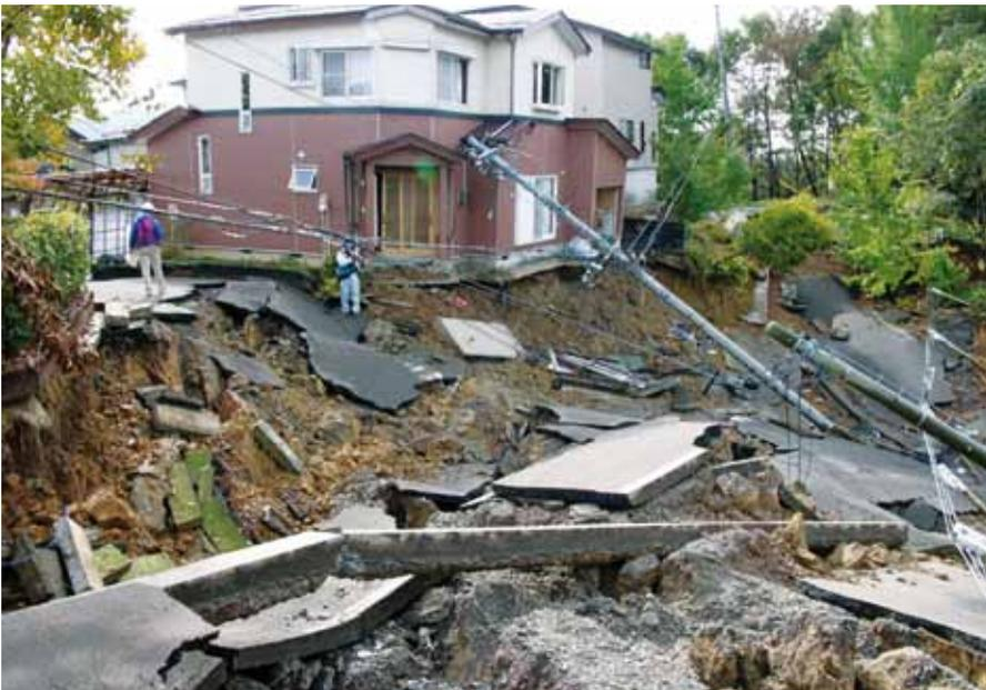
**Figura 27.** Daños inducidos por un terremoto a una casa construida sobre un terraplén artificial, después del terremoto de 2004 en la Prefectura de Niigata en Japón. (Fotografía del Profesor Kamai de la Universidad de Kyoto, Japón.)
