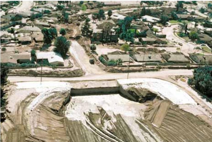
**Figura C35.** Fotografía aérea de una bacía de fluxos de detritos, construída no fundo de uma encosta, em San Bernardino, Califórnia, EUA. (Fotografia por Doug Morton, US Geological Survey).
