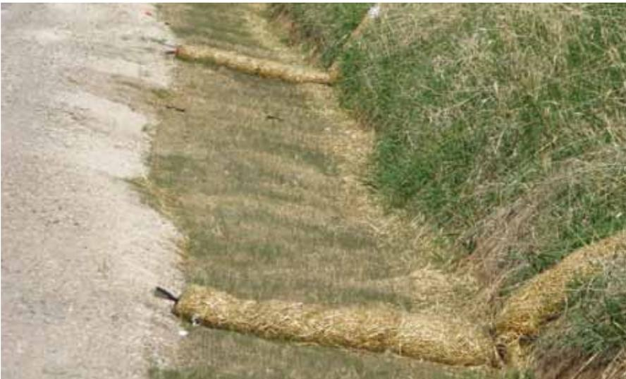
**Figura C11.** Cilindros de paja en el lado de una carretera capturan el sedimento y lo mantienen en su sitio, permitiendo que las semillas puedan establecerse y germinar, ayudando así al proceso de restablecimiento de la vegetación. (Fotografía de Lynn Highland, Servicio Geológico de los Estados Unidos.)
