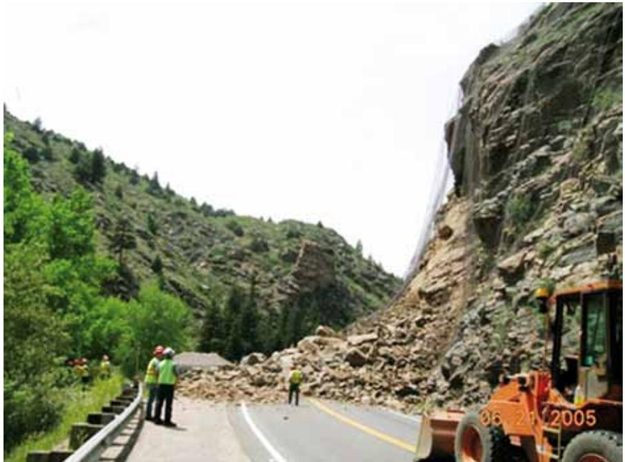
**Figura 4.** Un desprendimiento / deslizamiento de rocas que se produjo en el cañón Clear Creek, Colorado, EE.UU., en 2005, cerró el cañón al tráfico durante varias semanas. La fotografía también muestra un ejemplo de una cortina de roca, una barrera comúnmente aplicada sobre las caras peligrosas de las rocas (centro a la derecha de la fotografía). (Fotografía del Servicio Geológico de Colorado).
