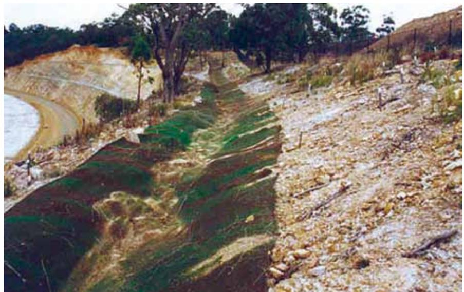
**Figura C9.** Esquema y fotografía de una zanja de drenaje. (Gráfico tomado de la Referencia 11, fotografía por el Departamento de Transportes, Energía e Infraestructura, Australia del Sur.)
