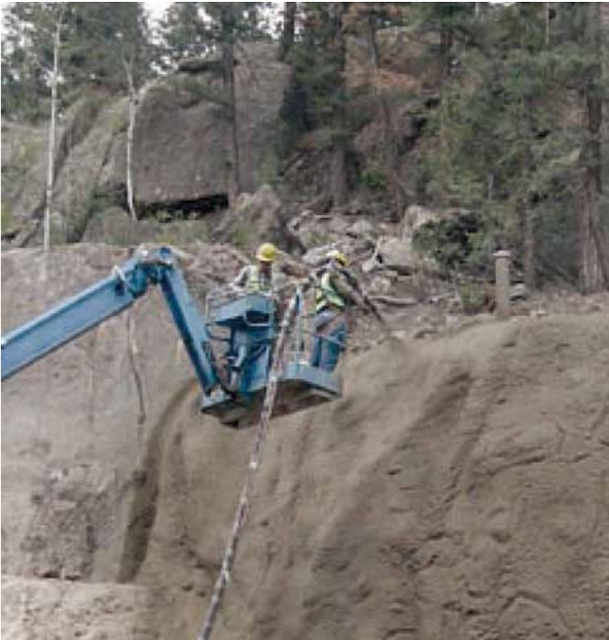
**Figura C31.** Operación de hormigón lanzado para estabilizar la zona de caída de rocas del Paso Wolf Creek en las Montañas Rocosas de Colorado, Estados Unidos. (Fotografía por el Departamento de Transporte de Colorado.)
