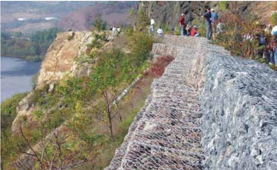
**Figura C16.** Esquema y fotografía de un muro de gaviones a lo largo de una carretera. (Esquema tomado de la referencia 11.) (Fotografía de gaviones situado en las montañas Pocono, Pennsylvania, Estados Unidos, por Lynn Highland, Servicio Geológico de los Estados Unidos).
