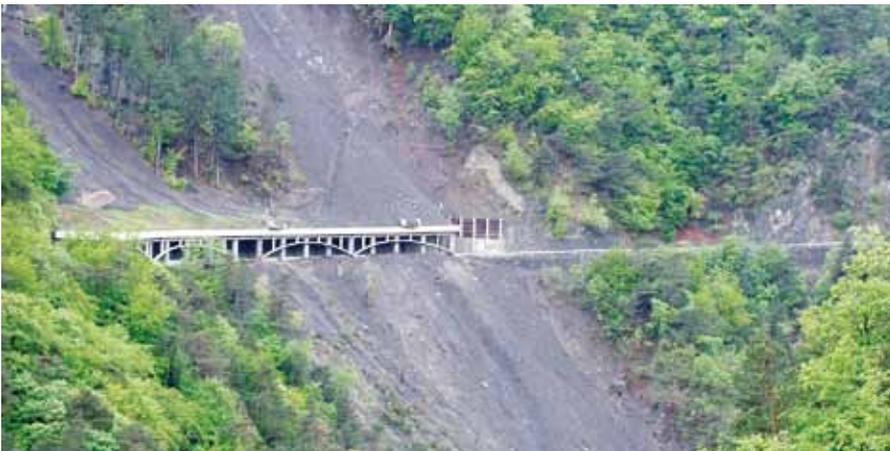
**Figura C26.** Un refugio contra aludes de rocas en la zona Montagnard de Francia. La longitud del cobertizo puede ser insuficiente, ya que una corriente de escombros que se muestra a la derecha del refugio ha dañado la carretera. (Fotografía de Dave Giles, Engineering Geology Consultancy Group de la Universidad de Portsmouth, Reino Unido).
