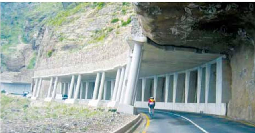
**Figura C27.** Ejemplo de una cornisa de roca reforzada, Chapmans Peak Drive, Ciudad del Cabo, Sudáfrica. Fotografía atribuida a: [http://commons.wikimedia.org/wiki/Image:Chapmans\\_peak\\_dr.jpg](http://commons.wikimedia.org/wiki/Image:Chapmans_peak_dr.jpg)
