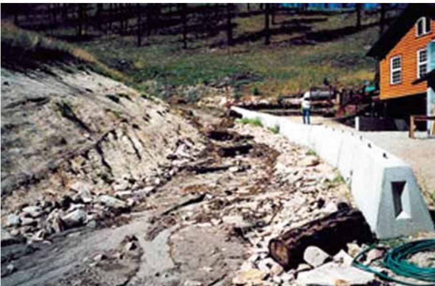
**Figura C6.** Ejemplo de revestimiento del canal del arroyo con rocas, Dickson Creek, Montana, EE.UU. (Fotografía y gráfica, Departamento de Agricultura de los Estados Unidos.).
