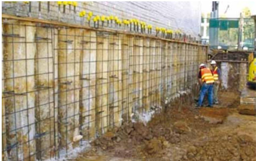
**Figura C17.** Un muro de pilotes relleno de hormigón. Se ha colgado malla de refuerzo sobre la cara de los pilotes y está lista para la aplicación de hormigón proyectado. Situado en Brighton, Melbourne, Australia. (Fotografía por cortesía de Basement Construction Services, Victoria, Australia.)
