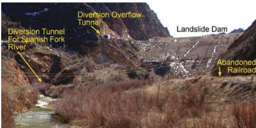
**Figura C54.** Primer plano de las medidas de mitigación adoptadas para reducir el impacto del dique contra deslizamientos Thistle, que muestra el túnel para el río y el túnel de desvío de desbordamiento. (Fotografía cortesía del Servicio Geológico de Utah).
