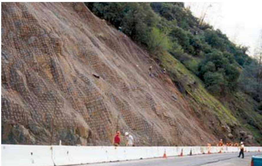
**Figura C21.** Ejemplo de malla de alambre colocada sobre una ladera rocosa de contener las rocas que pueden derrumbarse.
