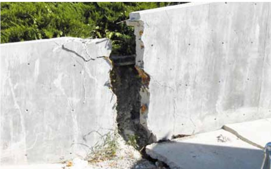
**Figura 37.** Una acera se aleja de la casa. (Fotografía por cortesía del Servicio Geológico de Utah).
