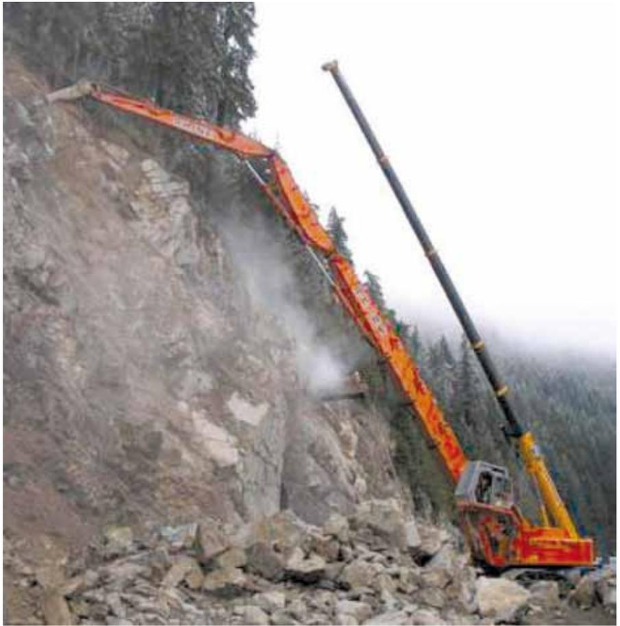
**Figura C30.** Un martillo hidráulico de roca en acción, bajando la roca de la ladera. Esta es una alternativa a bajar las rocas mediante explosivos. (Fotografía por el Departamento de Transporte del Estado de Washington, EE.UU.)
