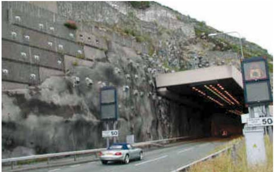
**Figura C20.** Esta fotografía muestra las medidas contra la caída de rocas que incluyen muros de contención de masas de hormigón, muros de gaviones (ambos tipos de pared están en la parte superior de la fotografía), vallas de contención, tratamientos de las rocas y refuerzos. (Fotografía del túnel Pen-y-Clip en una carretera en el norte de Gales, Reino Unido. Fotografía de Dave Giles, Engineering Geology Consultancy Group de la Universidad de Portsmouth, Reino Unido).
