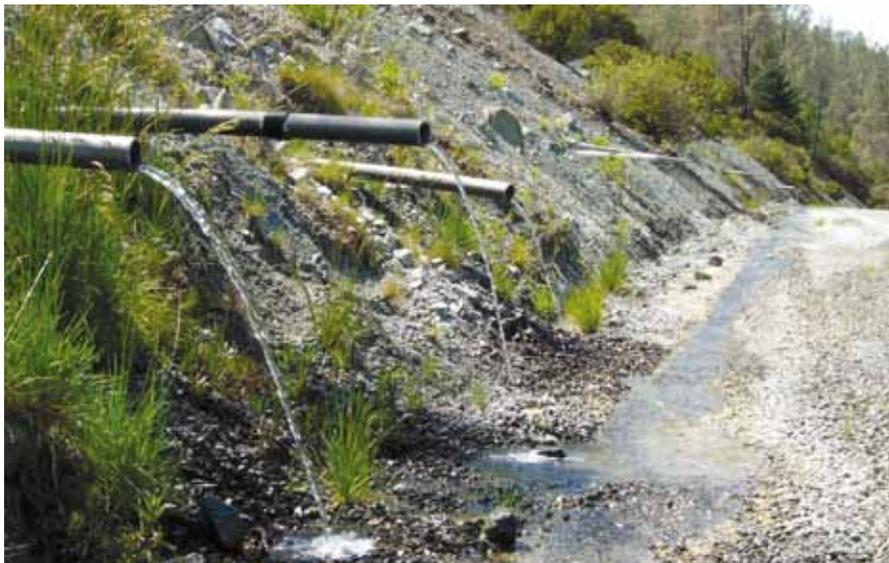
**Figura C10.** Esquema de las tuberías de desagüe. (Esquema tomado de la Referencia 11). Fotografía de tubos de drenaje en un deslizamiento de tierra en California, Estados Unidos, por Andrew Alden.
