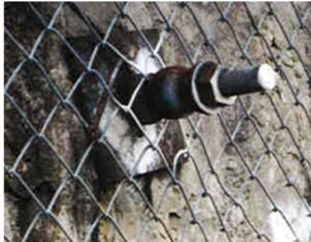
**Figura C32.** Fotografía de primer plano de un anclaje de roca en una pared de roca, con una malla sobre la superficie para ofrecer más protección. El anclaje se fija en la roca a una profundidad de aproximadamente 5 metros (15 pies).
