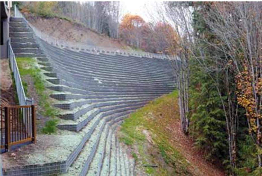
**Figura C15.** Esquema y fotografía de un muro de tierra reforzada. (Esquema tomado de la referencia 11).
