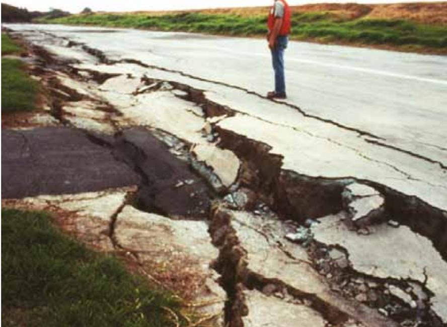
**Figura 12.** Fotografía de los daños causados por una extensión lateral en una carretera como consecuencia del terremoto de Loma Prieta, California, EE.UU., en 1989. (Fotografía de Steve Ellen, Servicio Geológico de los Estados Unidos).
