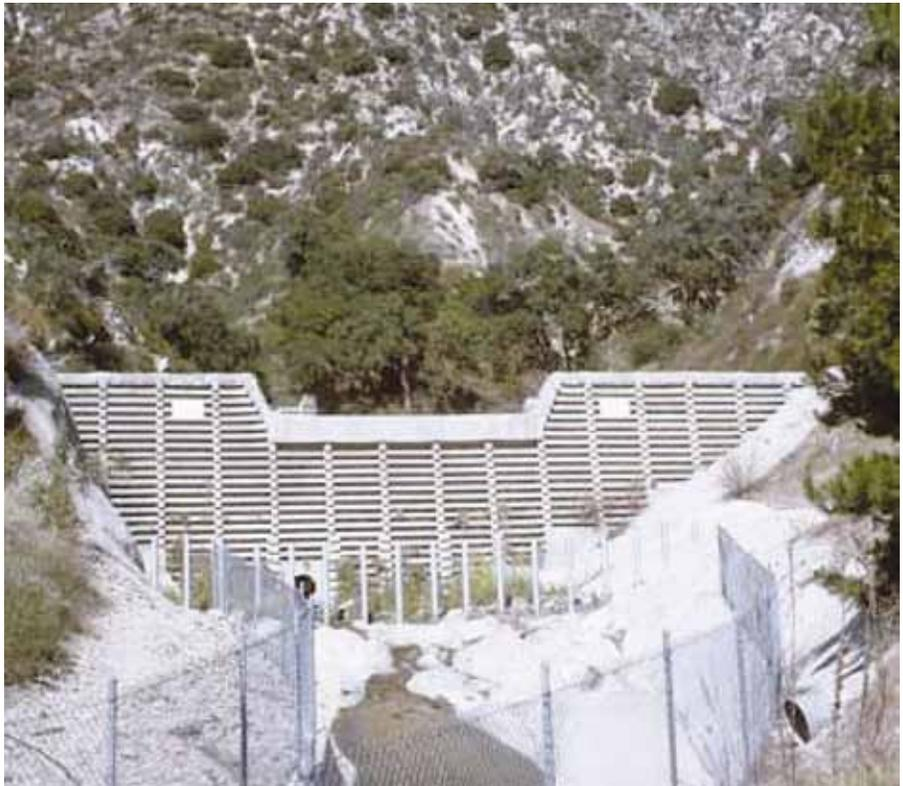
**Figura C8.** Vista aguas arriba de la presa de contención de armazón de hormigón con sección central de bajo flujo en el sur de California, EE.UU. (Fotografía del Distrito de Control de Inundaciones del Condado de Los Ángeles.)
