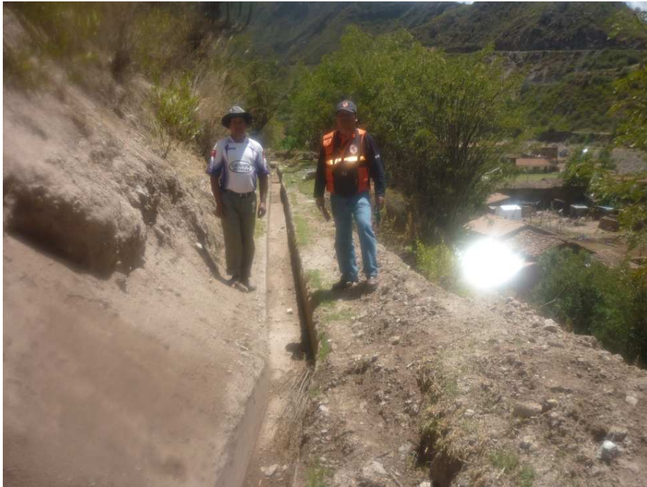
Foto 15.- Canal presenta resquebrajadura o grietas.
