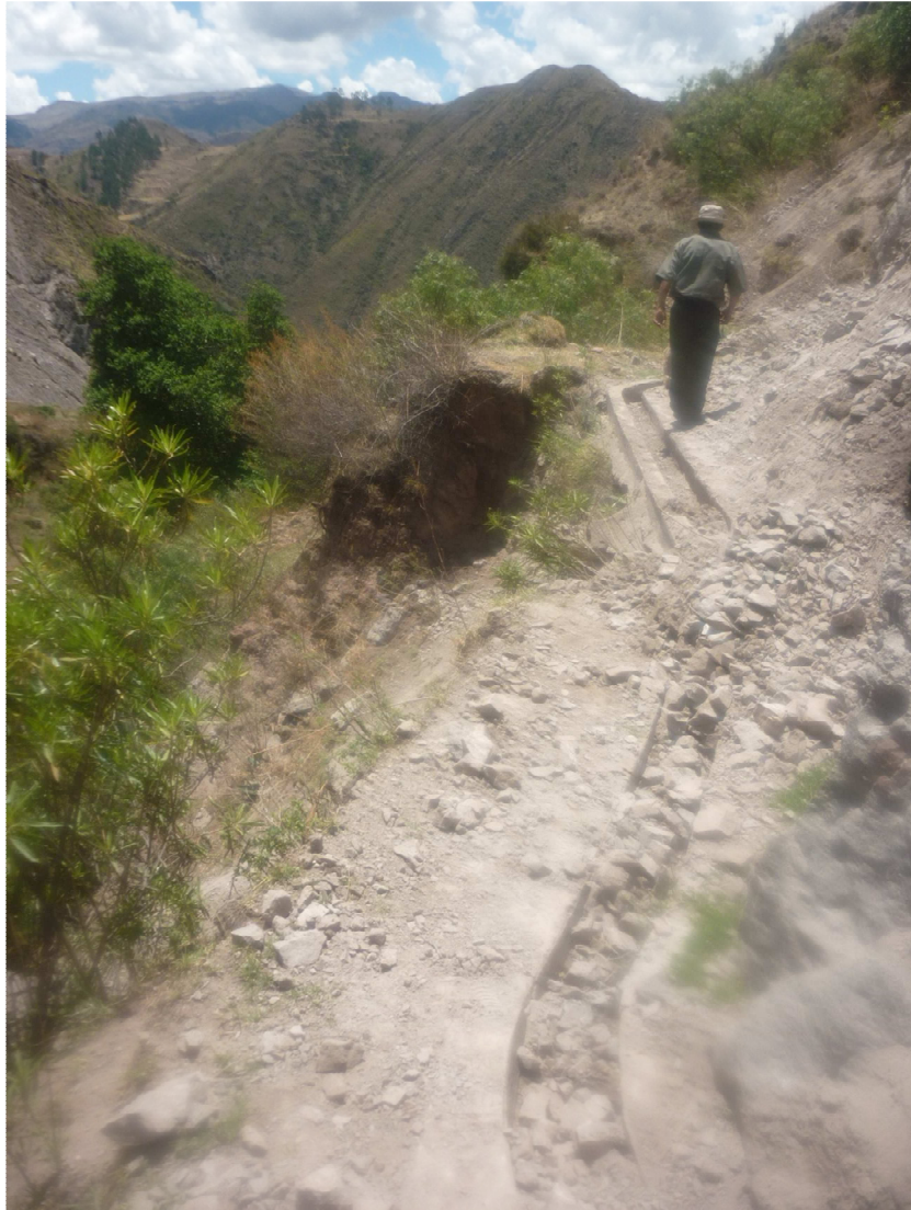
Foto 19. Canal de riego patepanco afectado en la CC-MISCA.
