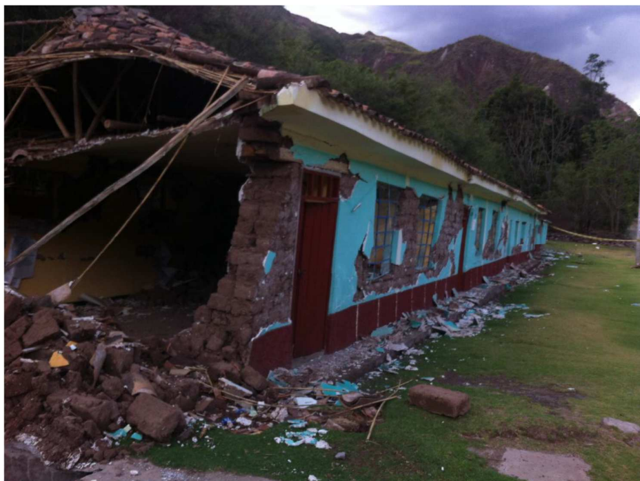
Foto 5. Aula colapsada en la CC-CUSIBAMBA.
