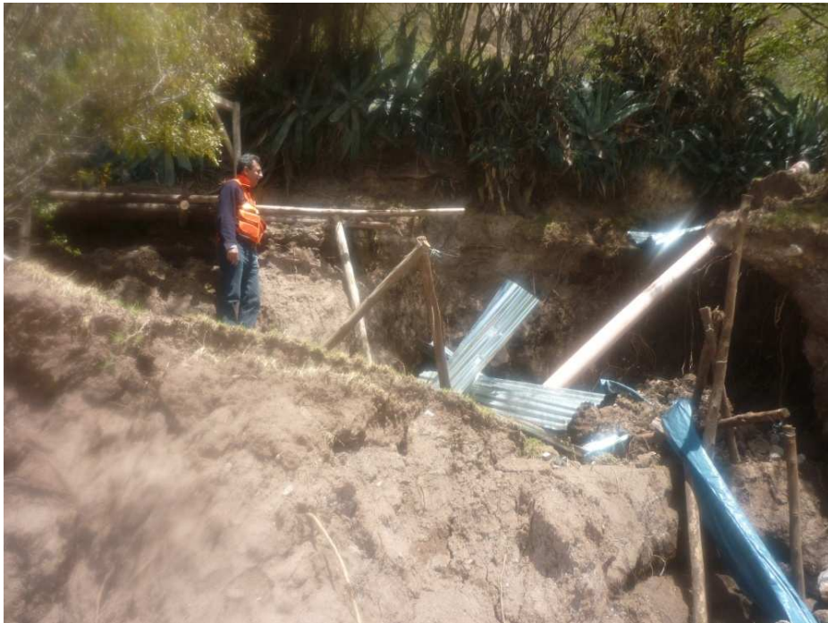
Foto 16.- Canal colapsado en un tramo aproximado de 80 ml.
