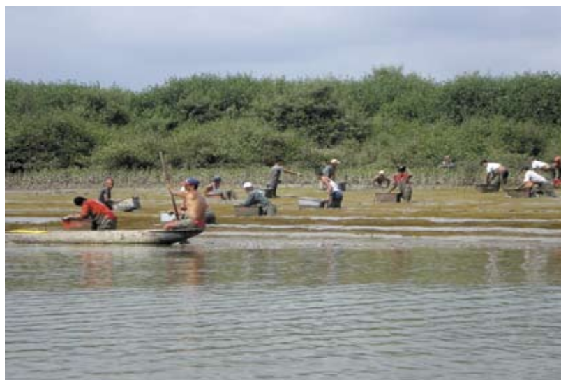
Rehabilitación de infraestructura turística y siembra de mangle - MAE
