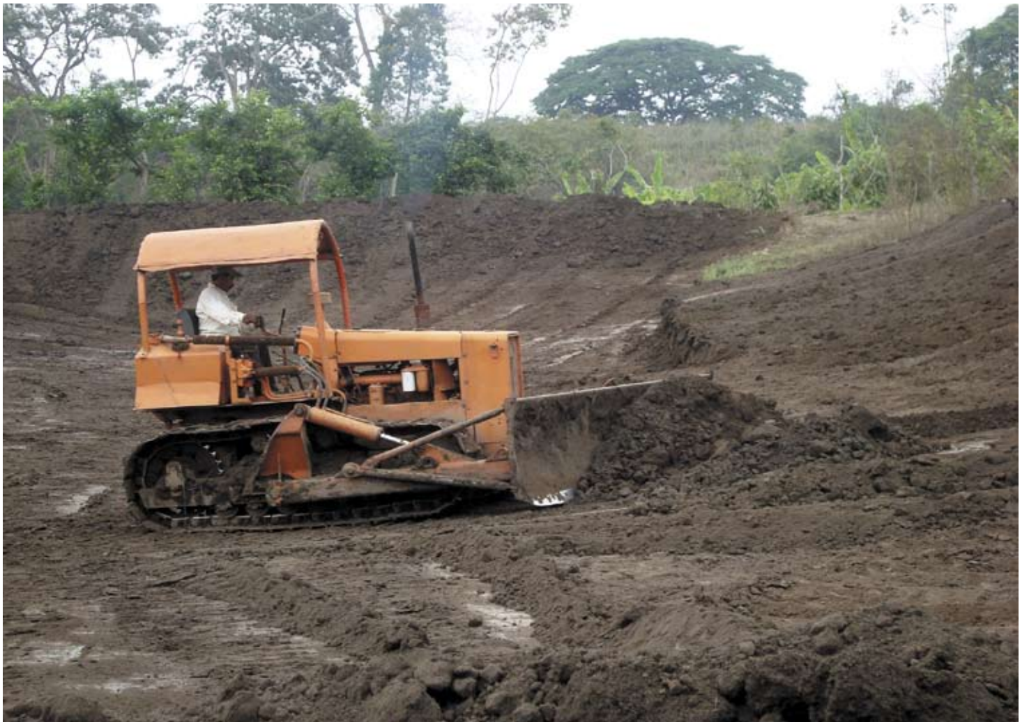
Construcción piscinas para acuicultura, Palenque - Los Ríos, Foto: Alonso Morante
