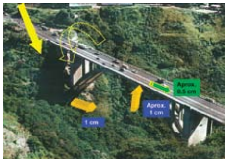
Figura A.4.6 Relación entre los desplazamientos en la estructura, debido al empuje del macrodeslizamiento.
