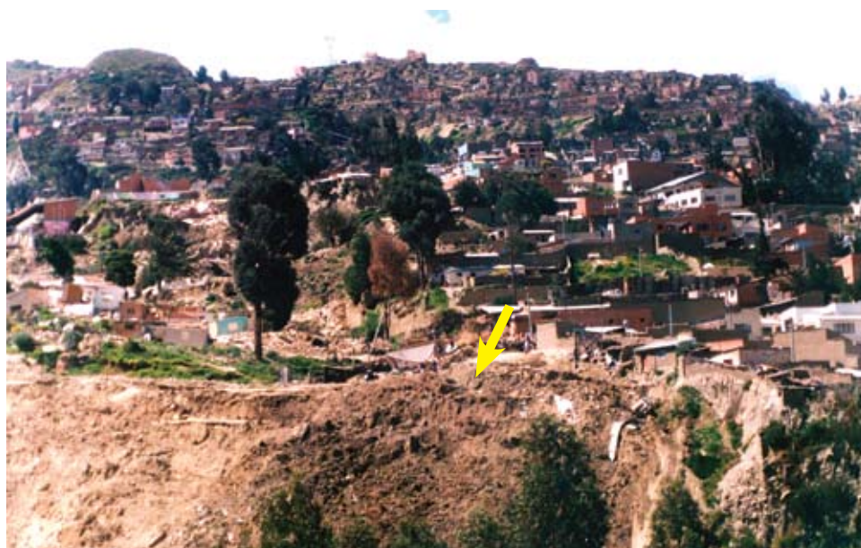
Figura A.5.4 Vista del segundo deslizamiento rotacional de San Isidro, que destruyó gran parte de las viviendas del sector. Se observa el desnivel y el hundimiento en la cabeza del deslizamiento rotacional. El material de color rojo, fue extraído de un banco de préstamo con el que se pretendía generar una cuña al pie del deslizamiento, trabajo que finalmente no se ejecutó debido al colapso total de la ladera.
