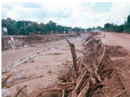
Figura A.21.10 Vista de la cárcava, que muestra sus altas escarpas de erosión y los daños en la ruta provincial número 6.
