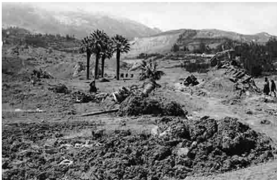
Figura B.4.8 Superficie de los detritos de 1970 enterrando la Plaza de Armas en la Antigua localización de Yungay. Las famosas Cuatro Palmeras fueron enterradas hasta una profundidad de 5 m. Nótese las características de los depósitos de detritos de grano fino y la ausencia de grandes bloques de rocas (Fotografía de G. Plafker, USGS).
