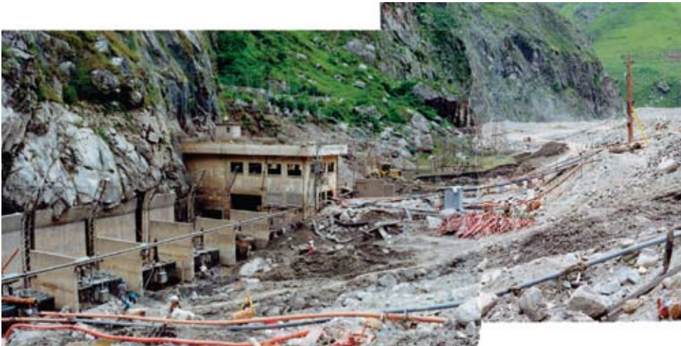
Figura A.25.4 Vista del edificio de Control de la Central Hidroeléctrica de Machu Picchu en donde se observa la intensidad de los daños. Por las ventanas ingreso el agua y lodo que daño la casa de máquinas (subterránea).
