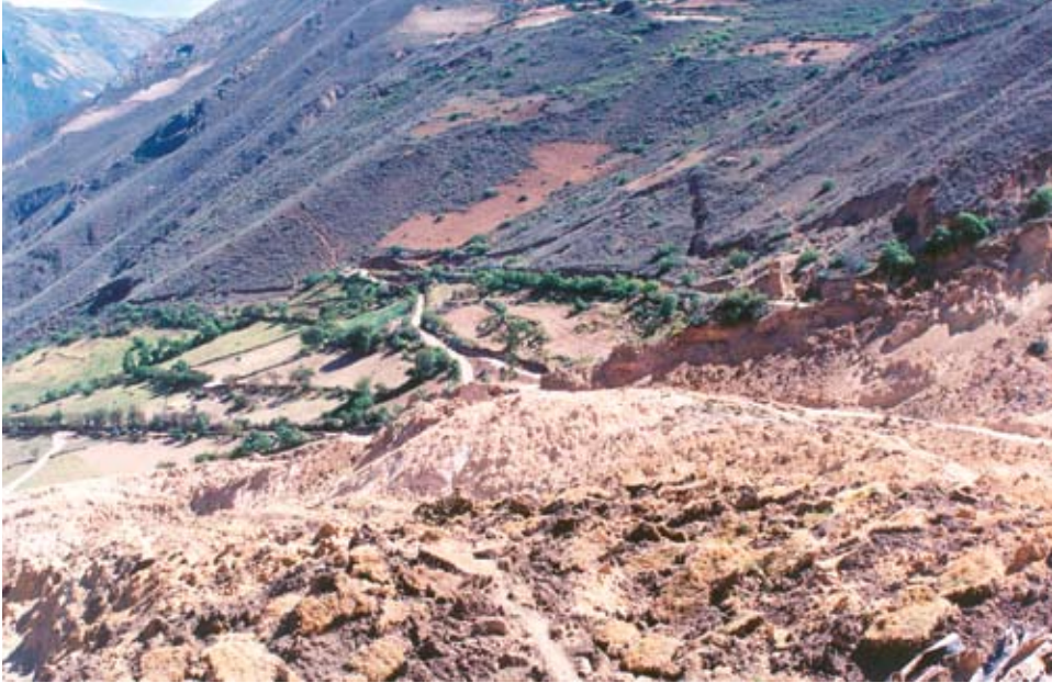
Figura A.16.6 Vista del sector de Auyos donde se distingue el escarpe antiguo que constituyó la zona de arranque del deslizamiento.
