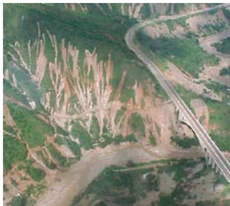
Figura B.2.6 Fotografía tomada después del evento de diciembre 1999, mostrando los típicos deslizamientos en forma de flujos traslacionales. Ladera adyacente a Autopista Caracas-La Guaira.
