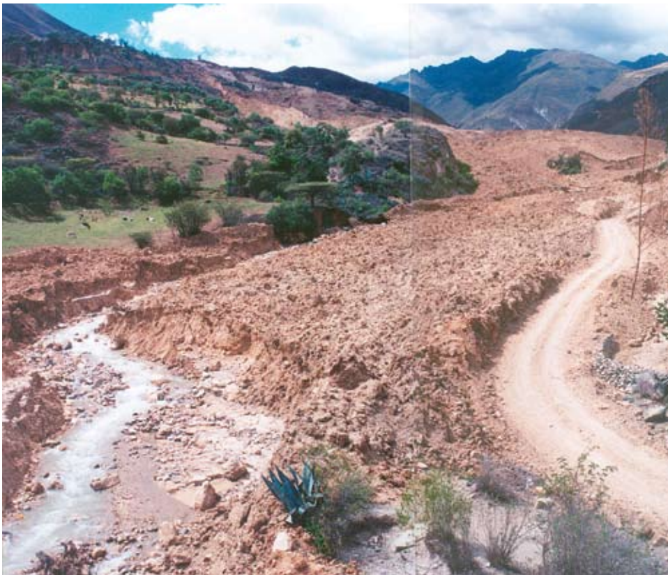
Figura A.16.4 Cauce aguas abajo de Tollos que fue abierto por el río después del embalse. Se distingue la naturaleza del material, el espesor del depósito y la altura del embalse.
