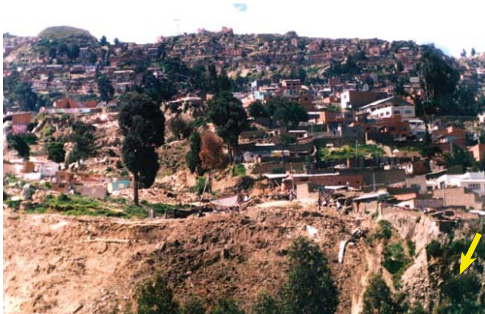
Figura A.7.2 Vista general de la margen izquierda (Sur Este) del deslizamiento de Cuarto Centenario. Al fondo se aprecia parte de la edificación del Colegio Pedro Bóveda que fue parcialmente destruido.
