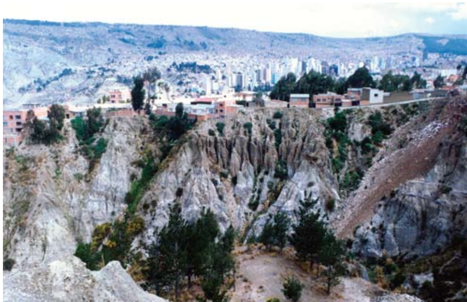
Figura A.5.1 Vista general de la calle Donoso Tórrez en la zona San Isidro, antes del primer deslizamiento. Se observa la intensa erosión en los depósitos de grava, los cuales delimitaron el plano de rotura. La erosión diferencial desarrolló altas pirámides de gravas que por la fuerza de la gravedad arrastraron el resto de los materiales y viviendas.
