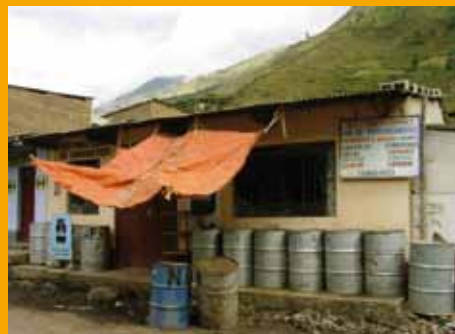
Santa Teresa - Peligro de explosión
