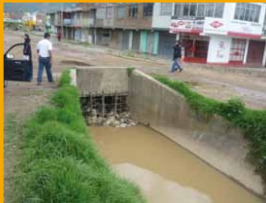
Residuos sólidos en canal CIMIRN
