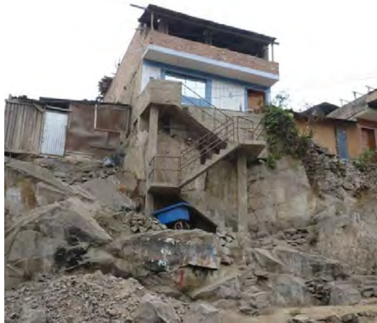
La consolidación de viviendas de albañilería confinada en pendiente. Balcones y fachada sin vigas de amarre – Arenal Alto
