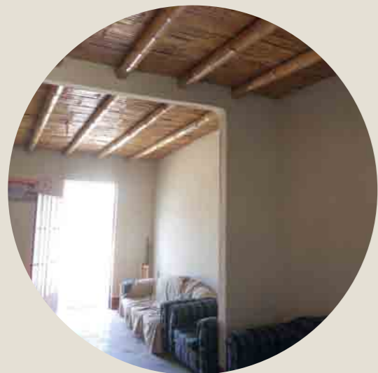
Vista interior del espacio de usos múltiples en una vivienda en Pampa Mendoza Fuente: MPM
