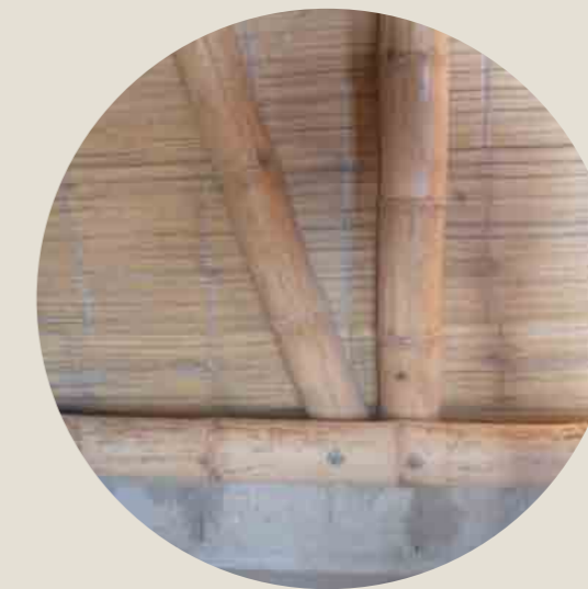
Detalle de encuentro entre las columnas de bambú y el sobrecimiento de concreto Fuente: MPM
