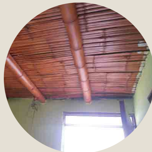
Detalle del cielo raso Vivienda en Chacarilla Fuente: MPM
