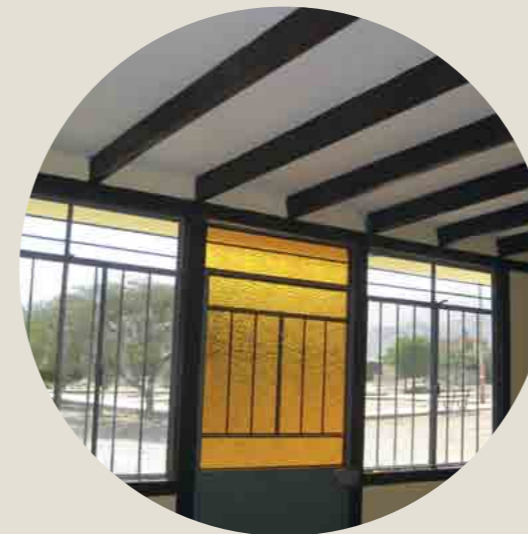
Vista interior de encuentros entre la viga solera, las viguetas y el cielo raso de superboard Fuente: Archivo PreDES
