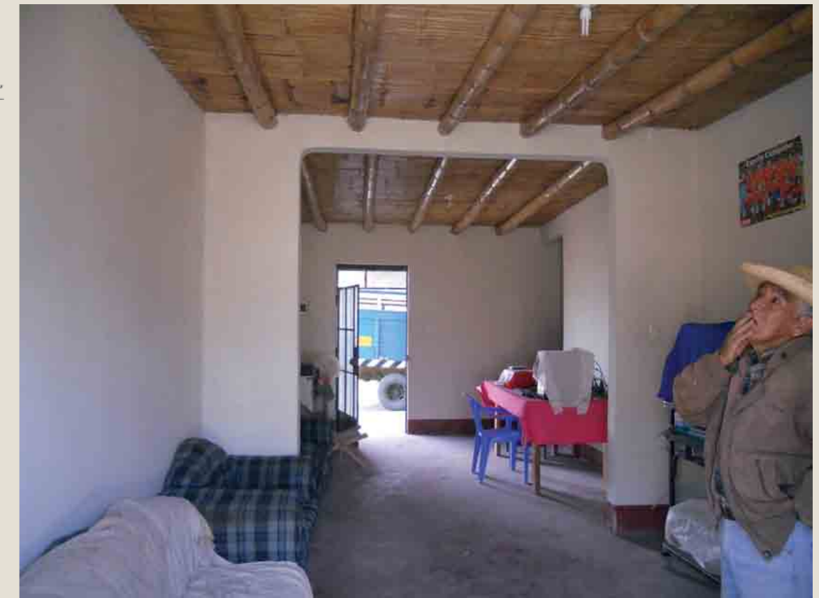
Vista interior del espacio de usos múltiples en una vivienda en Pampa Mendoza Muros de quincha mejorada y techos de caña Fuente: MPM
