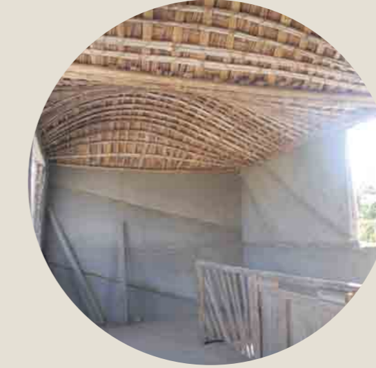
Vista interior de la ampliación en una vivienda en el centro poblado Cabeza de Toro Fuente: MPM
