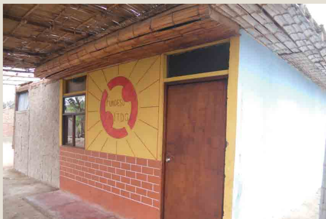
Acabado de una losa exterior de caña y ramada Vivienda en Chacarilla Fuente: MPM
