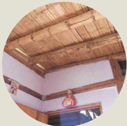
Detalle del encuentro de la viga solera y el techo de caña Fuente: MPM
