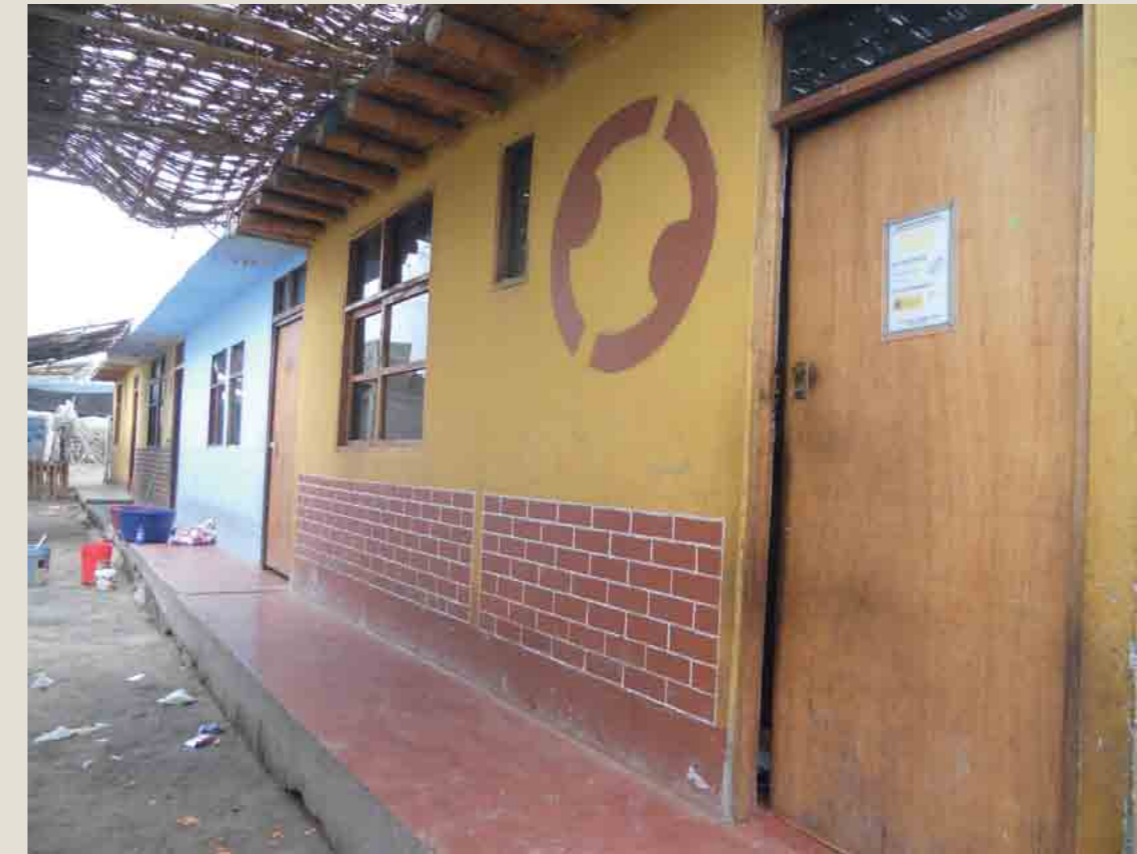
Vista peatonal de viviendas en Chacarilla Fuente: MPM
