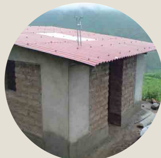
Proceso constructivo con reforzamiento de encuentros en una vivienda en Colcabamba Fuente: Archivo Cáritas
