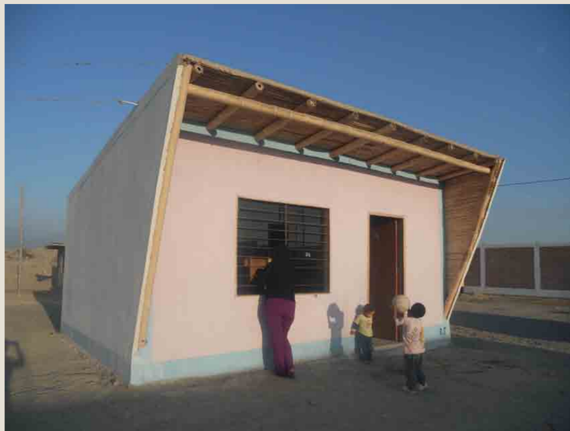
Vista exterior del centro comunitario del centro poblado 24 de Enero Fuente: MPM
