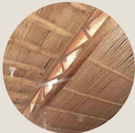
Detalle del tijeral en el interior de una vivienda en El Huarango Fuente: MPM
