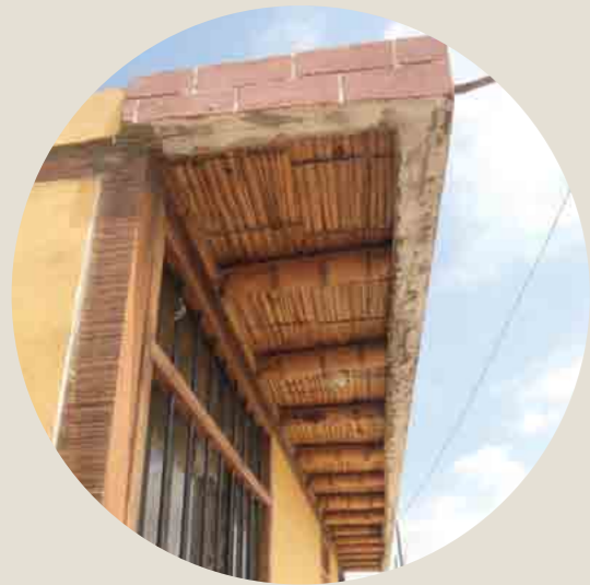
Detalle del volado exterior Vivienda en Chacarilla Fuente: MPM
