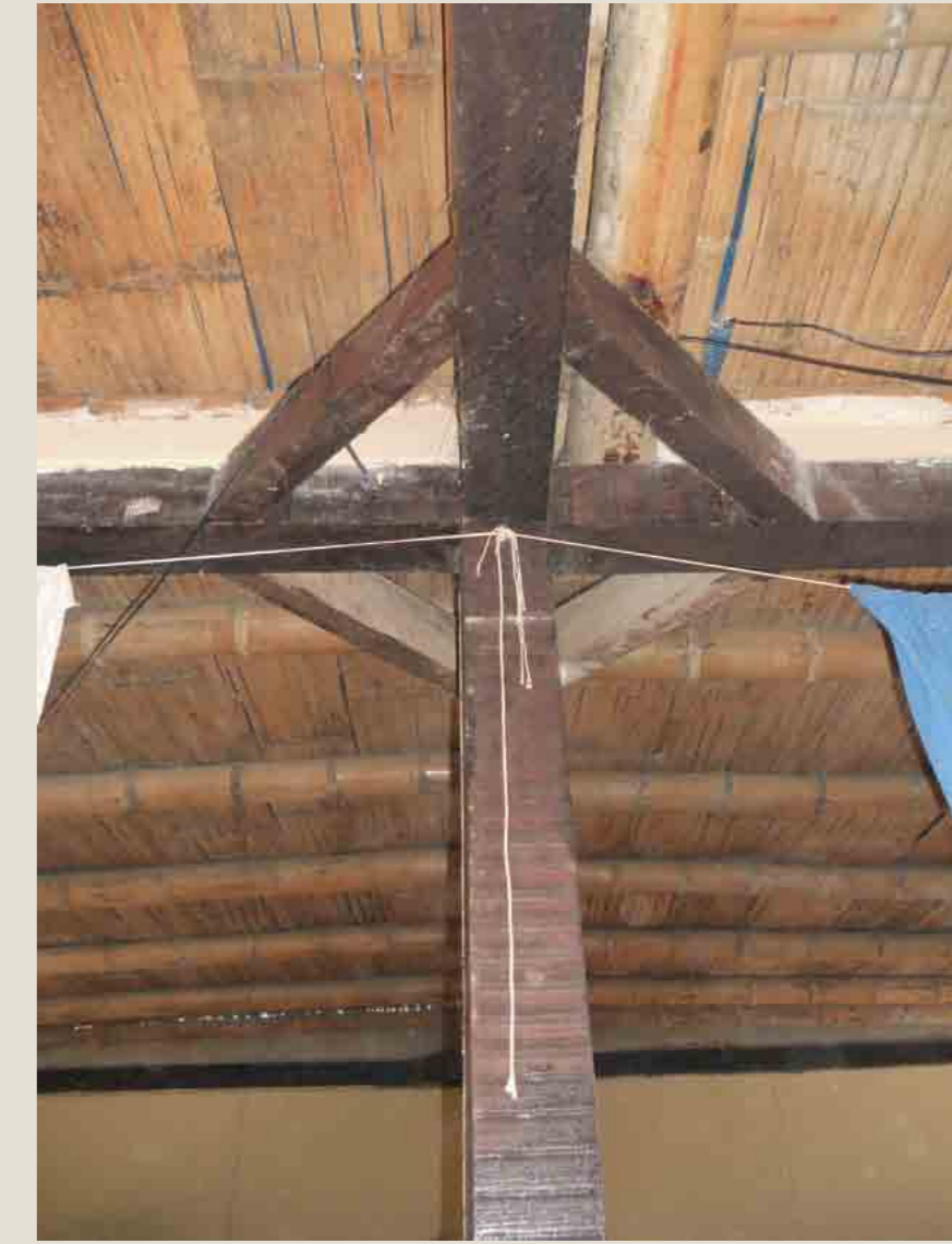
Detalle del encuentro entre la viga solera y la columna de muro de quincha Las diagonales brindan mayor resistencia ante movimientos sísmicos Fuente: MPM
