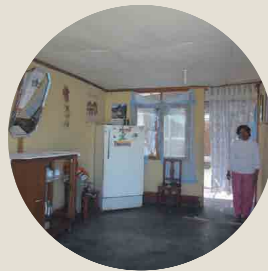
Vista interior de una vivienda en La Tinguiña Cielo raso de triplay Fuente: MPM
