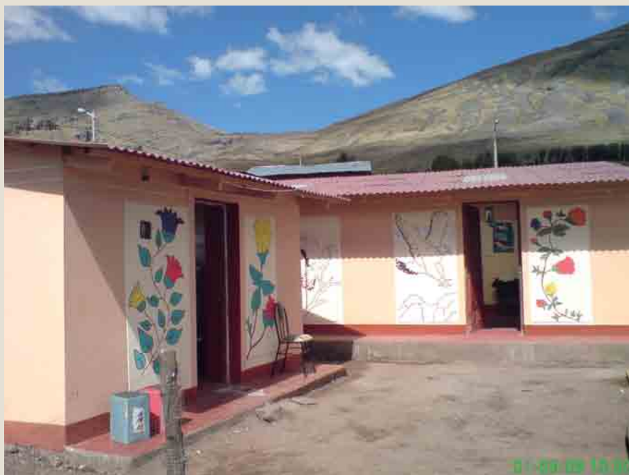
Vista exterior de una vivienda en Colcabamba Fuente: Archivo Cáritas
