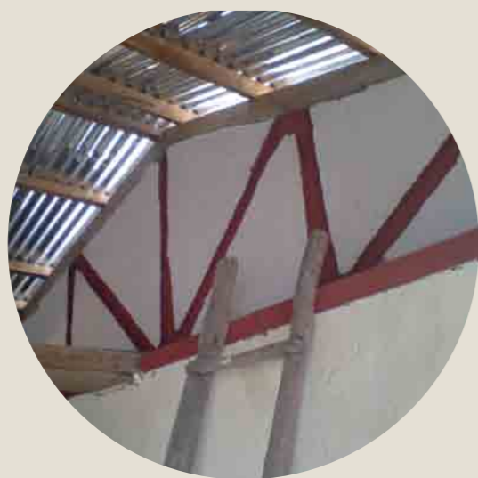
Vista interior del techo de calamina galvanizada con tímpano de quincha Vivienda en Madean Fuente: Archivo Caritas
