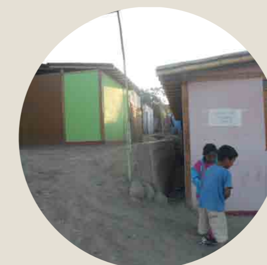
Detalle del muro de contención para proteger una vivienda en El Huarango Fuente: MPM
