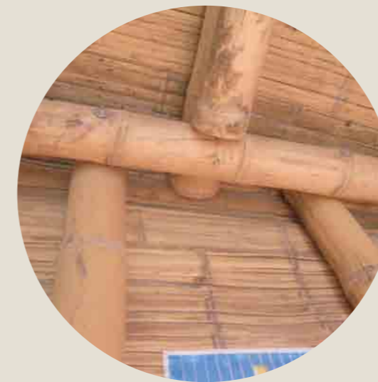
Detalle del encuentro entre las vigas y columnas de bambú Fuente: MPM
