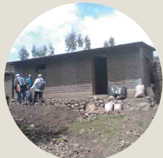
Proceso constructivo con reforzamiento de encuentros con malla galvanizada en una vivienda en Colcabamba Fuente: Archivo Cáritas
