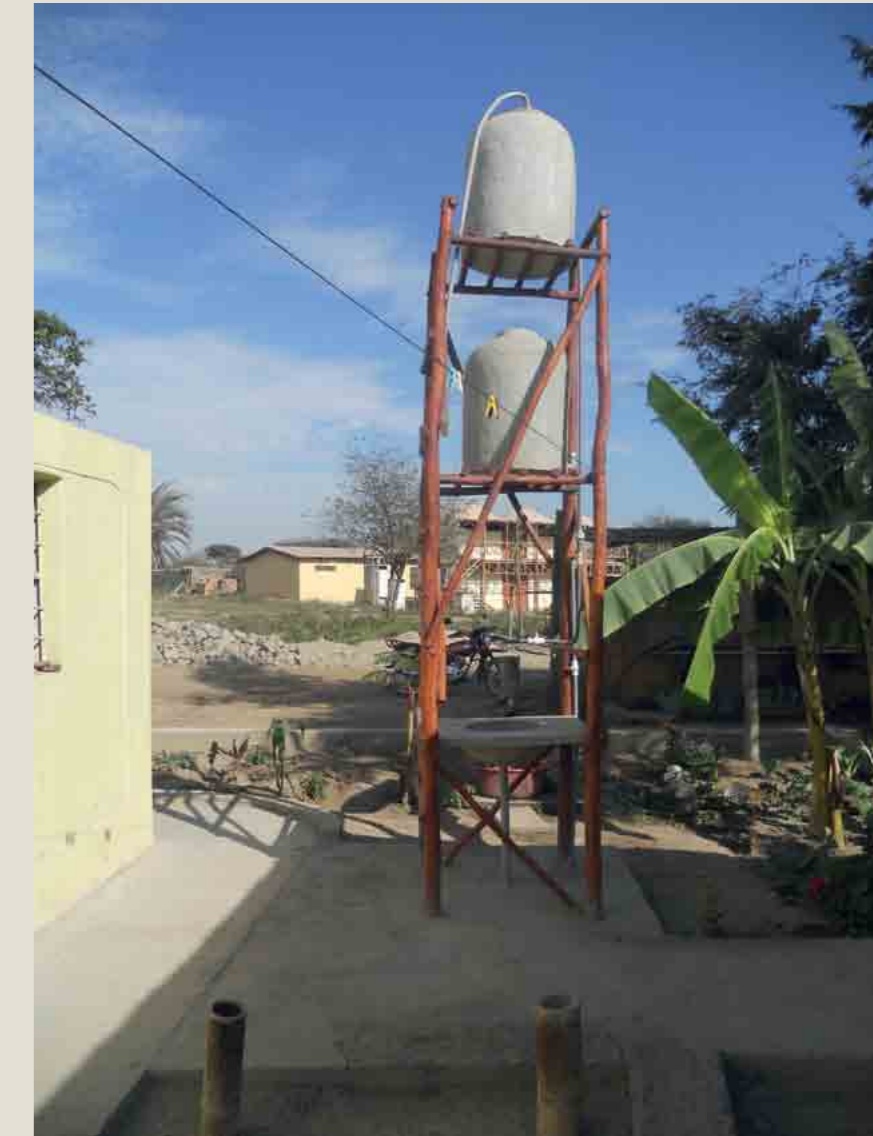
Sistema de filtración de agua de acequia que se complementa con una letrina abonera seca. Este diseño se basa en la propuesta de la Escuela Móvil de Agua y Saneamiento -EMAS- de Bolivia Fuente: MPM
