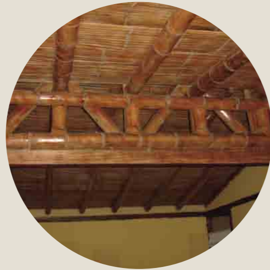
Detalle del tijeral con caña Guayaquil Vivienda en Chacarilla Fuente: Archivo ITDG
