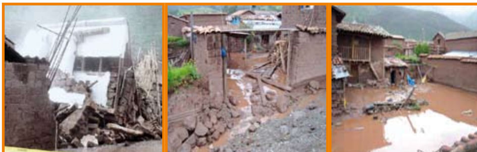
FIGURA N° 43 DAÑOS DE LAS VIVIENDAS EN LA CIUDAD DE ZURITE
