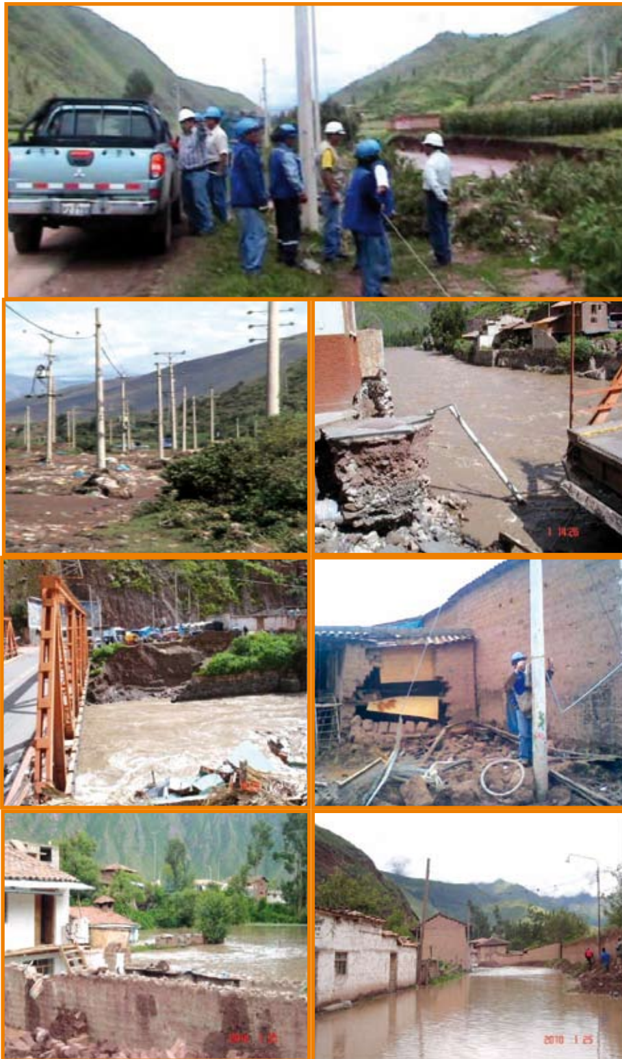
FIGURA N° 75 IMÁGENES DE LA INFRAESTRUCTURA DAÑADA POR EL DESASTRE
