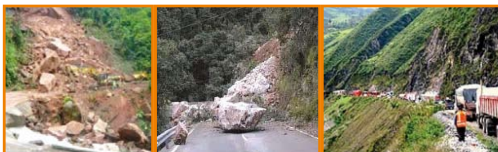
FIGURA N° 73 DAÑOS EN LA CARRETERA DE LA REGIÓN CUSCO
