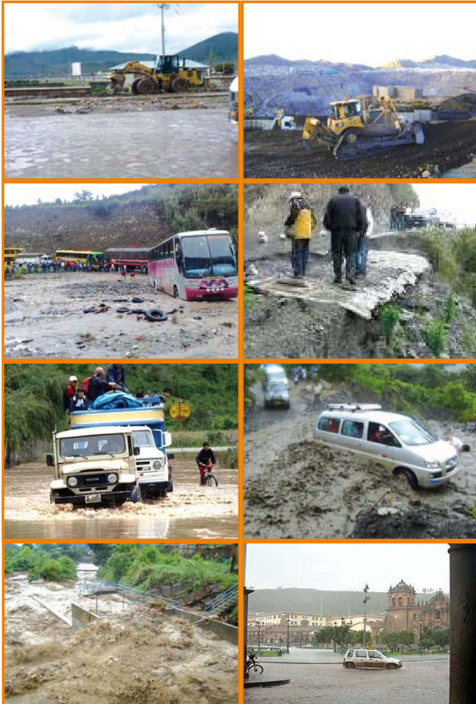
FIGURA N° 71 IMÁGENES DE DAÑOS EN LA INFRAESTRUCTURA DE TRANSPORTE
