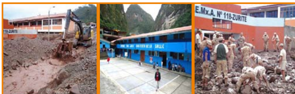
FIGURA N° 56 IMÁGENES DE II.EE. DESTRUIDAS Y AFECTADAS
