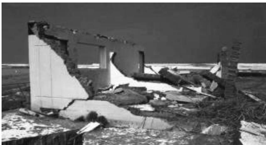
**Figura 1.** *La influencia del entorno es causa de inseguridad. Establecimiento de salud destruido por Tsunami (Sismo de Aticó 23/6/2001)*
