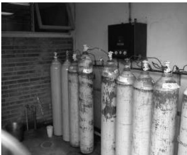
Figura 13. Balones en peligro por falta de sujeción
