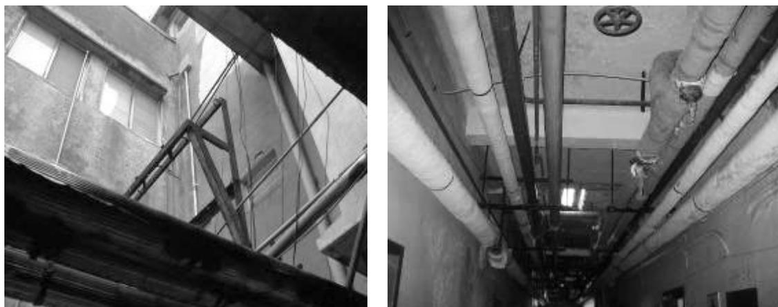
Figura 12. Líneas de conducción en riesgo y identificación de líneas.
