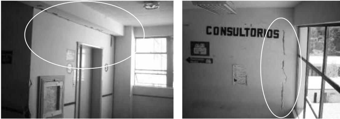
Figura 5. Junta no adecuada origina choque y deterioro entre elementos adyacentes en un establecimiento de salud.
