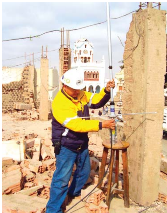
Gráfico N° 45. Instalación de sistema radial
