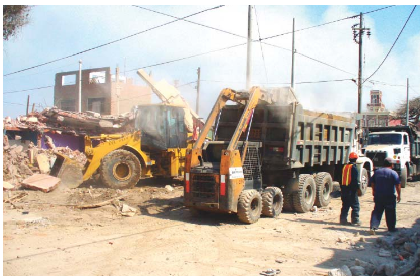
Gráfico N° 47. Remoción de escombros ejecutado por empresa DOE RUN
