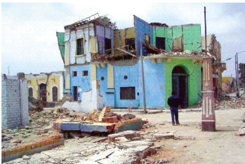
Gráfico N° 58. Construcciones colapsadas en Pisco
