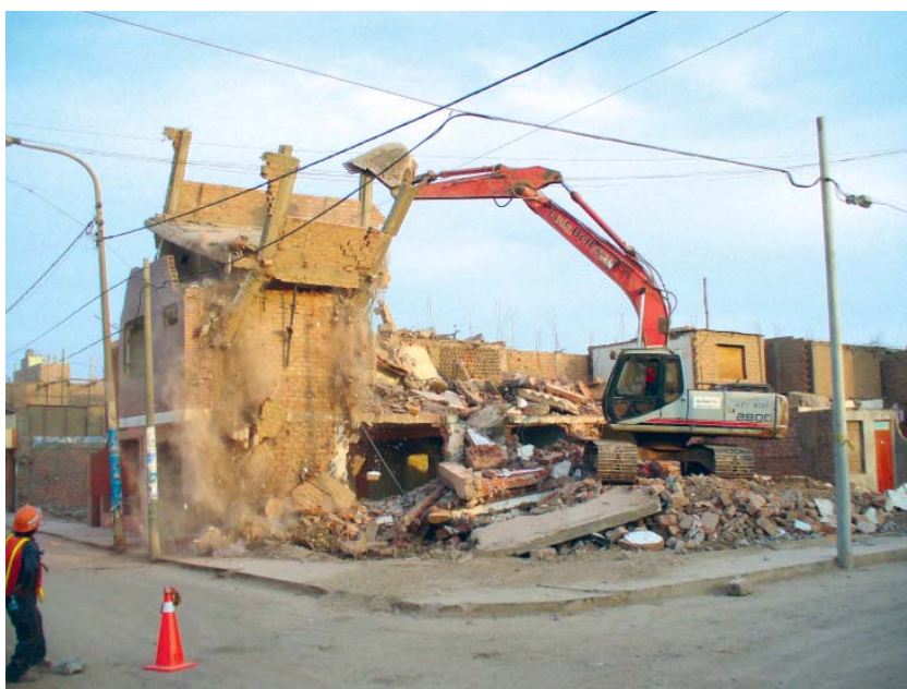
Gráfico N° 48. Remoción de escombros ejecutado por empresa DOE RUN
