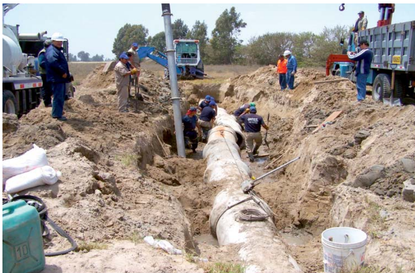
Gráfico N° 38. Reparación de Tubería en Pisco
