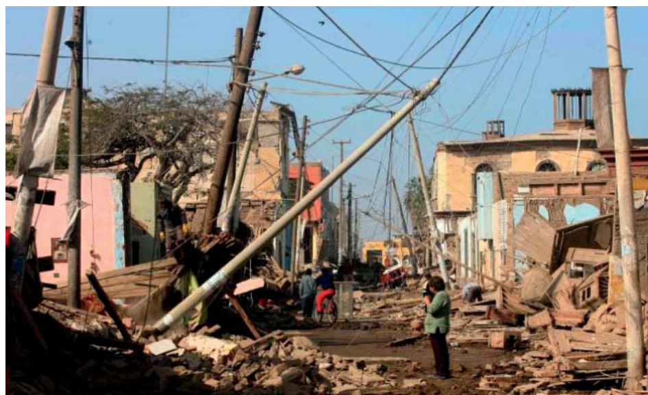
Gráfico N° 34. Daños producidos por el sismo
