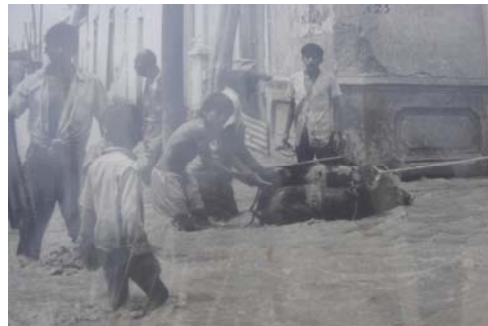
Vista de la intersección de la Av. Augusto B. Leguía – Fenómeno El Niño 1972
