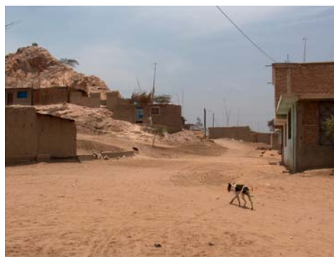
Vista de la calle San Pedro en el AA.HH. Nueva Esperanza, obsérvese la diferencia de niveles. La ocupación de la cota más alta corresponde a viviendas asentadas en el Cerro Cueto.
