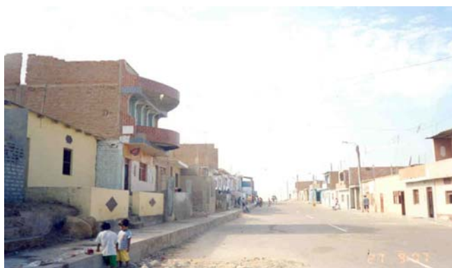
Las nuevas edificaciones carecen de sistema de drenaje.
