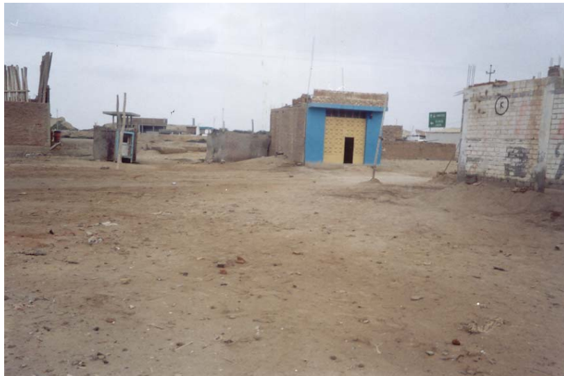
Vista que muestra el estado actual en la zona de Mocce- luego del Fenómeno “El Niño” de 1998.
