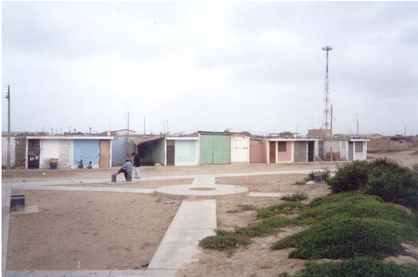
Edificaciones junto al parque de la destruida Mocce.
