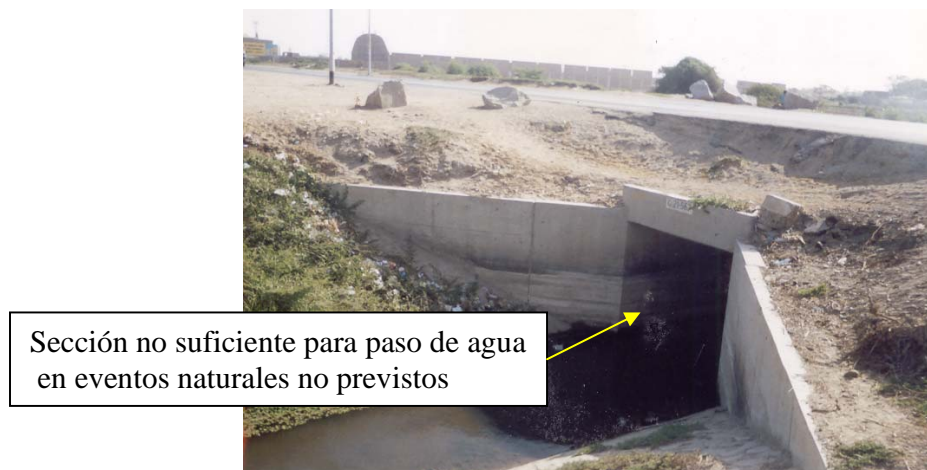
Alcantarilla. Cruce D - 1400 con la Panamericana Norte (Al Sur de Mocce)
