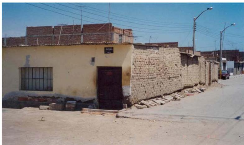
Vista exterior de una vivienda que evidencia deficiencias en el diseño y sistema constructivo. Nótese la ocupación de la sección vial, la ubicación de los postes de tendido eléctrico y el nivel del primer piso respecto al nivel de la vía.
