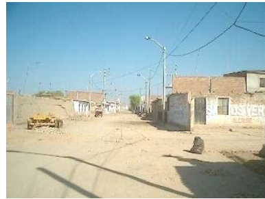
Falta de tratamiento en las vías.
