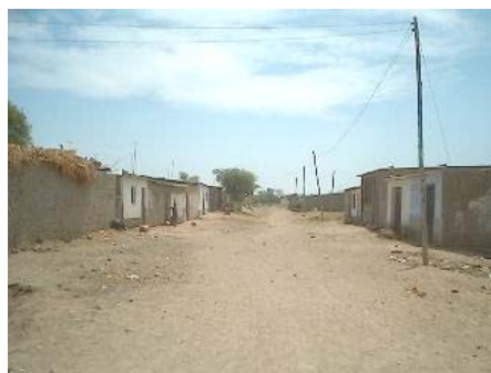
Instalaciones provisionales de energía eléctrica de la U.V. San Francisco de Asís.
