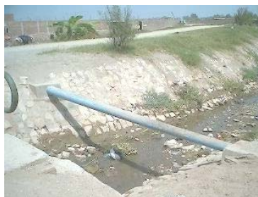
Redes de agua expuestas atraviesan la Acequia Soltín, sirven a las U.V. Los Angeles, San J. Tadeo.
