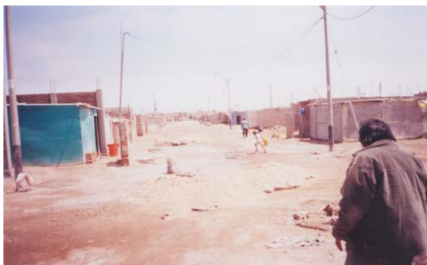
En las nuevas habilitaciones es necesario una orientación en la edificación.
