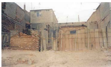
Erosión por efectos de viento en vivienda precaria.
