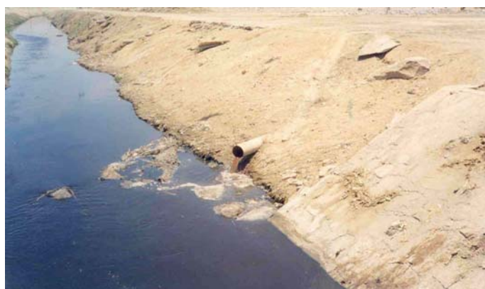
Es necesario revisar el sistema de alcantarillado que vierte aguas residuales al dren.
