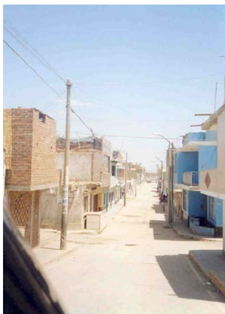
Vía pavimentada sin obras de drenaje.
