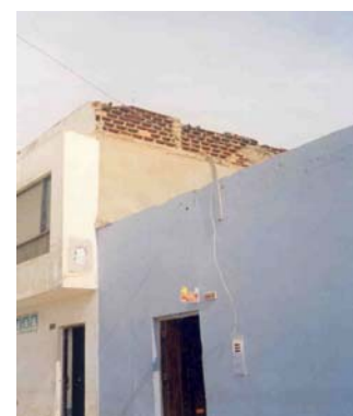
Vivienda sin acabado exterior sujeta a la acción del viento.
