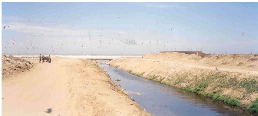
Deben evitarse las frecuentes colmataciones del Dren 4000 mediante acciones de limpieza y mantenimiento.
