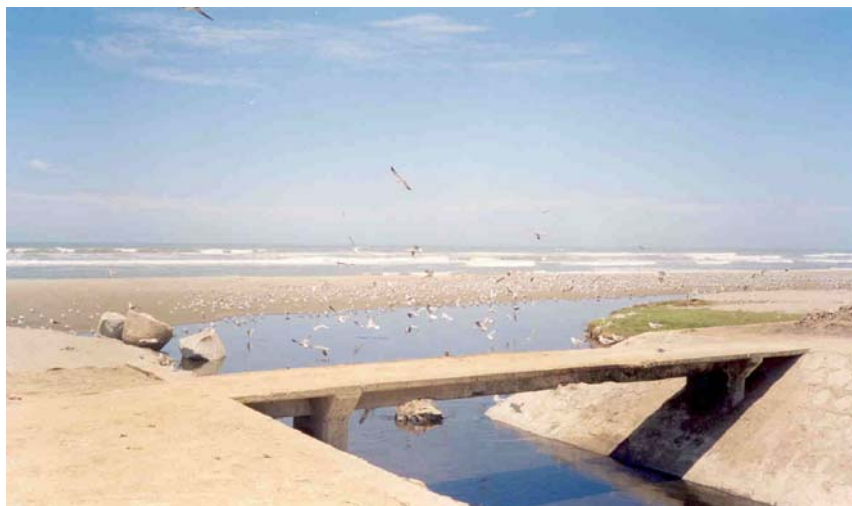
Rehabilitación del Dren 4000, en su desembocadura al Mar
