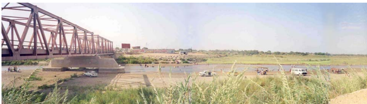
Estructura vulnerable del Puente Reque.
