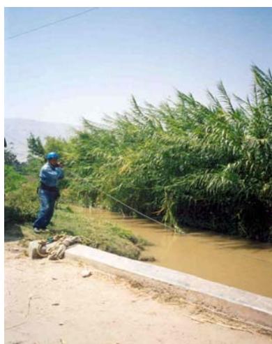
Acequia principal próximo al A.H. Puerto Arturo.
