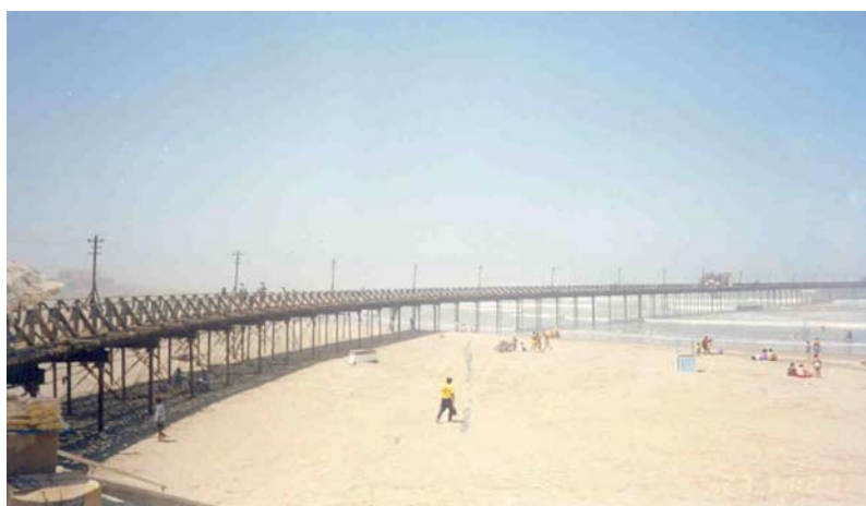
Vista del entramado de madera y barandas del Muelle Pimentel en muy mal estado.
