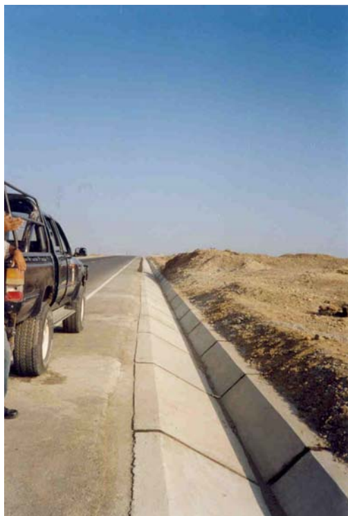
Vías pavimentadas con obras de drenaje.
