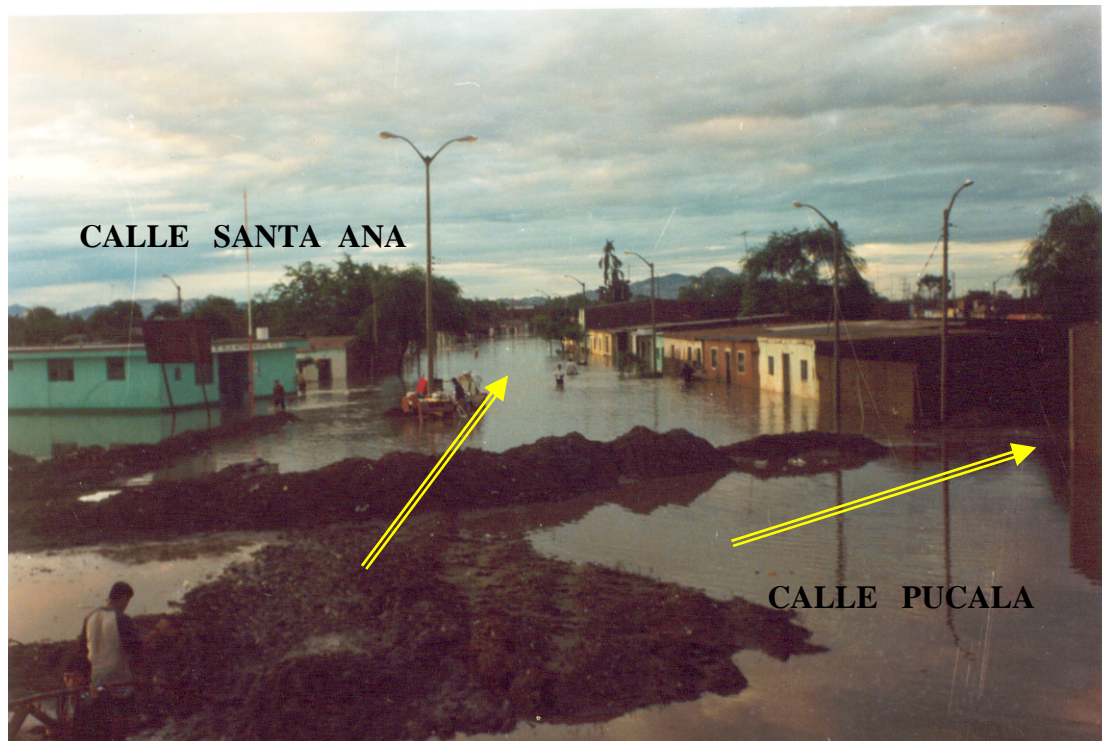
F-2 La ausencia de Drenaje ocasionó que las aguas se acumularan en esta zona.
