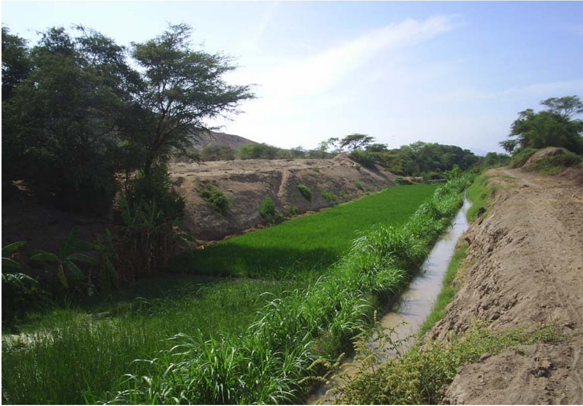
F-10 Agricultores aledaños siembran maíz y arroz en el cauce del canal Taymi Antigua, colmatándolo.
