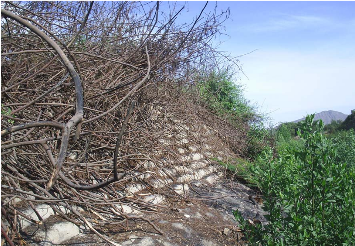
F-9 Luego del desborde del Taymi se colocaron 700 sacos terreros como medida de protección de talud.
