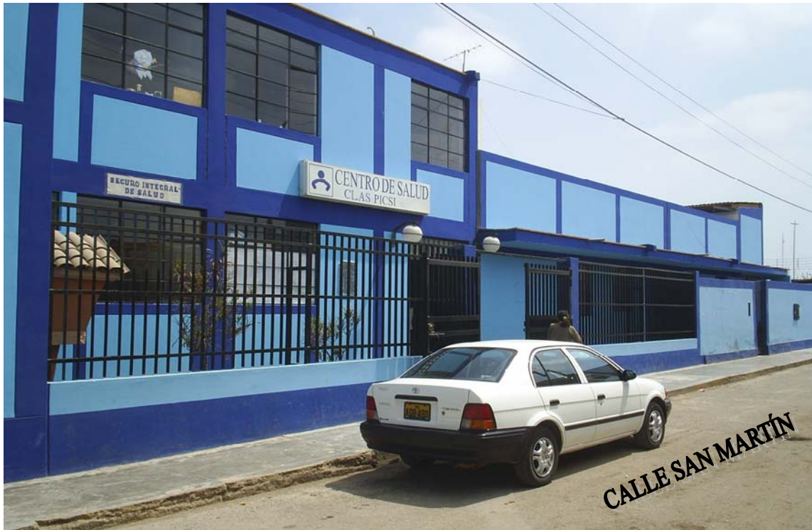
F-15 Centro de Salud de Pícsi. No fue afectado por el fenómeno del Niño del 98, aun así se mejoró su infraestructura de acuerdo a la Norma Técnica Estructural vigente.
