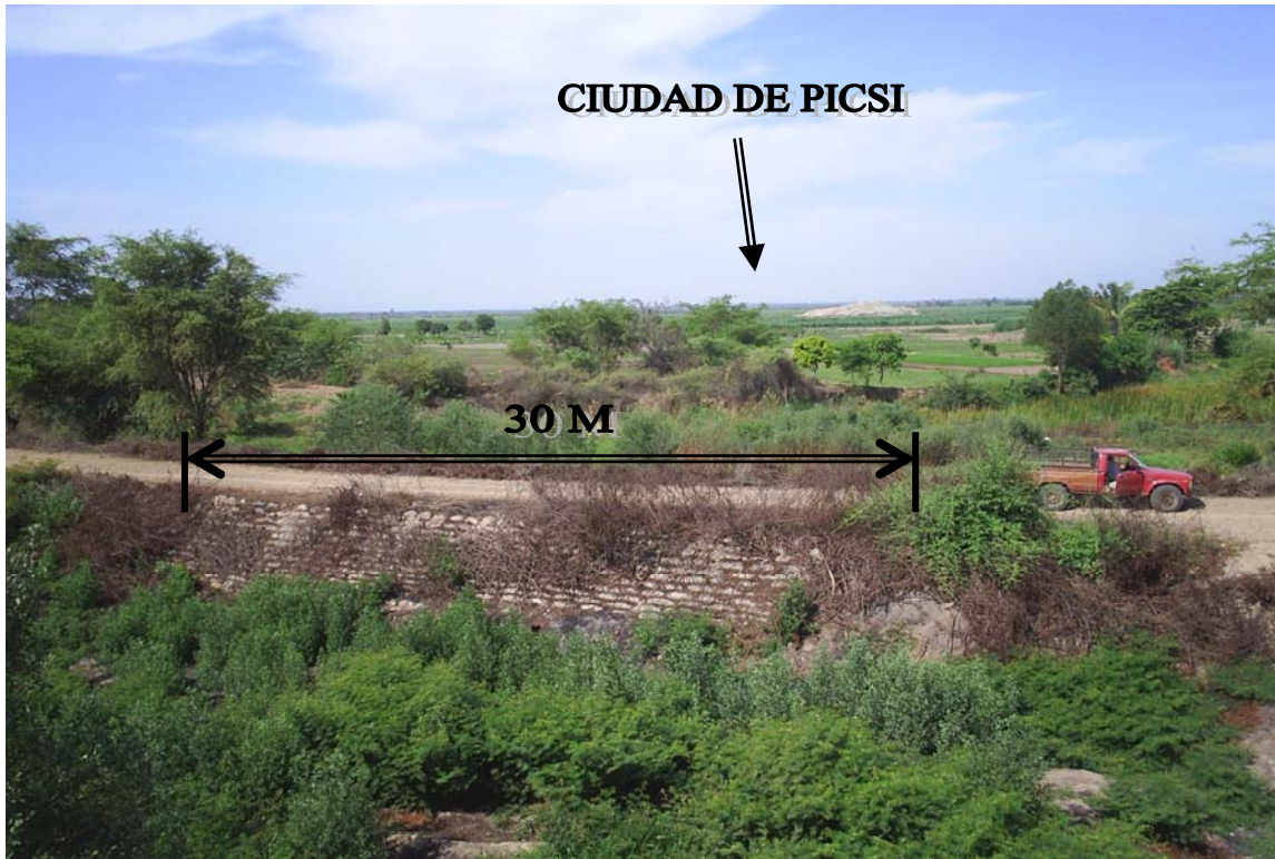
F-8 Tramo colapsado del Canal taymi Antiguo. Pendiente abajo, la ciudad de Pícsi, una de las más afectadas con el desborde producto de la ruptura del dique de tierra.
