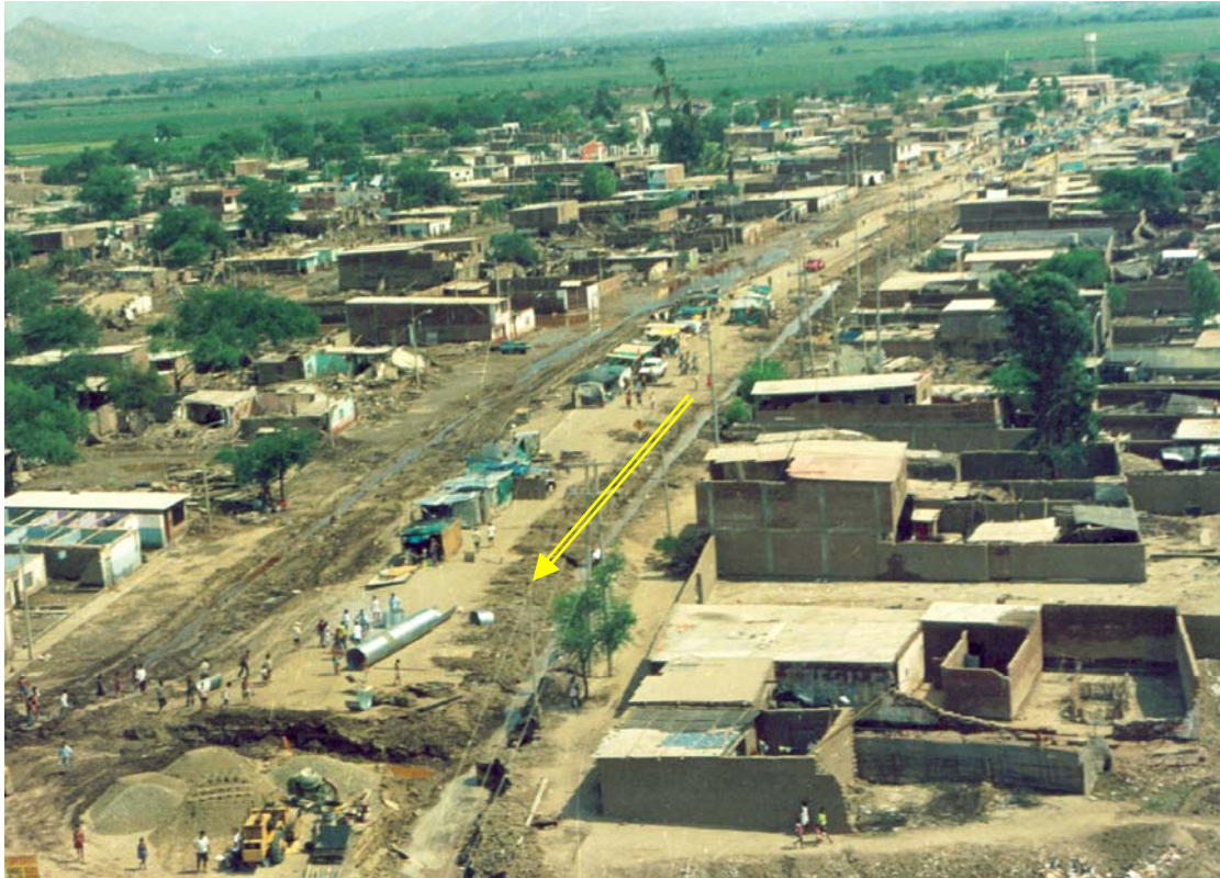
F-5 Vista aérea de la Carretera Chiclayo - Ferreñafe. Las cuadrillas de trabajadores están colocando las alcantarillas en la prolongación de las calles Pucalá y Túpac Amaru.
