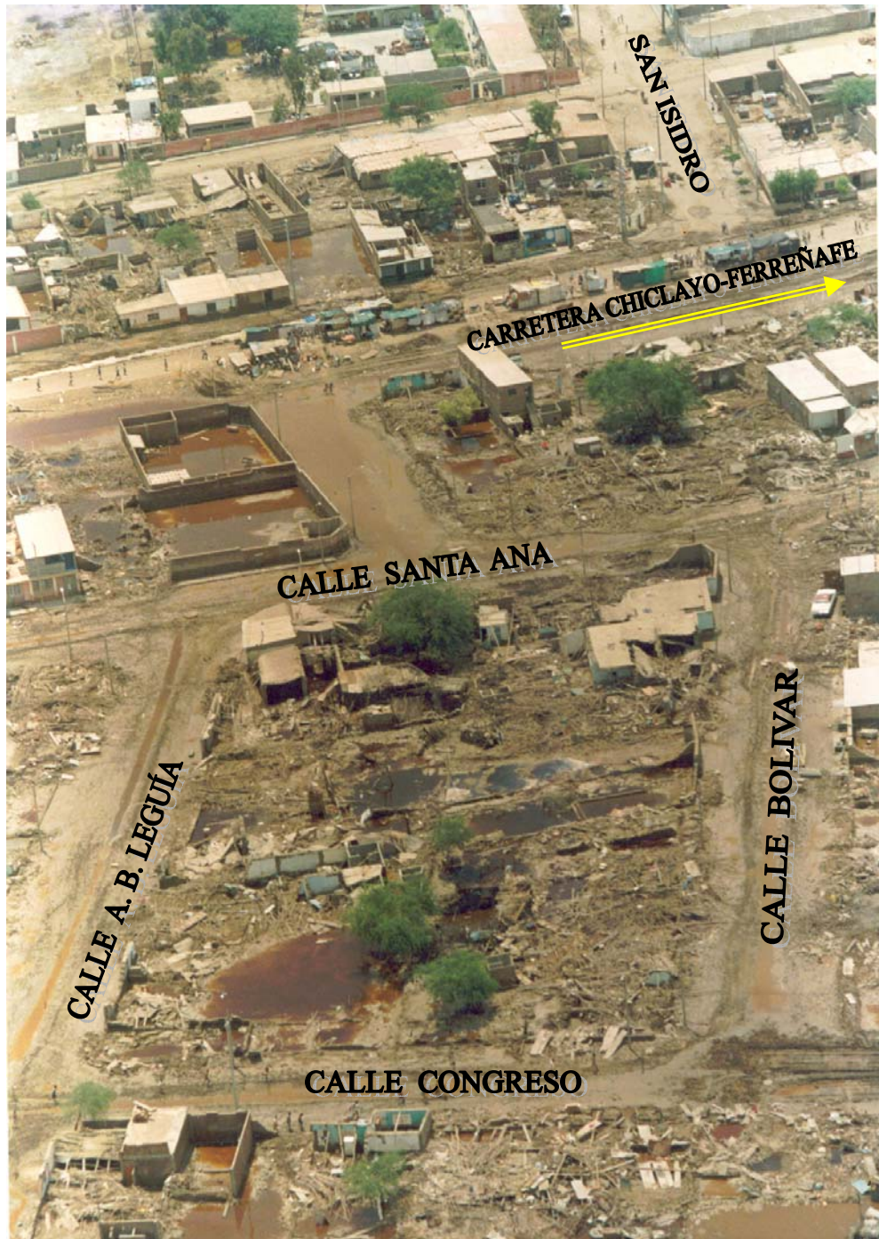
F-7 Las viviendas de adobe que permanecieron varios días bajo agua quedaron destruidas.
