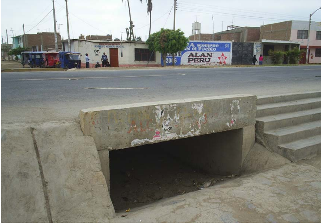
F-11 Alcantarilla ubicada en la prolongación de la calle Túpac Amaru.
