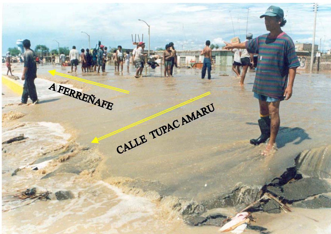
F-4 De manera natural el Flujo de Agua discurrió por la Calle Túpac Amaru, destruyendo gran parte de la carretera a Ferreñafe.
