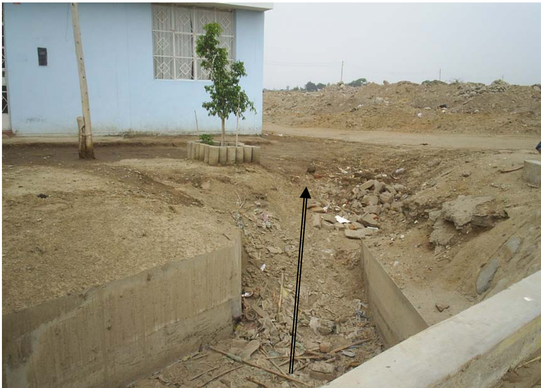
F-12 Vivienda ubicada en el cauce de la alcantarilla Pucalá, en peligro de erosión.
