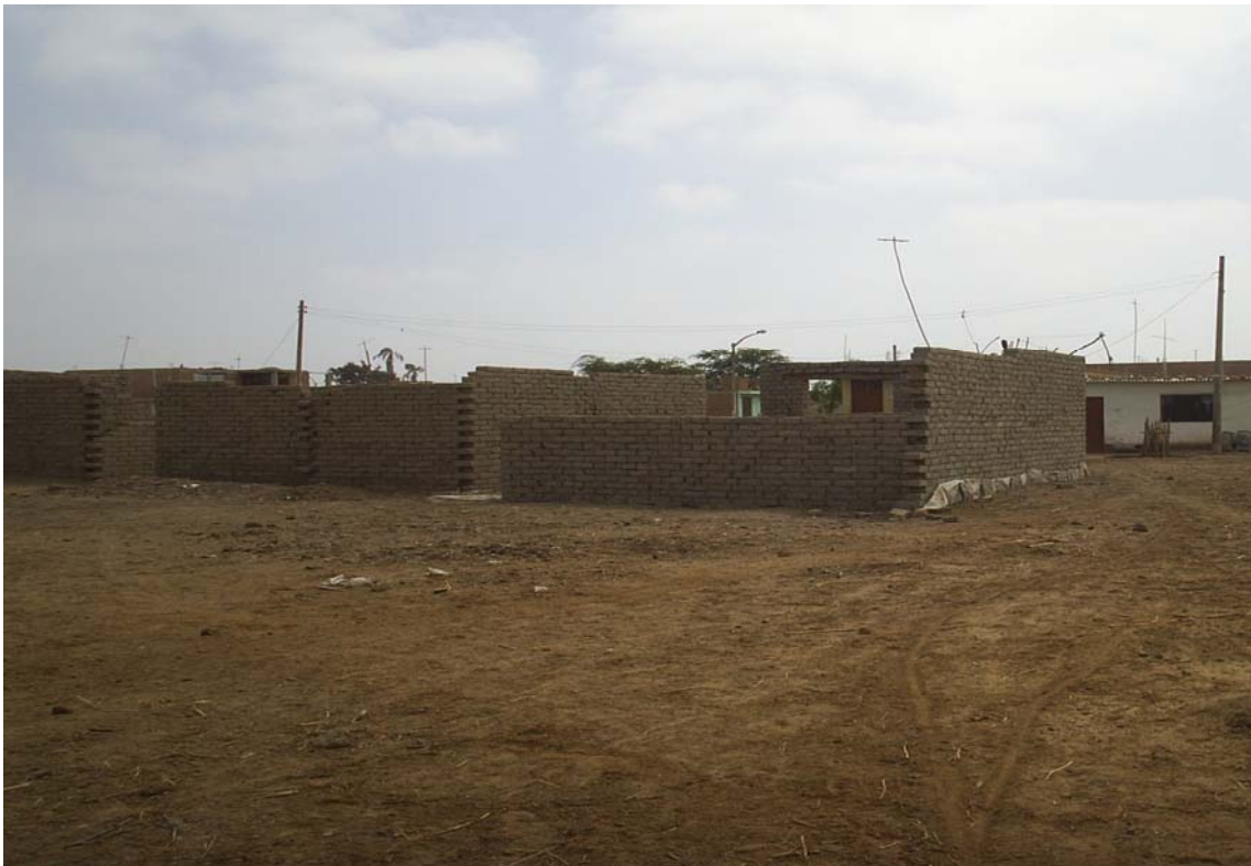
F-14 Prolongación de la calle Chiclayo. Construcción de viviendas de adobe en zona de Inundación Crítica y con presencia de suelos expansivos.
