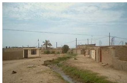
Vista de las viviendas ubicadas sobre el borde de la Acequia El Pueblo.
