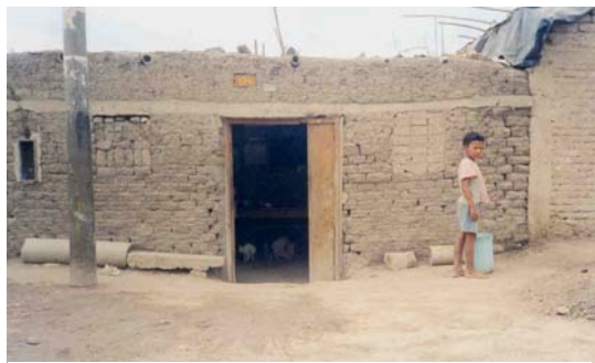
Inadecuada aplicación del Sistema Constructivo
