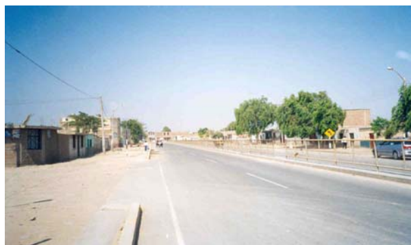
Situación actual de la Vía de Evitamiento, nótese la inexistencia del sistema de drenaje pluvial.
