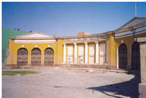
Antigua Estación del Ferrocarril
