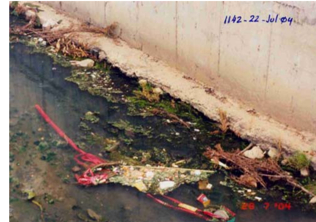
MARGEN DERECHA DEL RIO CHONTA CERCA AL PUENTE PRINCIPAL MOSTRANDO LOS DIVERSOS TIPOS DE RESIDUOS SÓLIDOS DENTRO DE AGUAS NEGRAS FETIDAS
