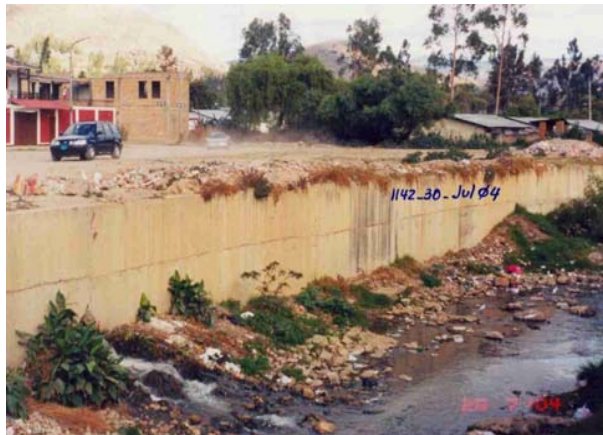
OTRO PUNTO DE DESCARGA DE LAS AGUAS SERVIDAS AL RIO CHONTA. TODA LA MARGEN IZQUIERDA SE HA CONVERTIDO EN BOTADERO DE BASURA
