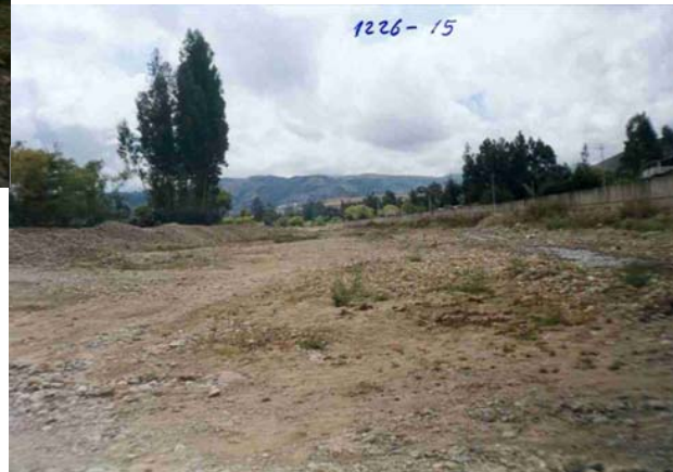
DEFENSAS RIBEREÑAS DE ENROCADO EN LA MARGEN DERECHA DEL RIO CHONTA. ES UNA ESTRUCTURA MUY DEBIL Y GENERALMENTE ES ARRASADO EN LAS MAXIMAS AVENIDAS DEL RIO
