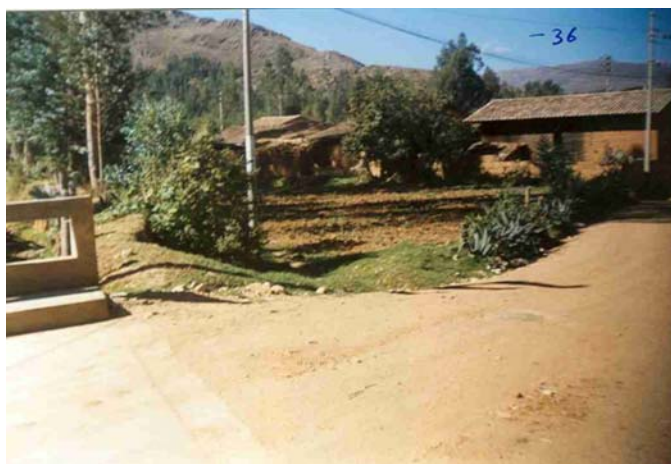
PUNTO DE DESBORDES UBICADO EN LA INTERSECCIÓN DE LA QUEBRADA TINGO MAYO CON LA AV. LOS EUCALIPTOS
