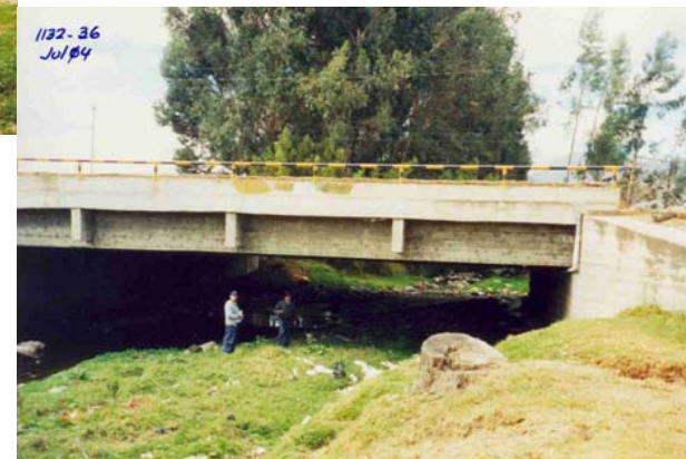
CONCENTRACIÓN DE MATERIALES GRESOS HASTA FINOS PRODUCTO DE LAS AVENIDAS EN EL RIO MASHCON. ES UNA ZONA DE DESBORDE E INUNDACIONES
