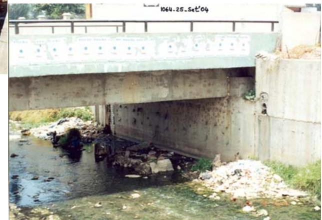
RESIDUOS SOLIDOS DENTRO DEL RIO
