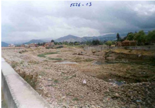
EXPLORACION DE AGREGADOS EN EL CAUCE DEL RIO CHONTA, PROCESO QUE AUMENTA LA RUGOSIDAD DEL LECHO
