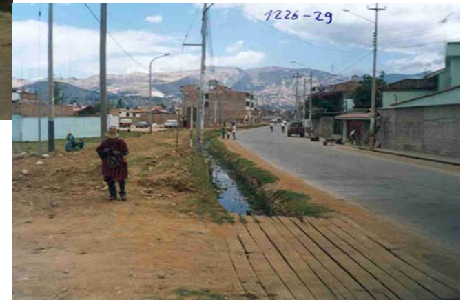
ACEQUIA QUE PASA POR LA AV. MANCO CAPAC, LA CUAL SE CARGA CON AGUAS QUE LLEGAN DEL CANAL REMONTA 2, DESBORDÁNDOSE HACIA LOS BAÑOS CERCADO
