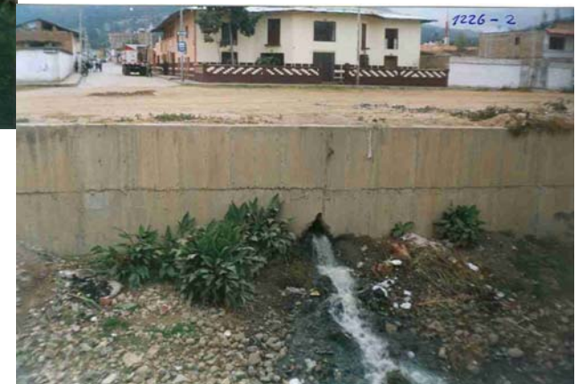
PUNTO DE DESAGUE DE AGUAS SERVIDAS HACIA EL RIO CHONTA
