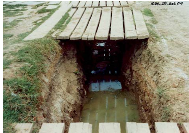
CANAL LAGUNA SECA CON AGUAS NEGRAS MUY CERCA DONDE SE ENCUENTRAN HACIENDO LIMPIEZA
