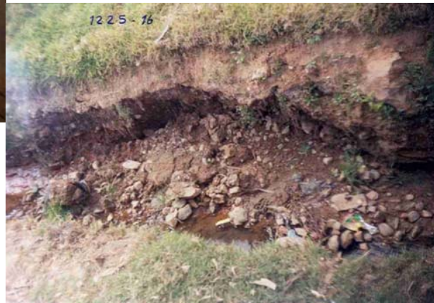
EROSION LATERAL DEL CANAL LAGUNASECA CERCA DE LA INTERSECCION DE LA AV. MANCO CAPAC Y EL CANAL REMONTA 2
