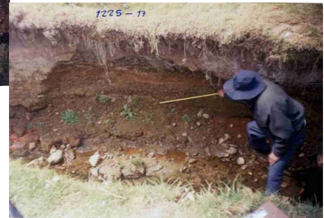
EROSION LATERAL Y DE FONDO EN EL CANAL LAGUNA SECA. VISIBLE LA ESTRATIGRAFIA DE DEPOSITOS ARCILLOSOS CON MATERIALES ORGANICOS Y PRESENCIA DE LIMONITAS UBICACIÓN CERCANA A LA INTERSECCION CON EL CANAL REMONTA 2
