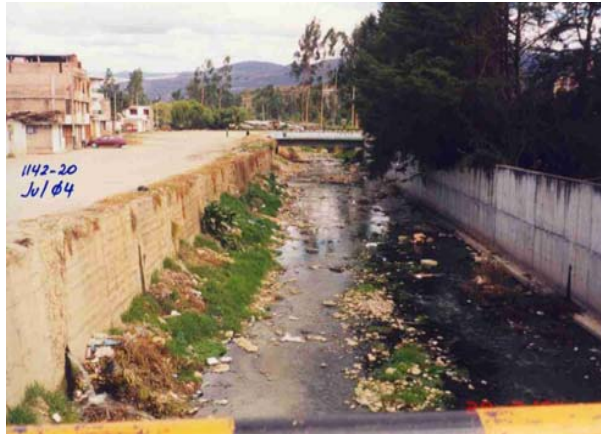
VISTA DESDE EL PUENTE AGUAS ABAJO DEL RIO, MOSTRANDO LA CONTAMINACIÓN TOTAL DEL RIO CON TODO TIPO DE RESIDUOS
