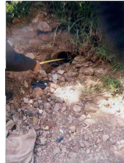
ORIFICIO CONSTRUIDO EN LA MARGEN DERECHA DE LA QUEBRADA TINGO MAYO PARA DERIVAR AGUA HACIA LOS TERRENOS DE CULTIVOS
