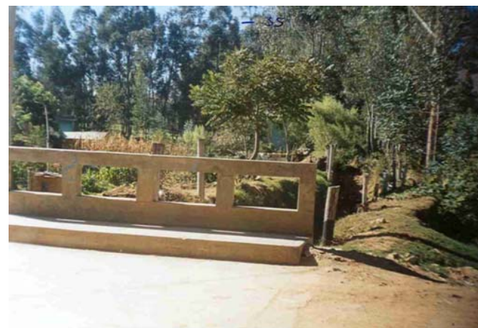
PUNTO DE DESBORDES UBICADO EN LA INTERSECCIÓN DE LA QUEBRADA TINGO MAYO CON LA AV. LOS EUCALIPTOS
