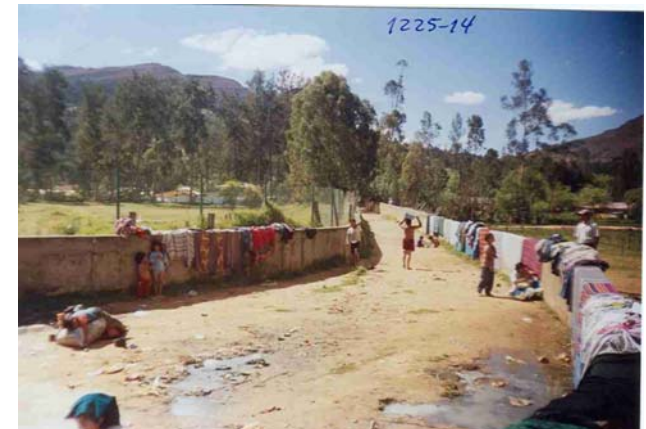
TRAMO CANALIZADO DE LA QUEBRADA SECA TINGO MAYO CERCA DEL TRAGADERO Y LAGUNA SECA
