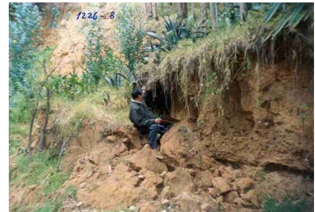
UNO DE LOS POCOS PUNTOS DONDE SE HA VISTO DERRUMBE DE UN TALUD CASI VERTICAL POR PROCESOS DE EROSION LATERAL Y EMPUJES ACTIVOS. NO REPRESENTA PELIGROS DE DESLIZAMIENTOS
