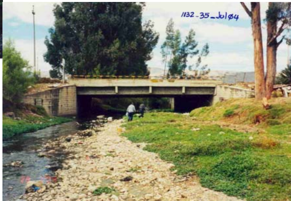
VISTA HACIA EL PUNTE SOBRE EL RIO MASHCON. AL LADO IZQUIERDO LAS AGUAS CONTAMINADAS Y RESIDUOS SOLIDOS Y EN LA MARGEN DERECHA LAS ACUMULACIONES DE DEPOSITOS ALUVIO-FLUVIALES
