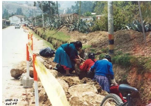
GRUPO DE MUJERES DEL PROGRAMA A TRABAJAR URBANO ABRIENDO Y LIMPIANDO EL CANAL
