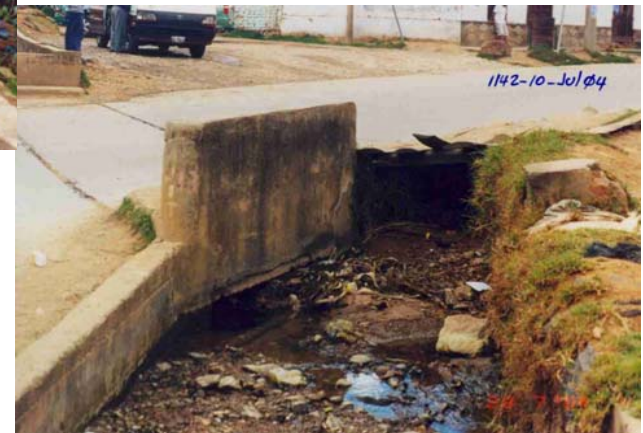
LADO DERECHO DEL CANAL EN DIRECCION A SU FLUJO INTERSECCION CON LA AV. MANCO CAPAC, SE NOTA LOS RESIDUOS SOLIDOS, LIQUIDOS Y FUERTE SEDIMENTACION
