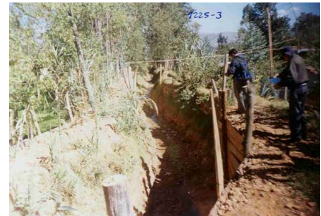
DEFENSA RIBEREÑA PROVISIONAL EN LA QUEBRADA TINGO MAYO
