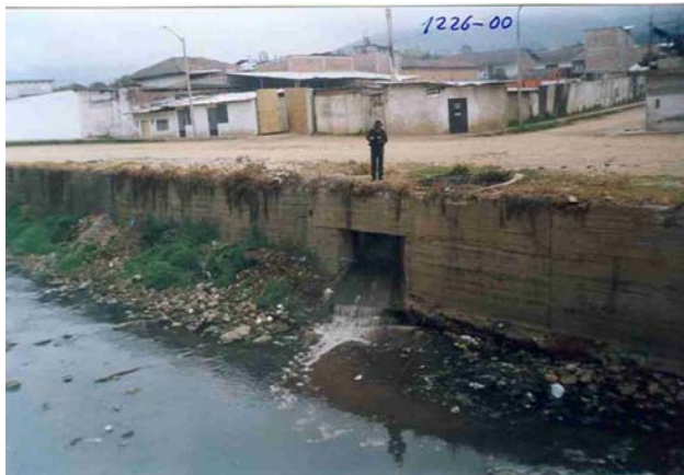
DESEMBOCADURA DE LA QUEBRADA TINGO MAYO EN EL RIO CHONTA, TRANSPORTANDO RESIDUOS CONTAMINANTES SOLIDOS Y LIQUIDOS
