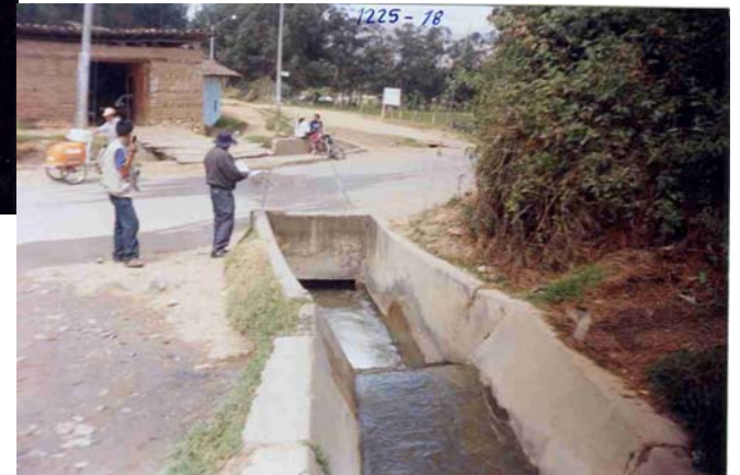
PUNTO CRITICO DE DESBORDES E INUNDACIONES UBICADO EN LA INTERSECCION DE LA AV. MANCO CAPAC, JR. LA LIBERTAD Y AV. LOS EUCALIPTOS
