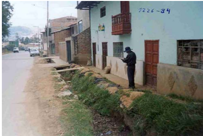
DRENAJE EN MALAS CONDICIONES QUE PASA POR LA AV. MANCO CAPAC. LOS MORADORES SE PROTEGEN DE LOS DESBORDES UTILIZANDO SACOS CON ARENA
