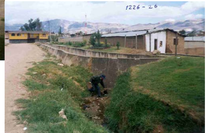
PUNTO CRITICO DONDE SE UNEN LA ACEQUIA QUE PASA POR LA AV. MANCO CAPAC Y LA QUEBRADA SECA TINGO MAYO. EL AGUA DESBORDA HACIA LA CALLE EN MAXIMAS AVENIDAS
