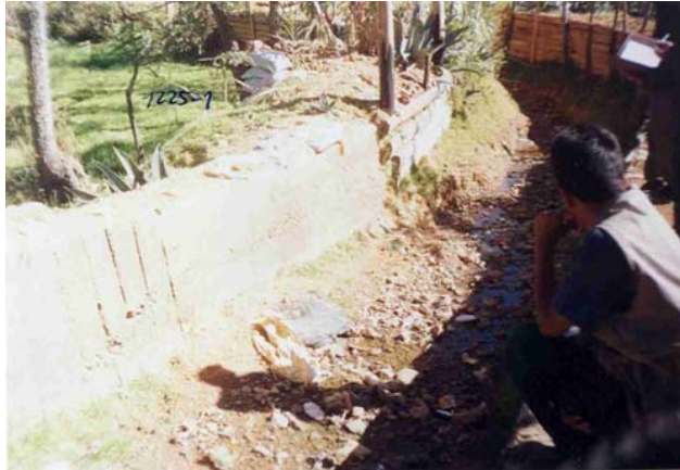
DEFENSAS RIBEREÑAS RUSTICAS CONSTRUIDAS POR LOS MORADORES PARA EVITAR INUNDACIONES PROVOCADAS POR LAS AVENIDAS EN LA QUEBRADA SECA TINGO MAYO, ALREDEDORES DE LA ZONA DE LAGUNA SECA.
