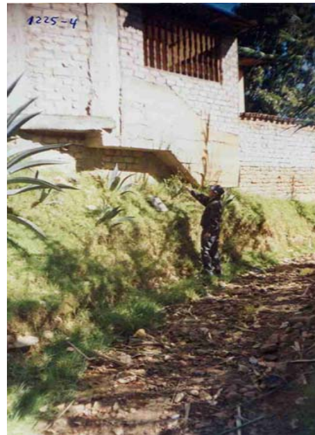
ING. HUAMAN SEÑALANDO EL NIVEL HASTA DONDE LLEGA EL TIRANTE DEL AGUA CUANDO NOS ENCONTRAMOS EN EPOCAS DE FUERTE LLUVIAS
