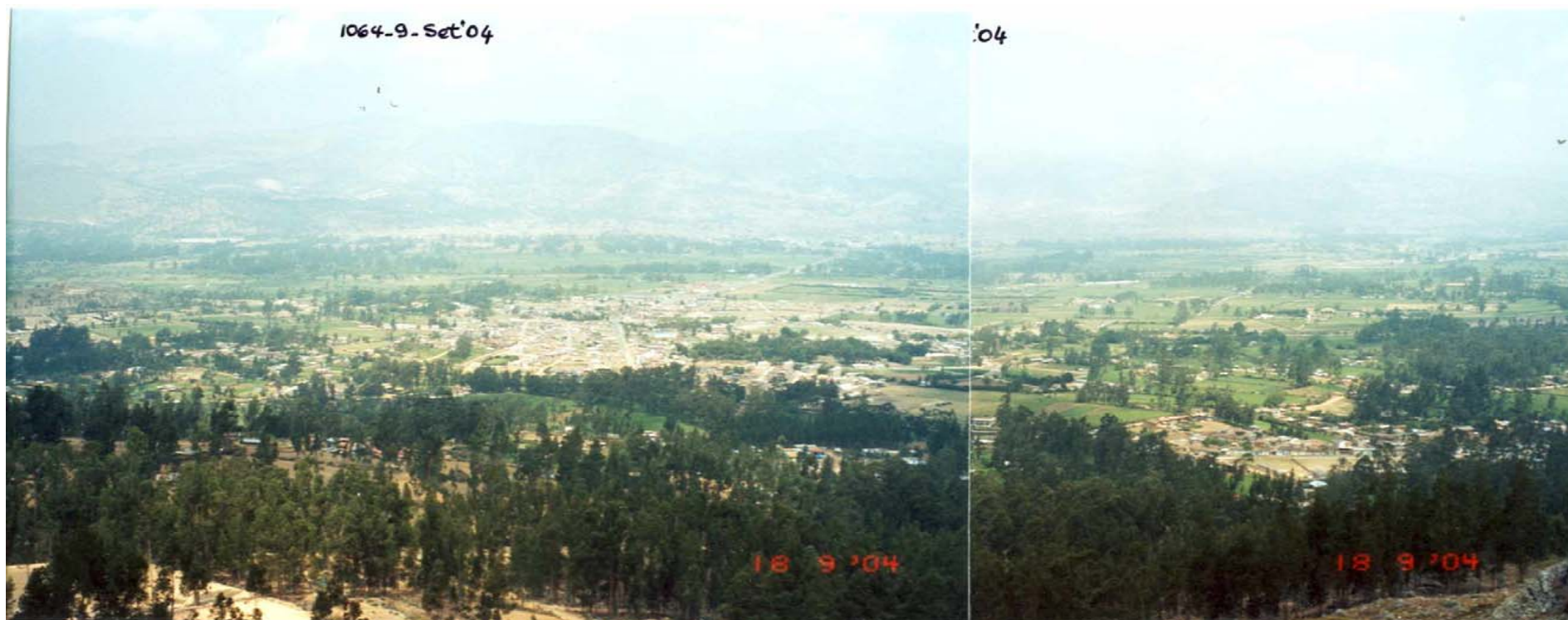
CIUDAD DE BAÑOS DEL INCA, AREAS VERDES DEL VALLE DE CAJAMARCA Y SU ENTORNO AMBIENTAL VISTA DESDE LA PARTE ALTA DEL CERRO CONDORPUÑINA AL FONDO LA CIUDAD DE CAJAMARCA
