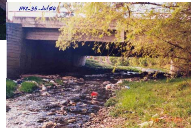
VISTA DESDE LA PARTE SUR Y AGUAS ARRIBA DEL RIO MASHCON. SE PUEDE NOTAR LA PRESENCIA DE AGUAS NEGRAS Y DESECHOS SOLIDOS AUN CUANDO EXISTE ESCORRENTIA. ES UN FOCO INFECCIOSO
