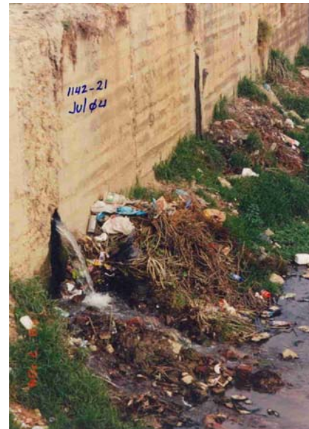
PUNTO DE DESCARGA DE LAS TUBERÍAS DE DESAGUE, ASÍ COMO BOTADERO DE BASURA
