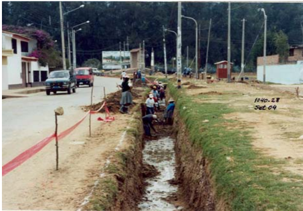
TRAZO Y ARRÉGLLO DEL CANAL LAGUNA SECA CERCANO A LA INTERSECCION CON EL CANAL REMONTA I
