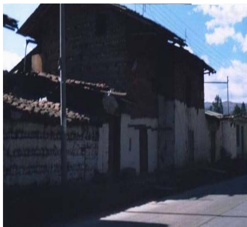
F-8SIS1 VIVIENDAS DE ADOBE (CARRETERA. A PUYLLUCANA)
