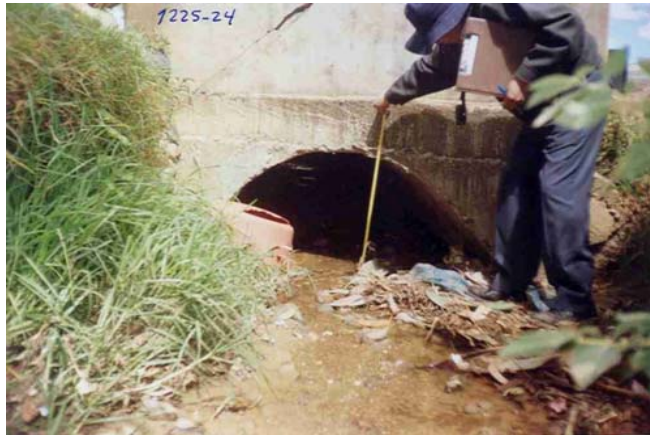
REDUCCION DE LA ALCANTARILLA POR DONDE PASA LA QUEBRADA MAYOPATA. ES UNA ZONA CRITICA POR LOS DESBORDES CONSTANTES
