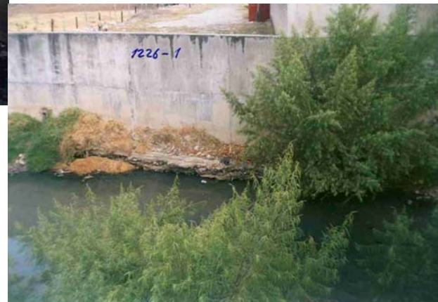
SOCAVAMIENTO DEL MURO DE ENCAUSAMIENTO DEL RIO CHONTA, FENÓMENO COMUN EN MUCHOS PUNTOS A LO LARGO DEL CAUCE
