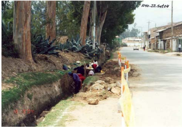
OTRO TRAMO EN PLENA LIMPIEZA
