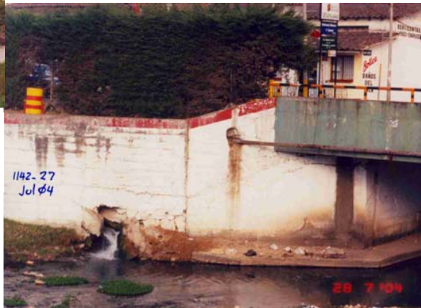
PUNTOS DE DESCARGAS DE AGUAS SERVIDAS Y AGUAS DE LAS PISCINAS TEMPERADAS CERCANAS AL PUENTE PRINCIPAL
