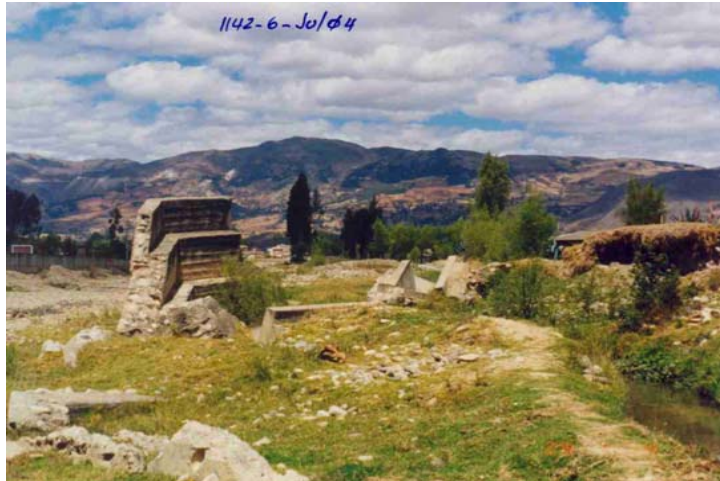
MARGEN DERECHA DEL RIO CHONTA, MOSTRANDO ACUMULACIONES DE MATERIALES ALUVIO-FLUVIALES. SE ENCUENTRAN RESTOS DE UNA ESTRUCTURA DE DISTRIBUCIÓN QUE HA SIDO DESTRUIDA POR LA ENERGÍA CINÉTICA DEL RÍO
