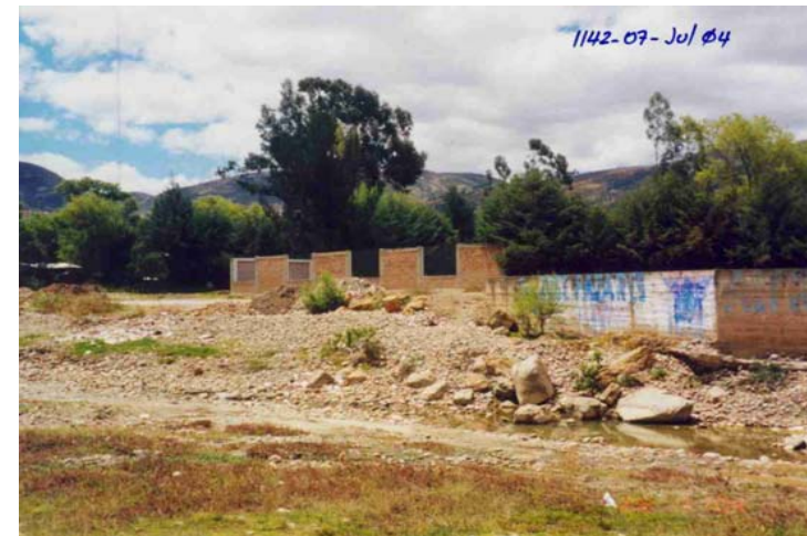
CAUCE Y MARGEN IZQUIERDA DEL RIO CHONTA CON ACUMULACIONES DE MATERIALES ALUVIO-FLUVIALES QUE SON UTILIZADOS COMO MATERIALES DE CONTRUCCION , TAMBIEN ENCONTRAMOS RESIDUOS SOLIDOS. LA EROSIÓN Y LA SOBRECARGA ESTAN AFECTANDO EL MURO PERIMETRICO DEL CLUB LOS INCAS
