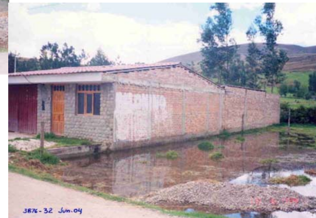
ZONA ALTAMENTE INUNDABLE VISTA PANORAMICA –LADO NE ZONA DE EXPANSION URBANA, COSTADO DE LA CARRETERA QUE VA A PUYLLUCANA, DONDE LA NAPA FREATICA ESTA SUPERFICIALMENTE
