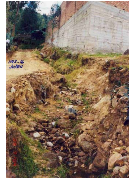
TRIBUTARIO AL CANAL REMONTA 2 QUE EN TIEMPO DE LLUVIAS VIERTE GRAN CANTIDAD DE AGUA
