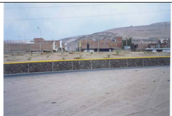
La protección y encauzamiento de la quebrada del Diablo es de vital importancia para la población de Asoc. La Florida.
