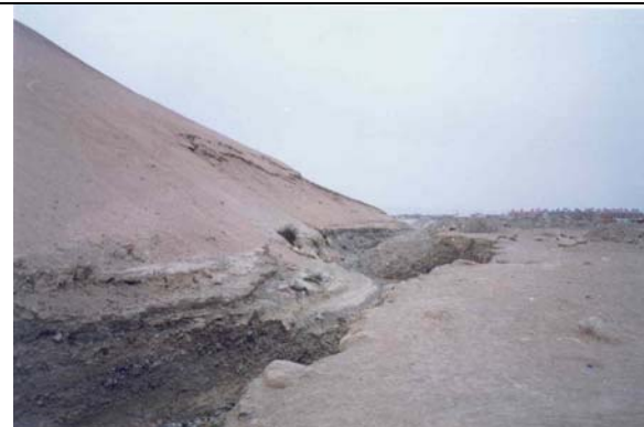
La estabilización del talud del codo del cerro Arunta es de vital importancia para la población de Cono Sur y ASoc. El Morro.
