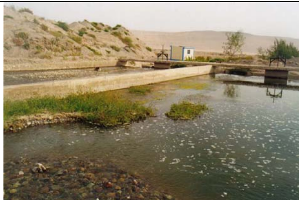
Poza de la Bocatoma Calientes en constante colapso
