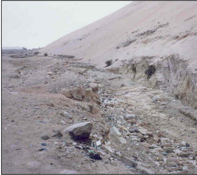
Foto N° 10. Erosión del talud en el cerro Arunta producida por la circulación de caudales importantes como el de la avenida del año 2001.
