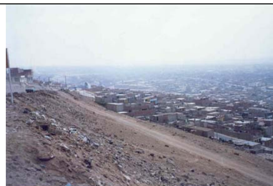
Las asociaciones vivienda asentadas en pleno cauce del río Caramolle, están en peligro por huayco o avenida.
