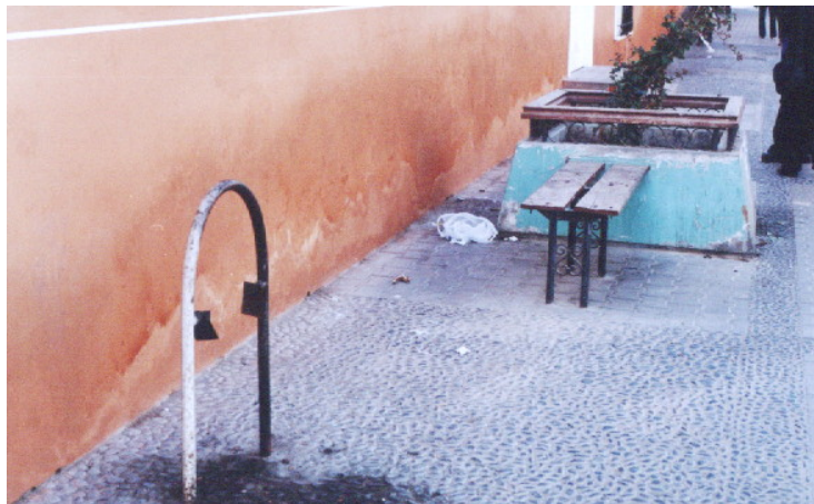
Hay una baja intervención Municipal por recuperar ó mantener la infraestructura que se deteriora
