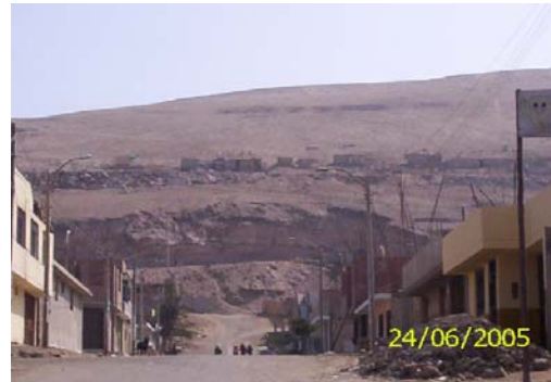
Vista de las Estructuras que pueden estar en riesgo ante una avenida de la Quebrada del Diablo
