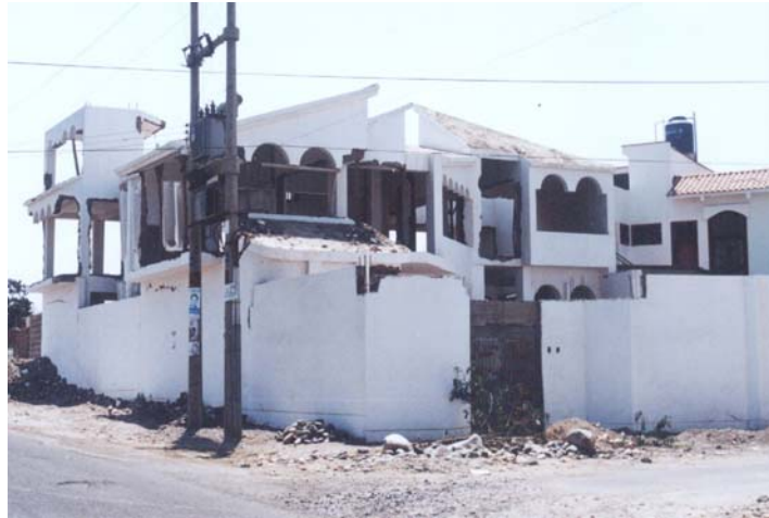
Edificación que sufrió el impacto del sismo del 23 de Junio del 2001, donde se muestra que incluso en obras de Residencias se concentran los aspectos de falta de criterio sobre los aspectos que deben rodear la seguridad de una edificación, comenzando desde el Estudio de Suelos
