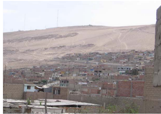
Vista de las edificaciones ubicadas en las laderas del Cerro Intiorko
