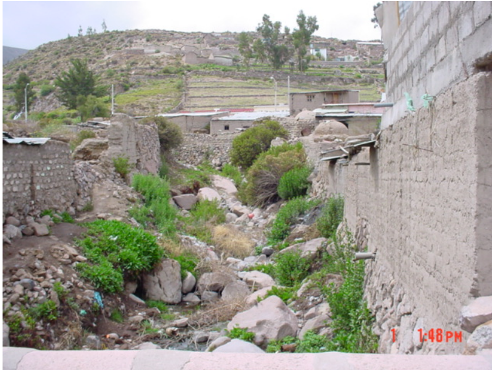
Foto 05.- Lado oeste del poblado de Candarave por donde atraviesa la quebrada que viene desde San Pedro. Se puede observar, dentro de su cauce, bloques de gran diámetro, lo cual demuestra la fuerza de transporte de las aguas que discurren por esta quebrada en época de lluvias.
