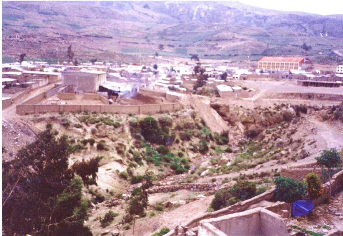
Foto 03.- Vista en al poblado de Candarave, en el flanco izquierda de la quebrada se puede observar el depósito fluvioglacial sobre el cual se encuentra parte deel poblado.
