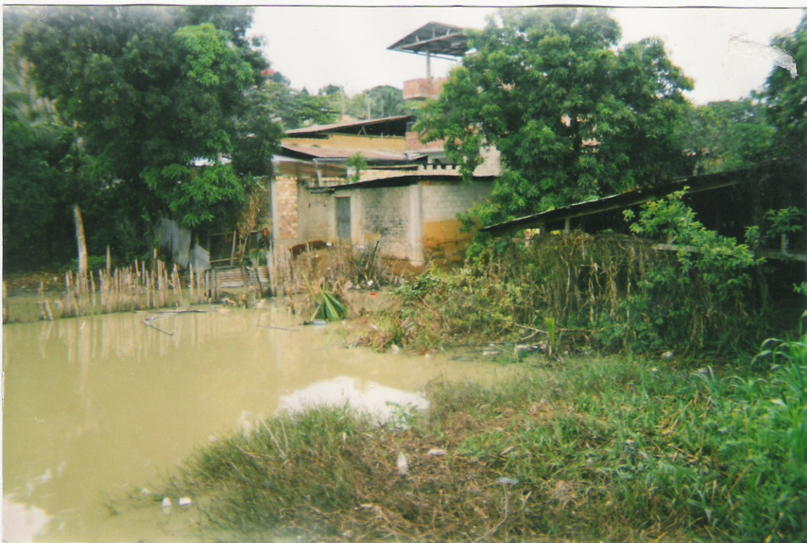
VIVIENDA AFECTADA POR AGUAS ACUMULADAS
