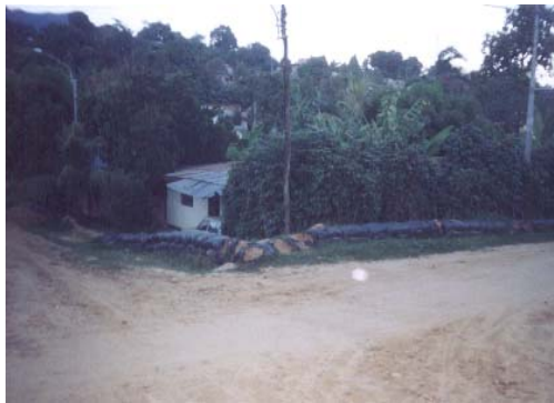
F-14: Barrio La Hoyada: Viviendas ubicadas por debajo del nivel de vías, debido a la topografía. No existen cunetas y veredas, y son áreas afectadas por las lluvias.
