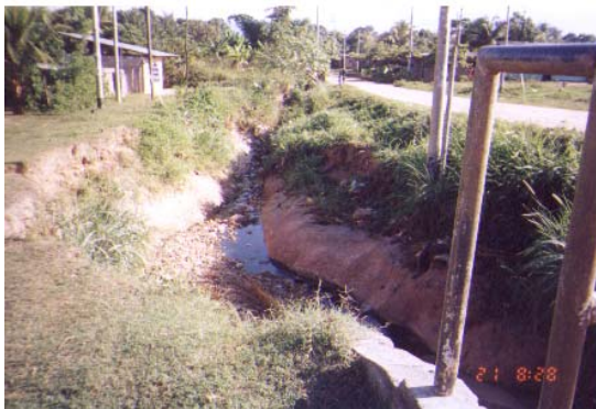
F-10: Sector Atumpampa, parte baja de la ciudad, dren pluvial, observándose erosión en todo su recorrido
