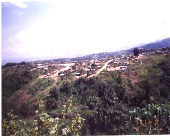
F-13: Asentamientos Humanos ubicados al borde de la quebrada El Choclino, sin tener un limite de ocupación definitiva. (La Banda de Shilcayo)
