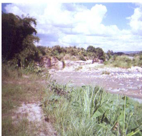
F-19: Obsérvese en la parte baja de la ciudad, el río Shilcayo, donde no existe ningún tipo de protección, ocasionando desbordes en época de crecidas.
