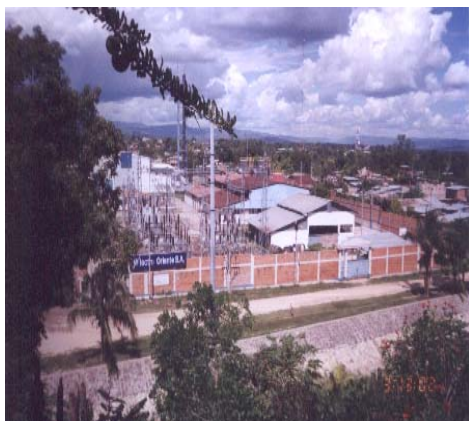
F-6: Electro-Oriente SA, es la empresa encargada del suministro de energía eléctrica.
