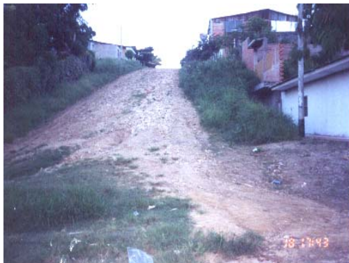
F-9: Barrio la Hoyada (Tarapoto): Nótese el estado actual de las calles sin cunetas, las cuales se erosionan constantemente.
