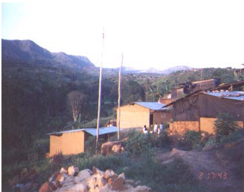
F-23 Asentamiento Humano La Victoria, ubicado en la parte alta de la ciudad. Se abastece por piletas de agua. No cuenta con servicios de desagüe. (La Banda de Shilcayo)
