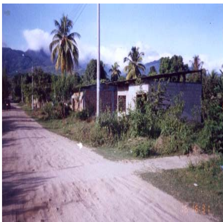
F-11: Viviendas que se inundan debido a su ubicación en la depresión existente. (Distrito de Morales)
