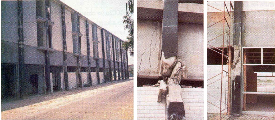
Fig. 6.12. Daños por "columna corta".
