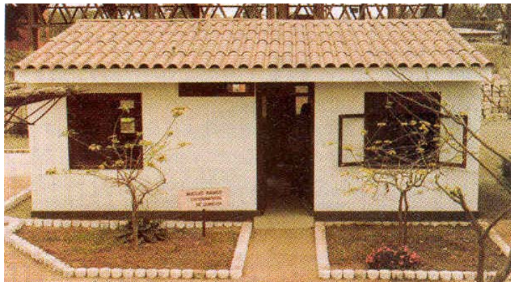
Fig. 6.6. Casa modelo de quincha construida en ININVI.
