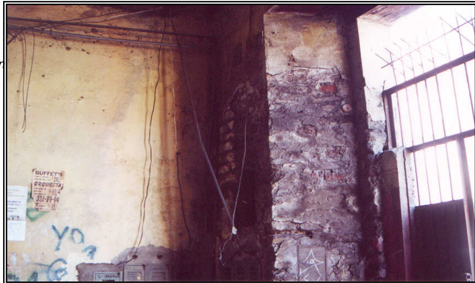
Cables de conexión eléctrica y tuberías de agua a la intemperie
