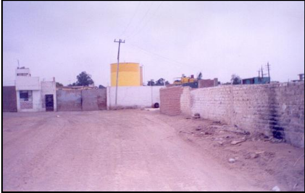
Foto 31: Frontis de planta de tratamiento de aceites comestibles de R y R. Oil Internacional donde se aprecia los tanques de almacenamiento de aceite.
