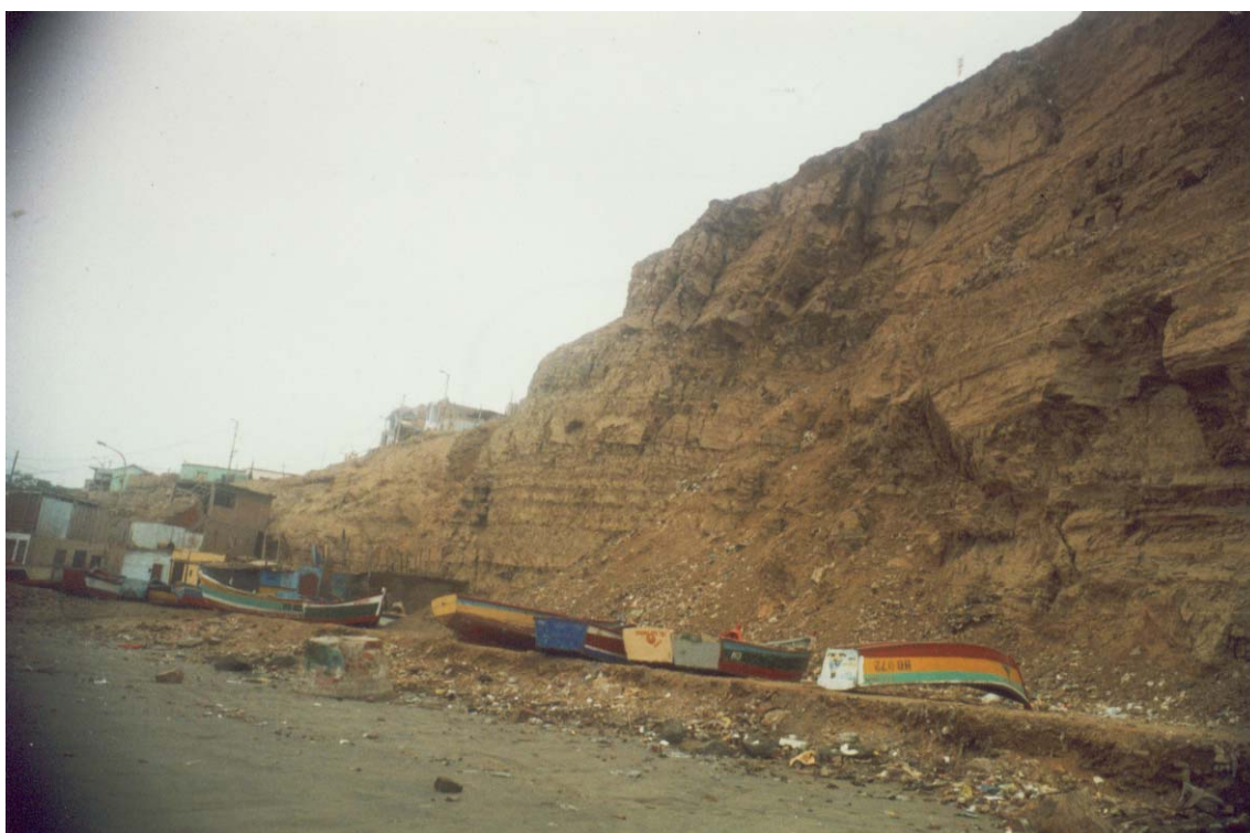
Foto 11: Roca sedimentaria en Punta La Viuda (Puerto de Huacho), muy fracturada, con desprendimiento por descompresión y más aún por sismo importante.
