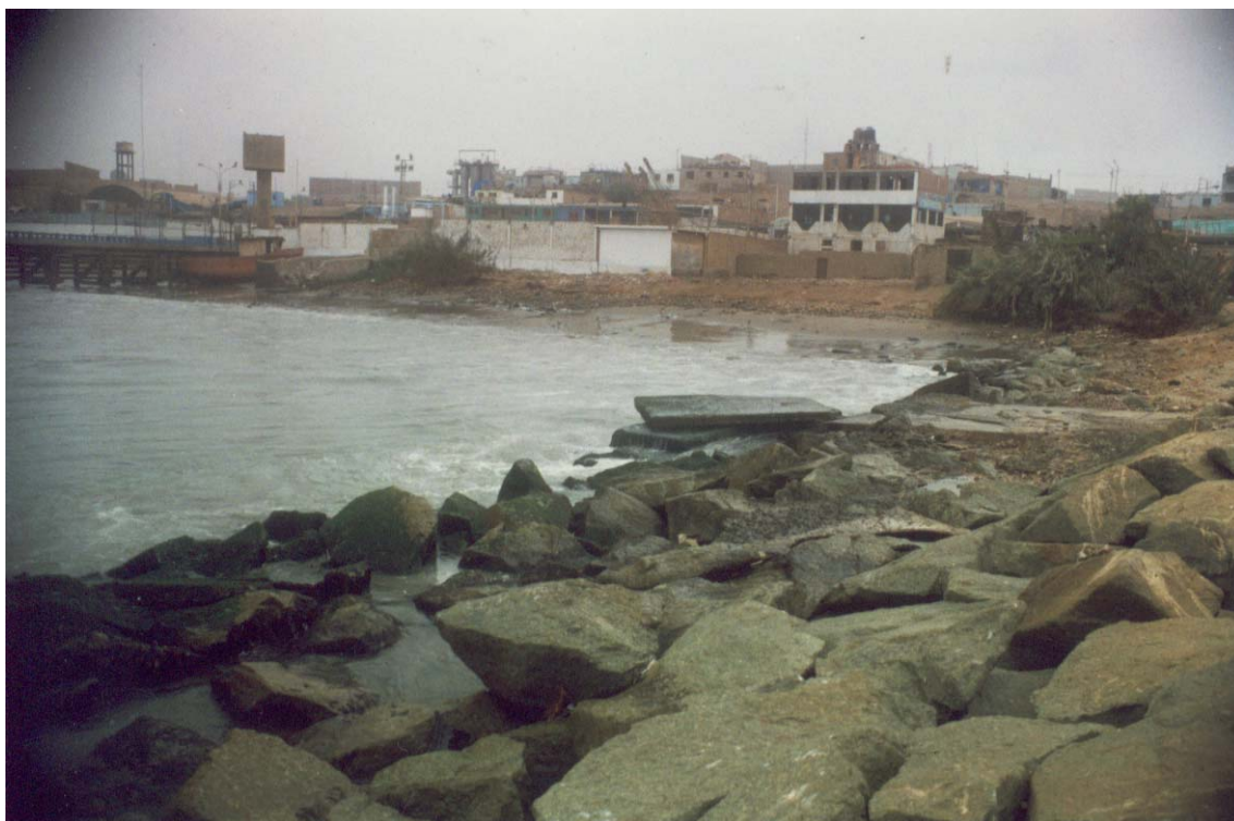
Foto 12: Enrocado en el lado sur de la bahía de Huacho, para evitar la erosión del talud por oleaje permanente.
