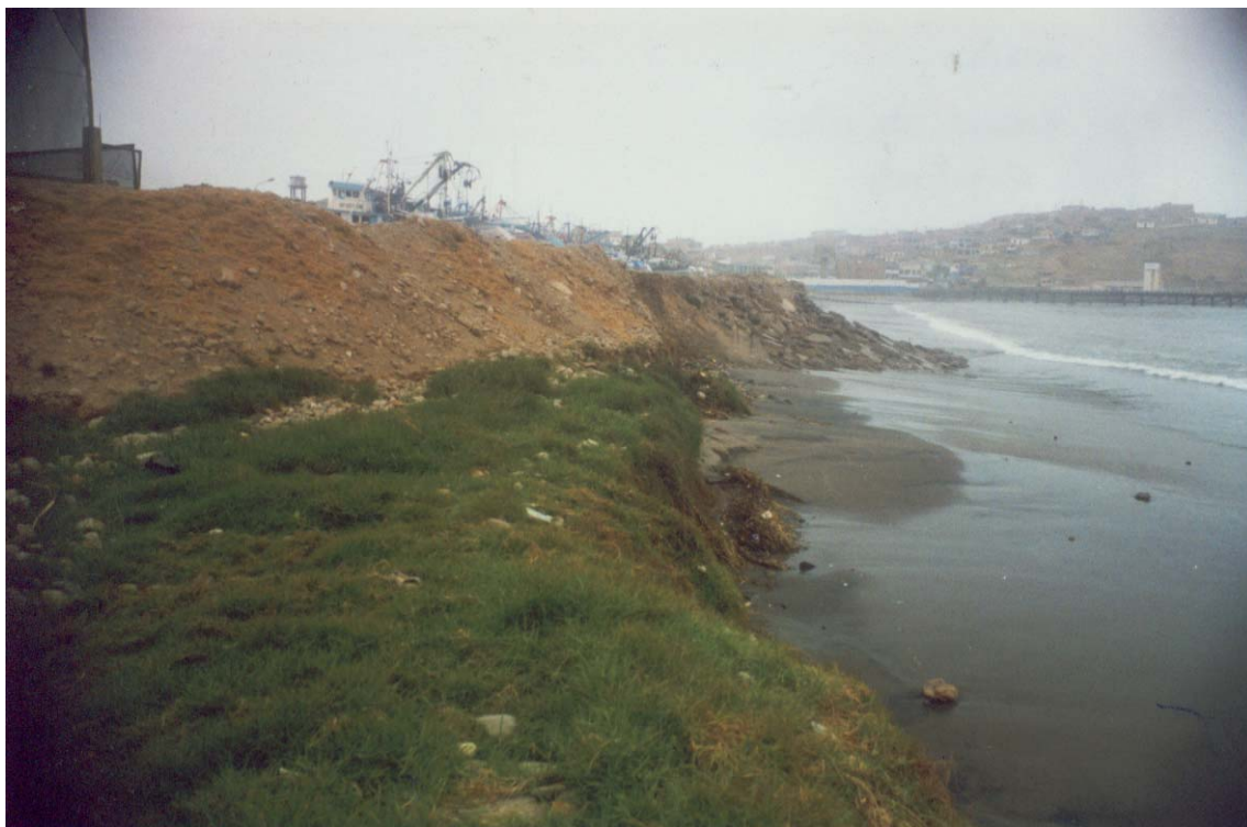
Foto 16: Material de relleno en la playa frente a la Capitania. Erosiona con oleajes del mar.
