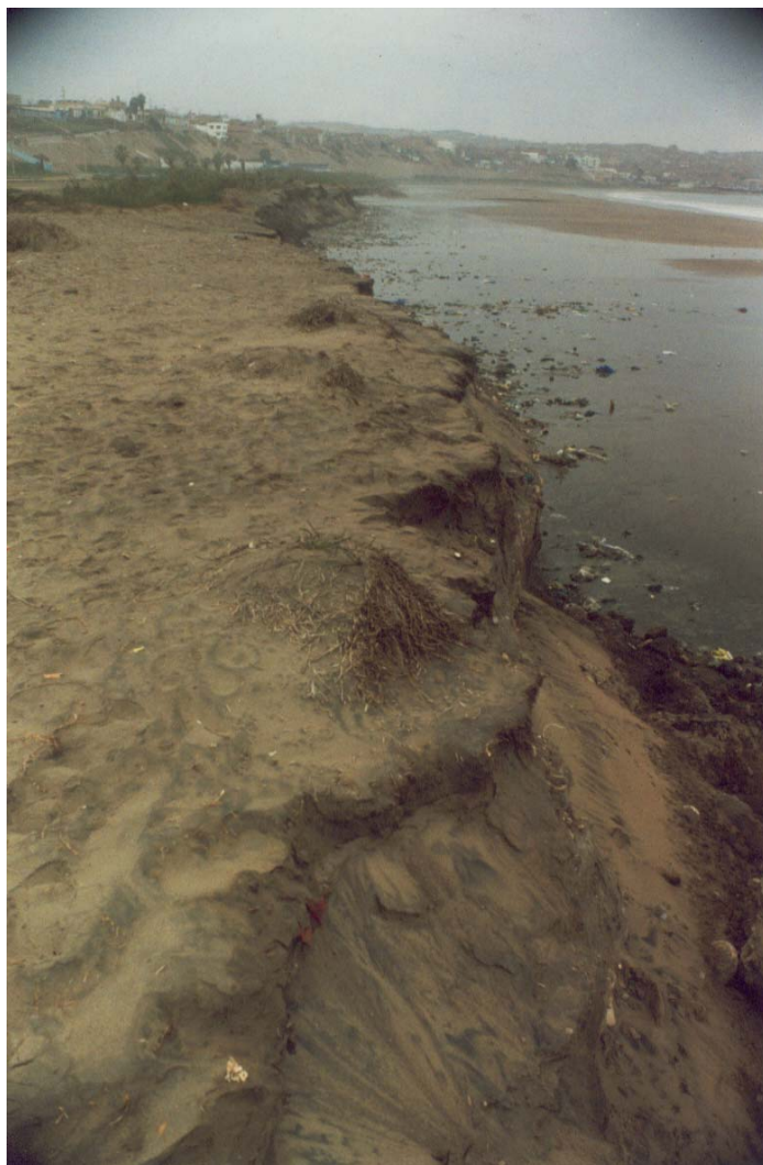
Foto 16: Material de relleno en la playa frente a la Capitania. Erosiona con oleajes del mar.
