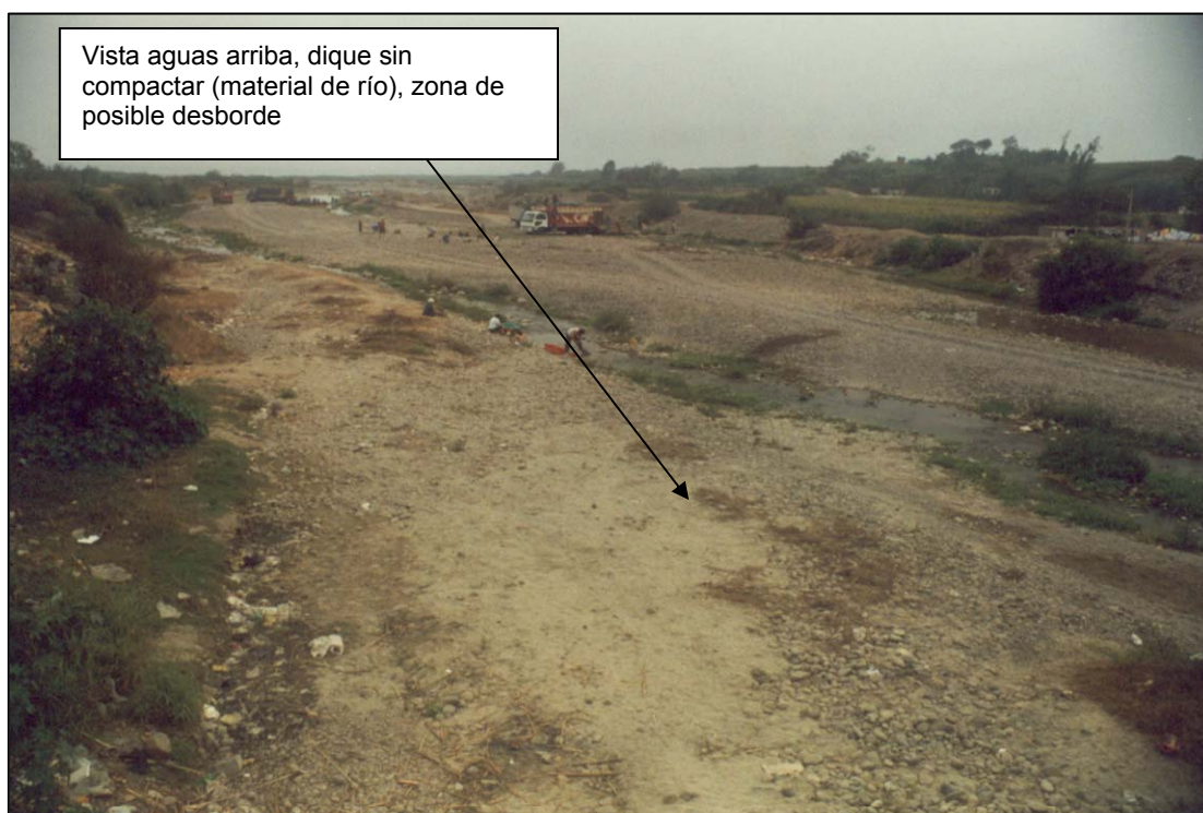
Foto 24: Lecho del río Chancay
