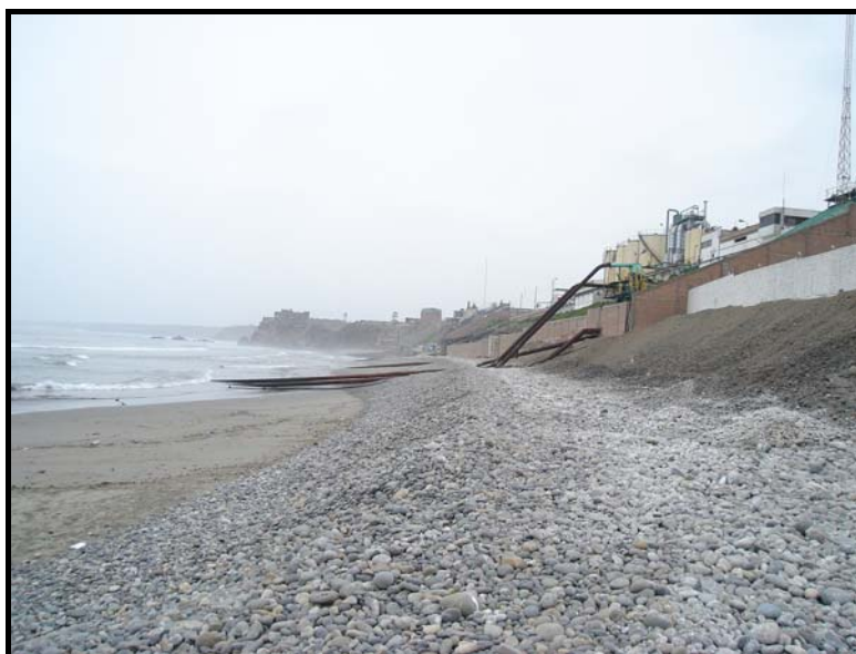
Foto 26: Empresas Pesqueras ubicadas en la zona del litoral de Chancay.
