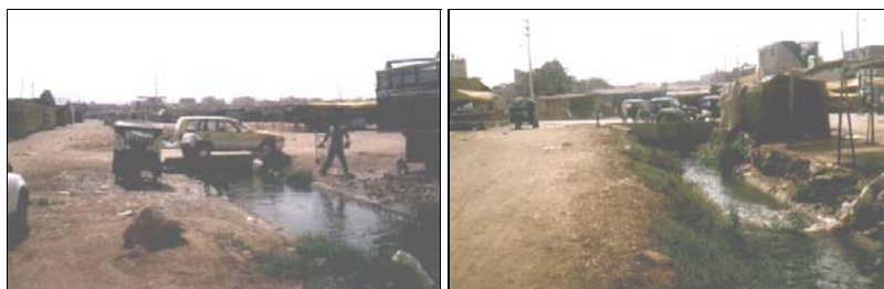
Izquierda. Canal María Angola a la altura del mercado central, el uso inadecuado del canal. Derecha. Canal María Angola aguas arriba del cruce con la Av. San Leonardo. Se observa la acumulación de desechos propios de las actividades del mercado en la margen derecha del canal.
