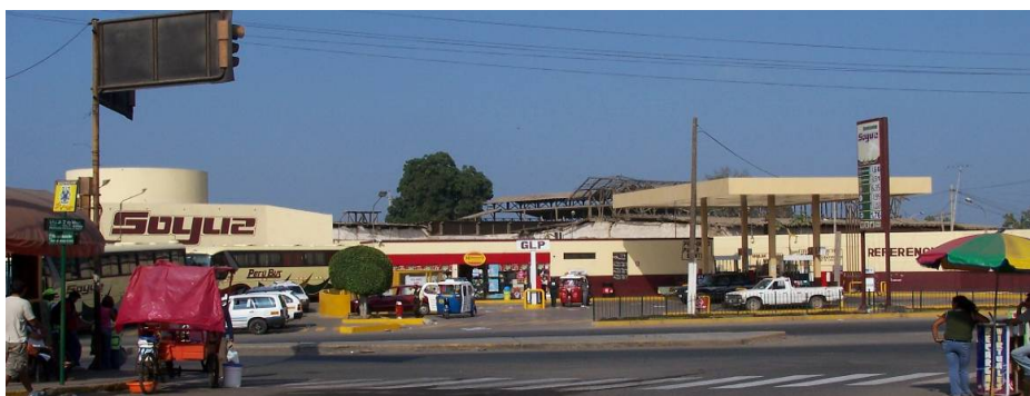
Grifo y Terminal Terrestre Soyuz, sobre la Carretera Panamericana Sur
