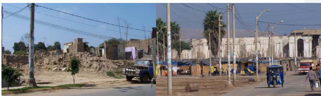
Viviendas destruidas en San Vicente
