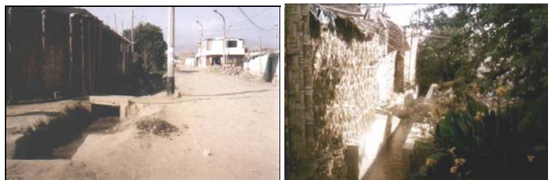
Izquierda. Canal Lateral de segundo Orden L2 Osco, en la Av. La Mar, se observa el canal muy cerca de edificaciones. Derecha. Canal L2 Osco, a la espalda del mercado Ramos Larrea. Se observa el canal revestido.
