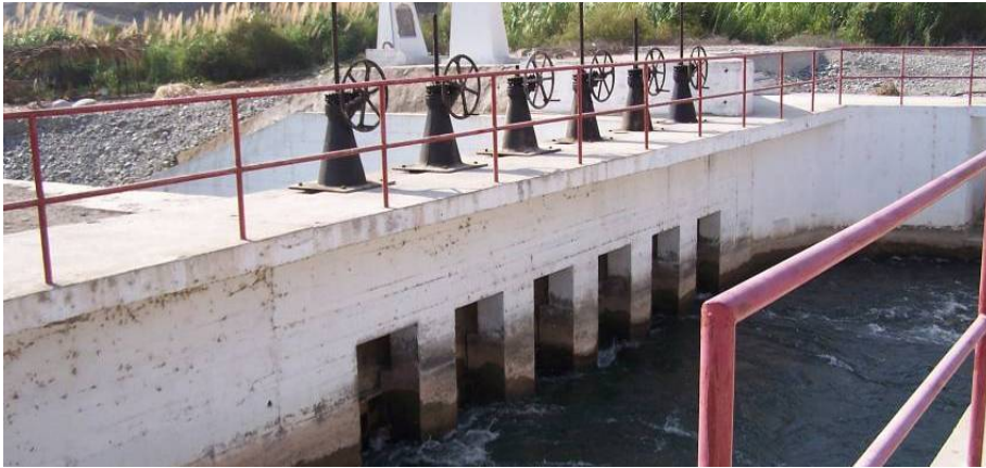
Bocatoma cerca del puente Socsi
