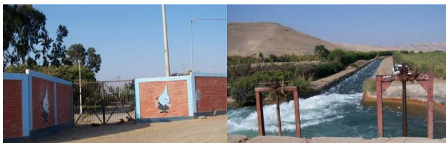
Planta de tratamiento de Alminares
