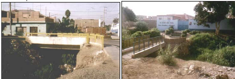
Izquierda. Cruce de la Quebrada Pócoto con la Calle Garro (Puente Garro) en la Ciudad de San Vicente. Derecha. Quebrada Pócoto en su paso por la ciudad de San Vicente.
