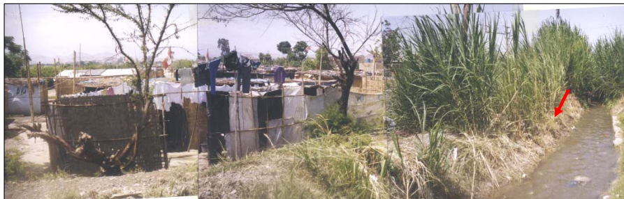
Canal L1 Granja en el tramo final de su recorrido por la ciudad de Nuevo Imperial (En la calle S/N). Observa nuevos asentamiento humanos en la margen derecha del canal.
