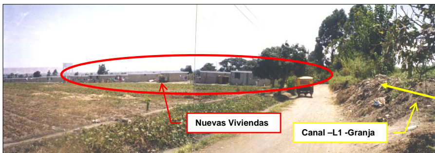
Canal L1 Granja en el tramo final de su recorrido por la ciudad de Nuevo Imperial (En la calle S/N). Se observan nuevas lotizaciones en terrenos agrícolas. El Canal L1 Granja a la derecha tiene una cota superior al de las viviendas nuevas.
