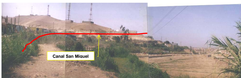
Canal San Miguel en la falda del Cerro Candela, rodeando a Asentamientos Humanos; en la parte inferior se muestra el parte de la Ciudad San Vicente.
