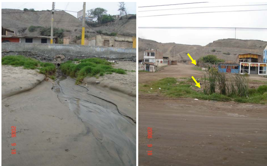
Figura N° 6.2.1-2 A la izquierda se observa una descarga libre de desagüe en el mar, a la derecha, la ubicación de las cámaras de bombeo existentes.
