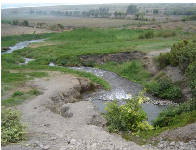
Figura N° 4.3.5-3 Manantial ubicado dentro de los terrenos de la comunidad Barranca, nótese el caudal, las dimensiones del cauce y las evidencias de que el flujo desarrolla velocidades erosivas.
