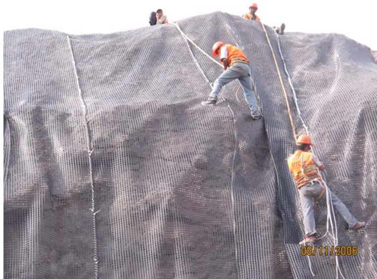
Figura N° 6.2.1-1 Disposición de geomallas en taludes
