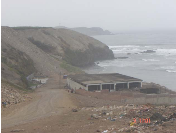
Foto 1. Barranca. Contaminación de Suelos y Océano desde el Camal La Chocoy.
