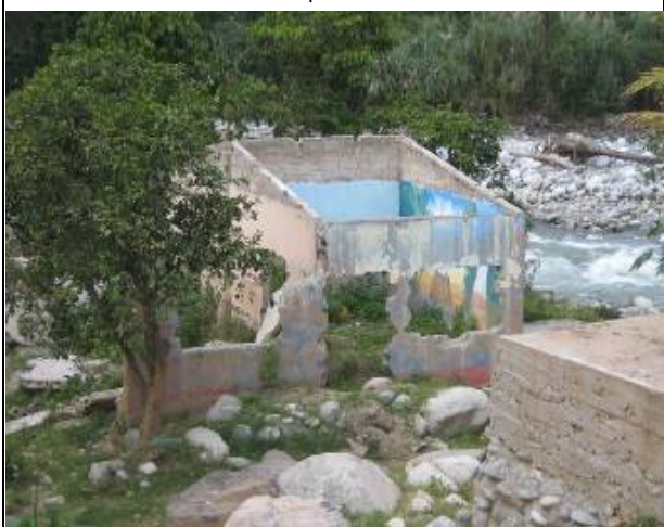
A.H. Malecón Tarma afectado por erosión fluvial del río Tarma y flujo de lodo y detritos de la Qda. Huacará. 22/01/2007
